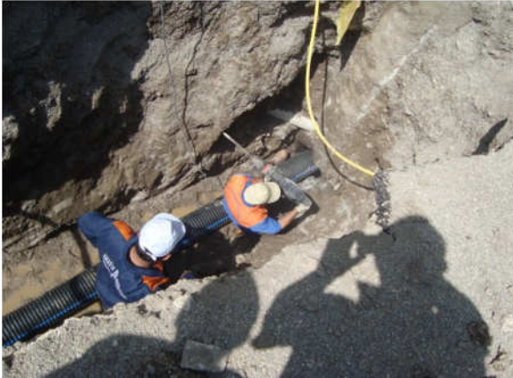
(55 Evler Mah. Kanalizasyon çalışması)
