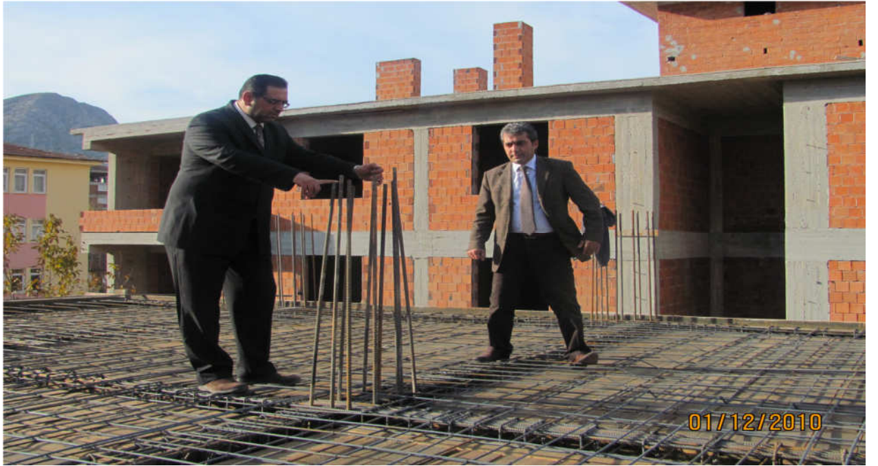
Yapımı devam eden ruhsatlı yapıların normal kat vize işlemlerinden beton atılması.
