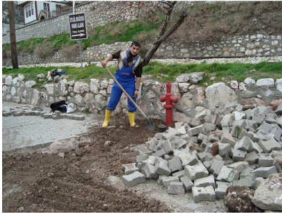
( Yangın vanası yapımı
