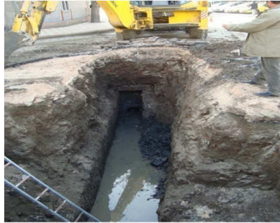
(Şeyhcui Mah. Yağmur suyu hat çalışmaları)
