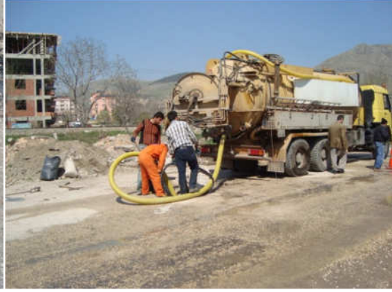
(Kanalizasyon baca temizliği)(Şeyhcu Mah.Kanalizasyon hat temizliği)
