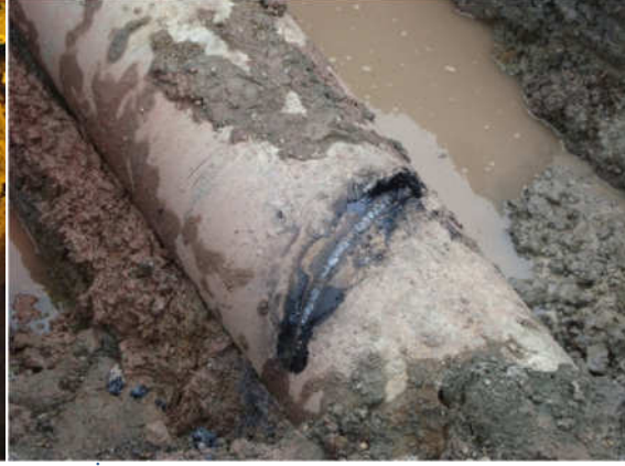
İçme suyu çelik boru tamirâtı
