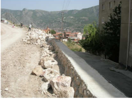
Afet Evleri Taşduvar Yapımı
