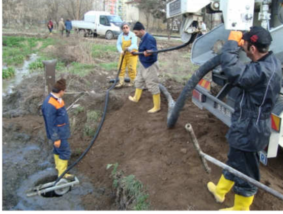
Kanalizasyon hat temizliği
