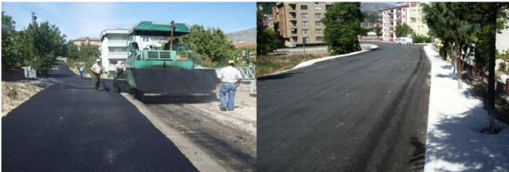
Akbilek Mh.asfalt çalışmaları
