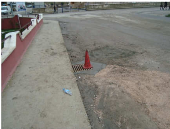
(Yağmur suyu ızgara tamiratı )(Kanalizasyon hat temizliği)
