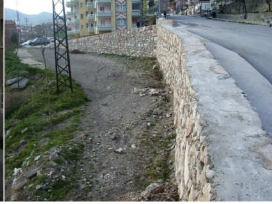
Güneş Sitesi önü taşduvar yapımı
