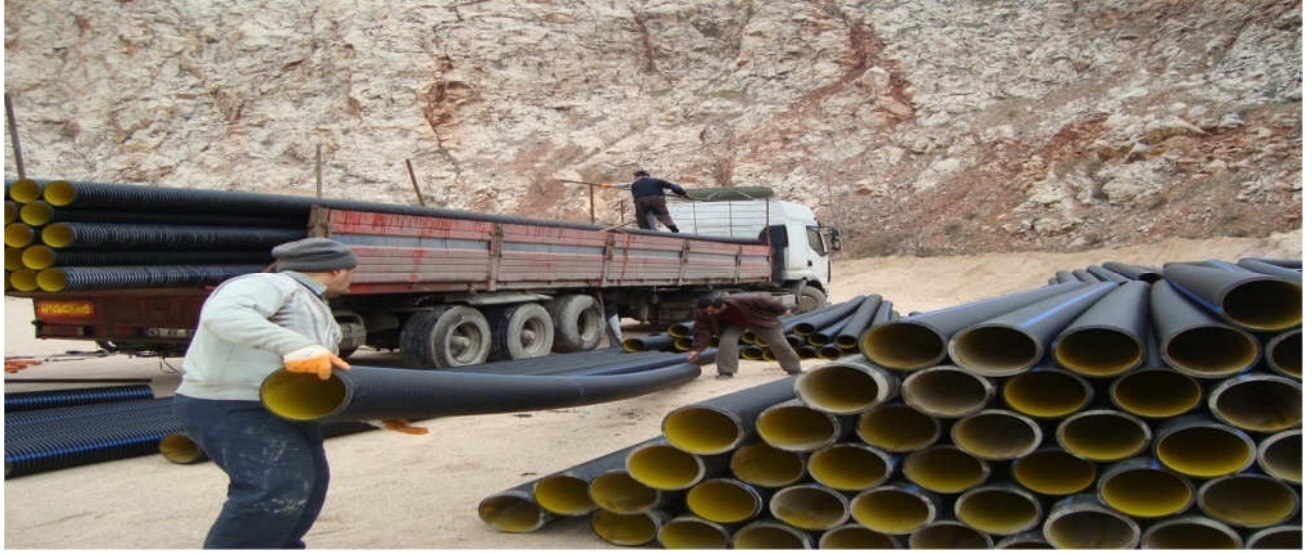
(Kanalizasyon ve yağmur suyu hat yapımında kullanılan boru malzemesi)
