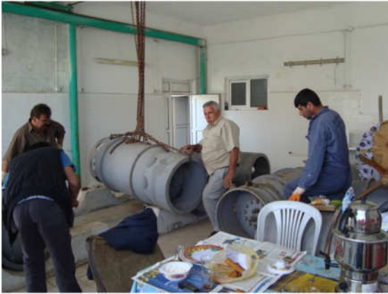
(İçme suyu klor depo bakım onarımı)(İçme suyu vana tamirâtı)
