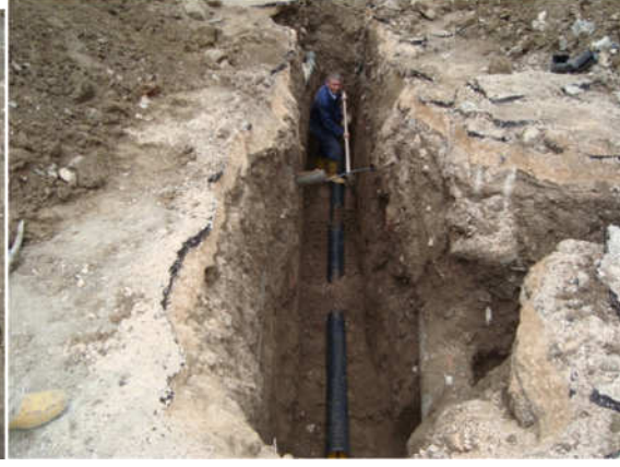
(55 Evler Mah. Kanalizasyon çalışması)
