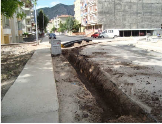
(Bahçeleriçi Yağmur suyu hat çalışması)( Bahçeleriçi Yağmur suyu hat çalışması)
