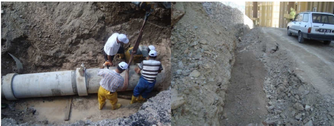
(Kirazlıdere Mah. İçme suyu hat çalışması) (Hızırpaşa Mah. İçme suyu hat çalışması)
