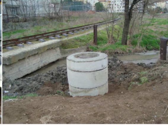
Kanalizasyon baca onarımı
