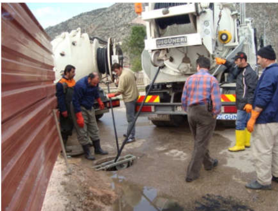
(Hacılar meydanı Kanalizasyon temizliği)
