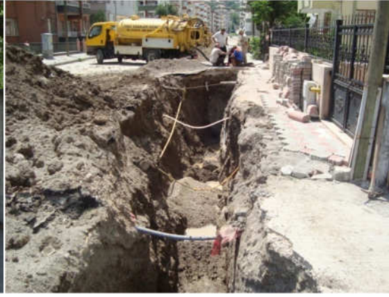
(Şeyhcui Mah. Yağmur suyu hat çalışmaları)855 Evler Mah. Yağmur suyu hat çalışma
