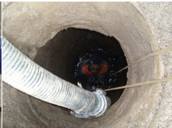
(Kanalizasyon baca temizliği)
