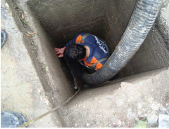
(Kanalizasyon baca temizliği)
