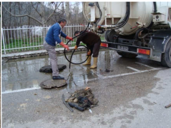
(Yağmur suyu ızgara tamiratı )(Kanalizasyon hat temizliği)
