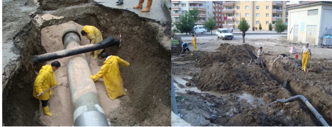
(Kirazlıdere Mah. İçme suyu hat çalışması )( 55 Evler Mah. İçme suyu hat çalışması)
