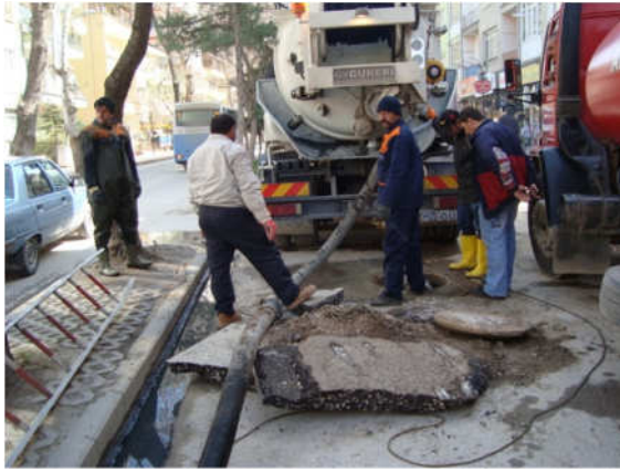
(Hızırpaşa kanalizasyon hat temizliği)(HacılarMeydanı Kanalizasyon hat temizliği)
