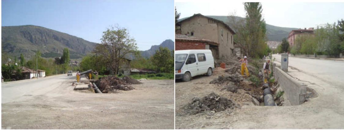
(Akbilek Mah. Yağmur suyu hat çalışması) (Akbilek Mah.Yağmur suyu hat çalışması)
