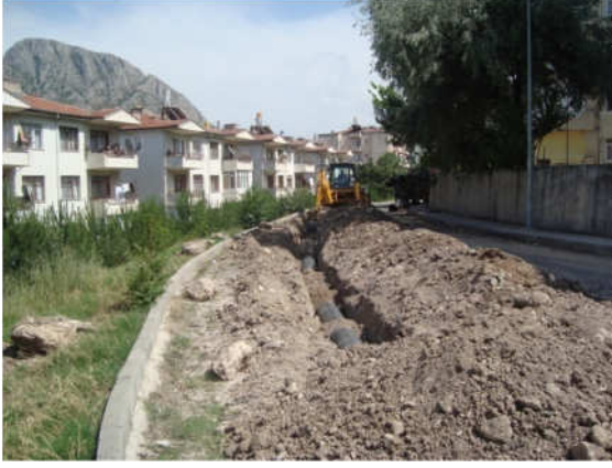
(Şeyhcui Mah. Yağmur suyu hat çalışmaları)
