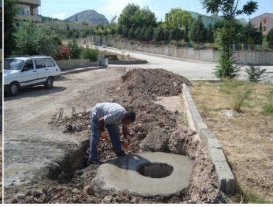
(Şeyhcui mah. Yağmur suyu hat çalışmaları)
