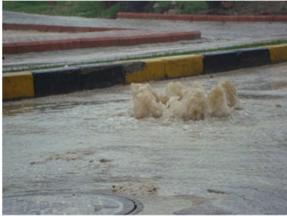
(Yağmur suyu baca taşkını)(Yağmur suyu ızgara tamiratı)
