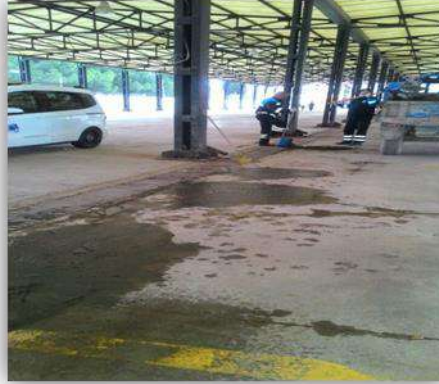
KAPALI PAZAR YERİ TEMİZLİK ÇALIŞMASI (50. YIL MAHALLESİ)
