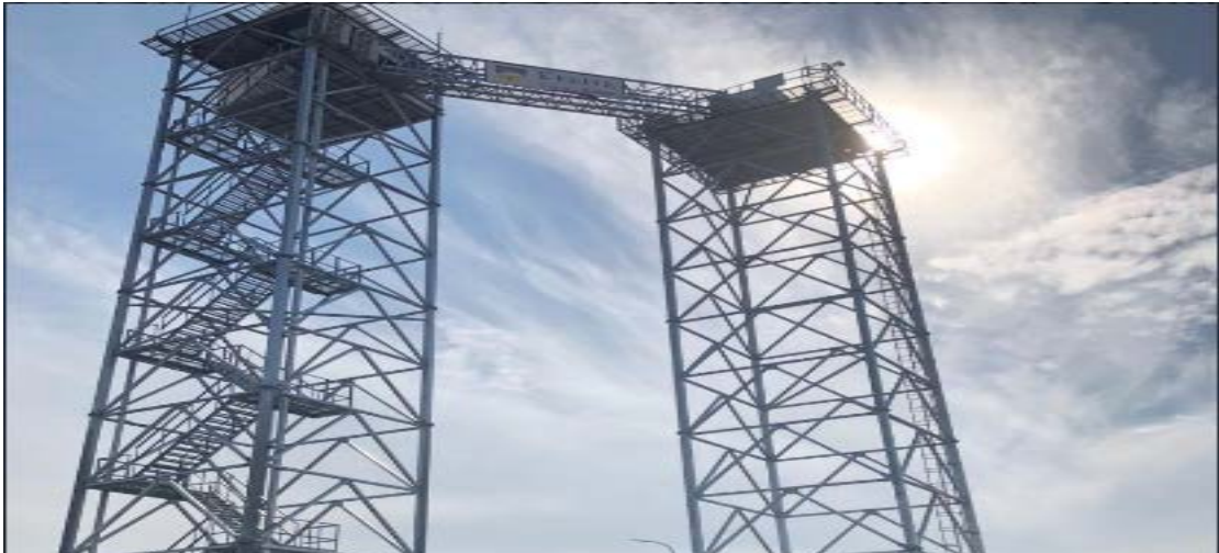
Şekil 8: Alçak Seviye Rüzgâr Kırılımı Uyarı Sistemi
