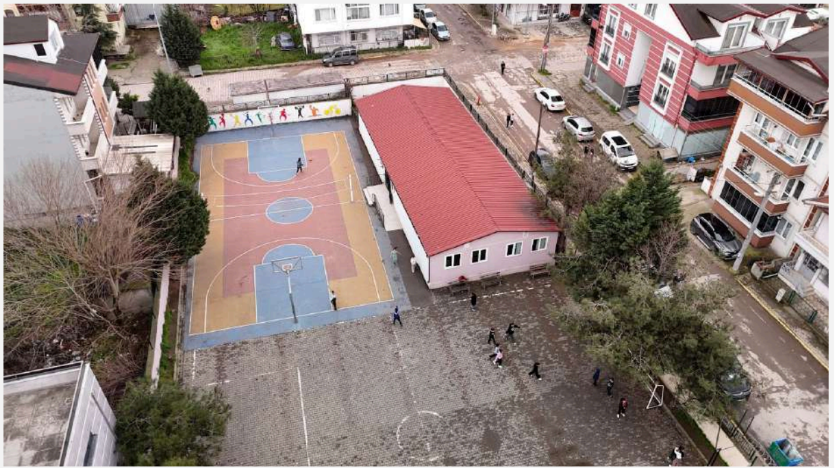
İstasyon Ortaokulu Ek Derslik/İstasyon Mahallesi
