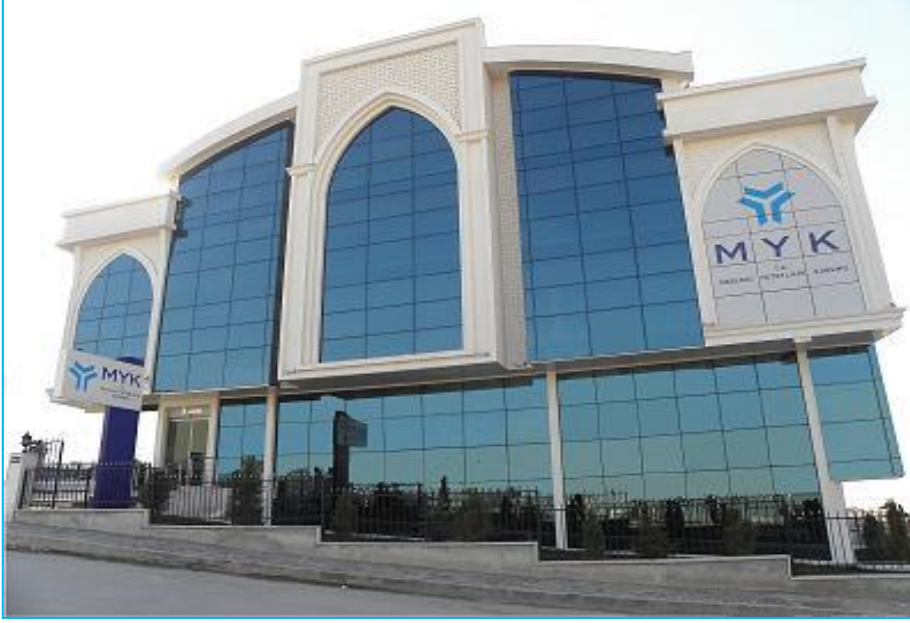
Resim 1 : MYK Hizmet Binası
