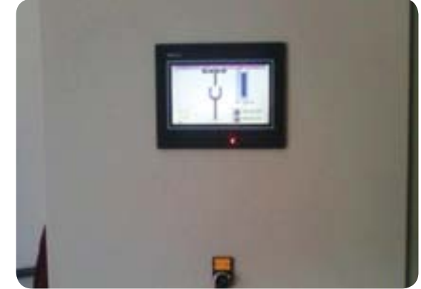
Terfi İstasyonu SCADA RTU Panosu
