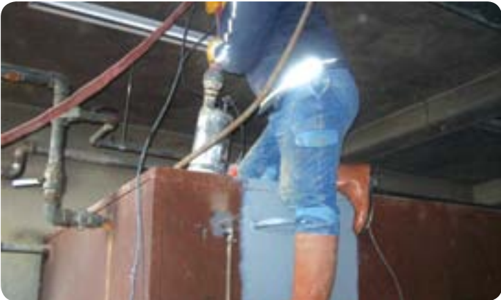
2011 Yılı Eylül ayı içerisinde Karatay İlçesindeki arıza-dan dolayı 75 adet site su deposunun ücretsiz olarak temizlik ve dezenfektasyon çalışması yapıldı.
