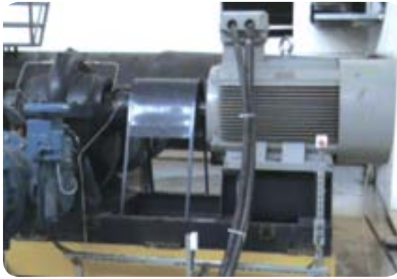
Barsana Pompa İstasyonu pompa revizyonu
