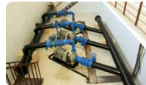
Buzlukhanı Pompa İstasyonu eski hali
