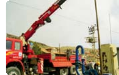
Pompa montaj anı
