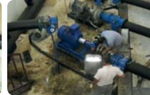
Pompa istasyonlarının bakım ve revizyon çalışmaları (Yazır Pompa İstasyonundan bir görüntü)
