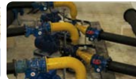
Buzlukhanı Pompa İstasyonu yeni hali
