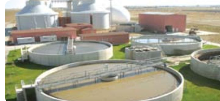
Çamur Yoğunlaştırıcılar, Çürütücüler, Gaz Balonları ve Susuzlaştırma Ünitesi
