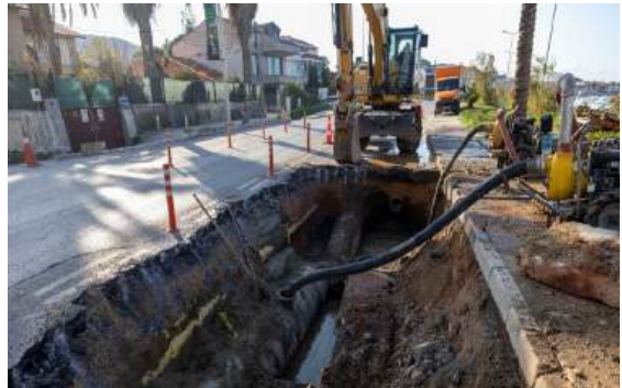
Mithatpaşa Caddesi Ana Boru Arızası Çalışması
