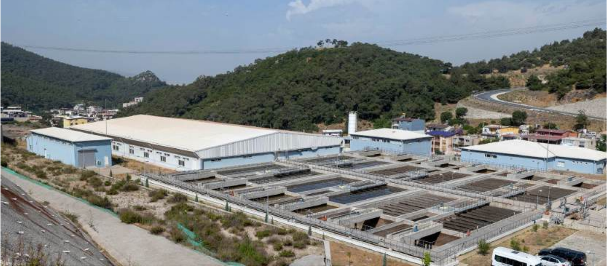
Kavaklıdere İçme Suyu Arıtma Tesisi
