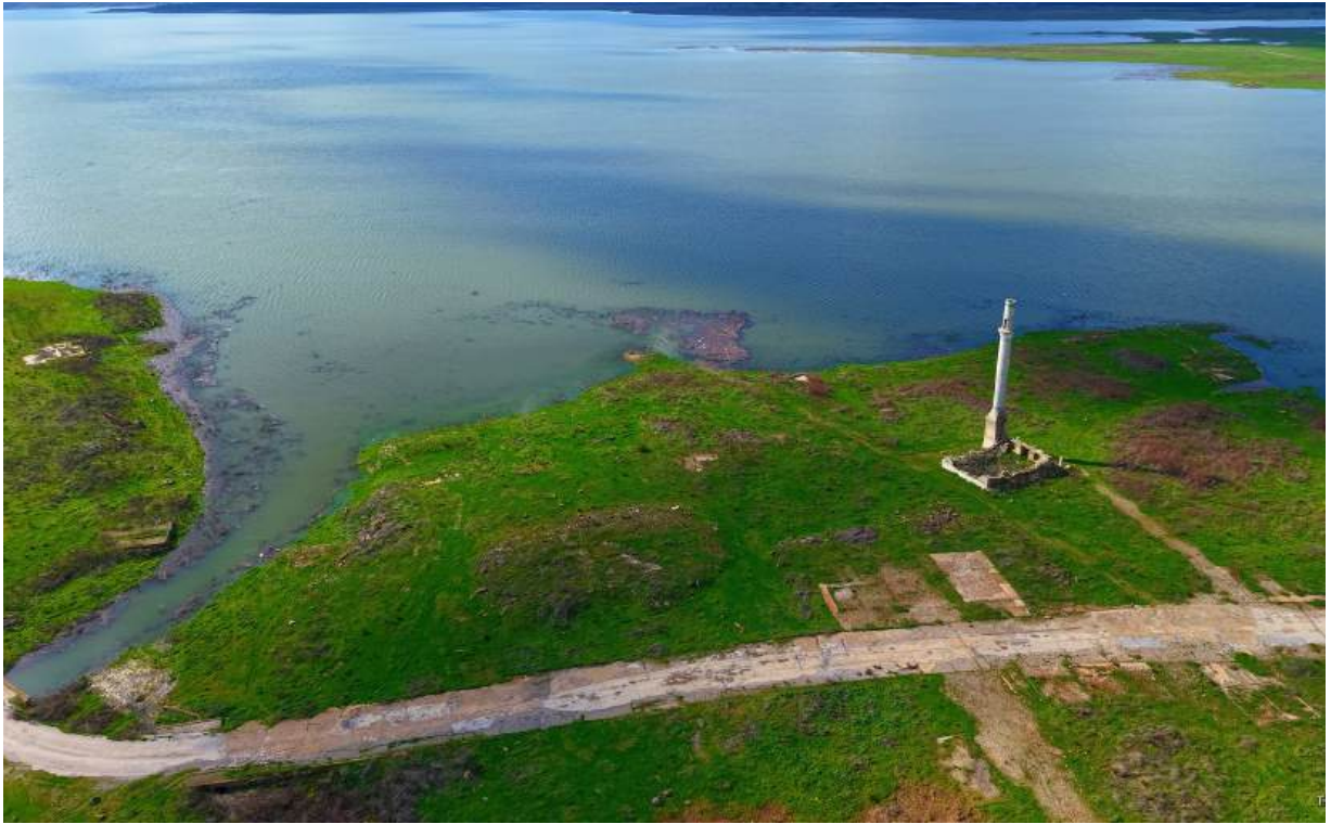
Tahtalı Barajı Drone Çekimi
