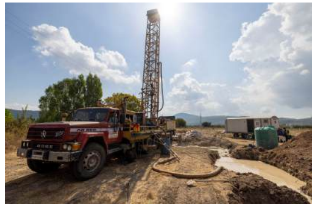
3. Bölge Su Sondaj Kuyusu Çalışmaları
