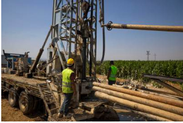
Tire Su Sondaj Kuyusu Çalışmaları
