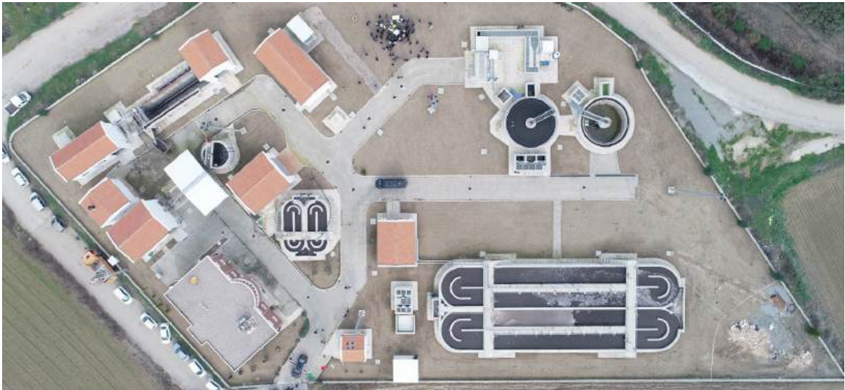
Bayındır Hasköy Atıksu Arıtma Tesisi Geri Kazanım Ünitesi
