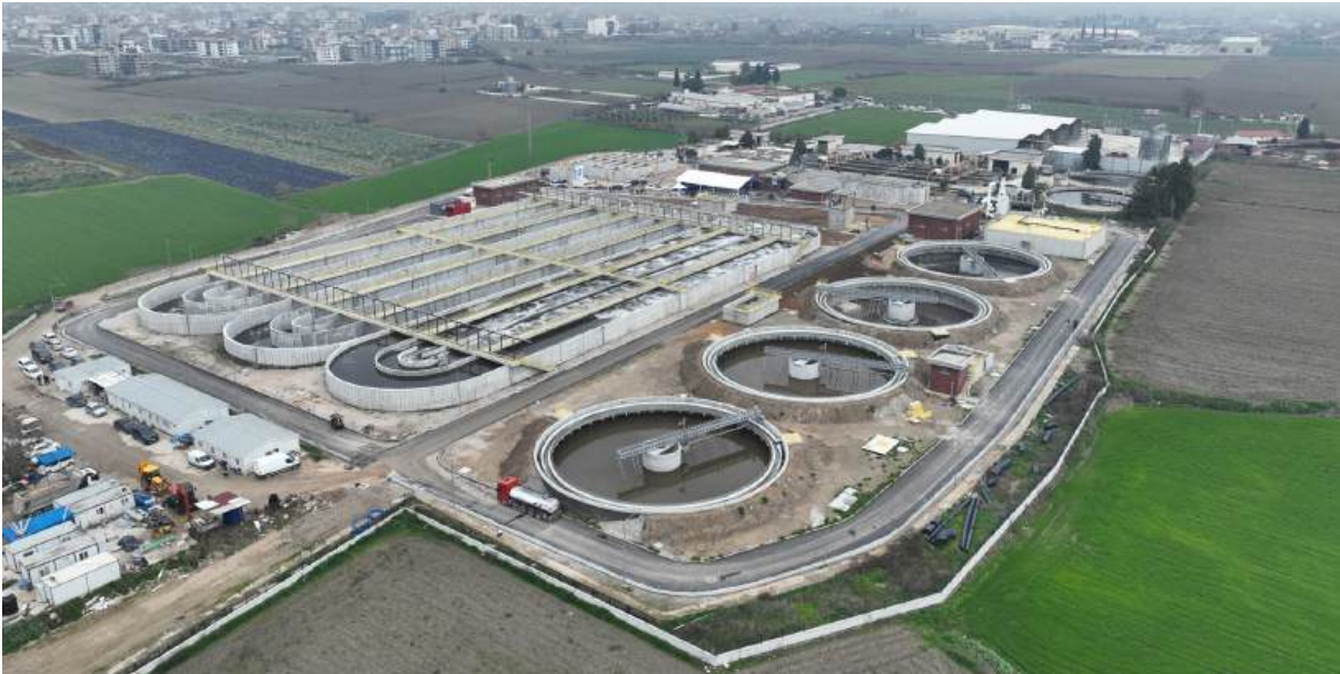
Torbalı Atıksu Arıtma Tesisi 2. Etap İnşaatı
