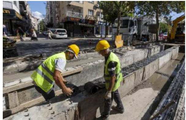
Sıralı Yağmur Suyu Izgarası Bakım-Onarımı
