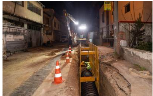
Bornova İlçesi Kazımdirik, Mansuroğlu, Ergene, Erzene ve Mevlana Mahallelerinde Yağmur Suyu ve Atıksu Şebeke İnşaatı İşi
