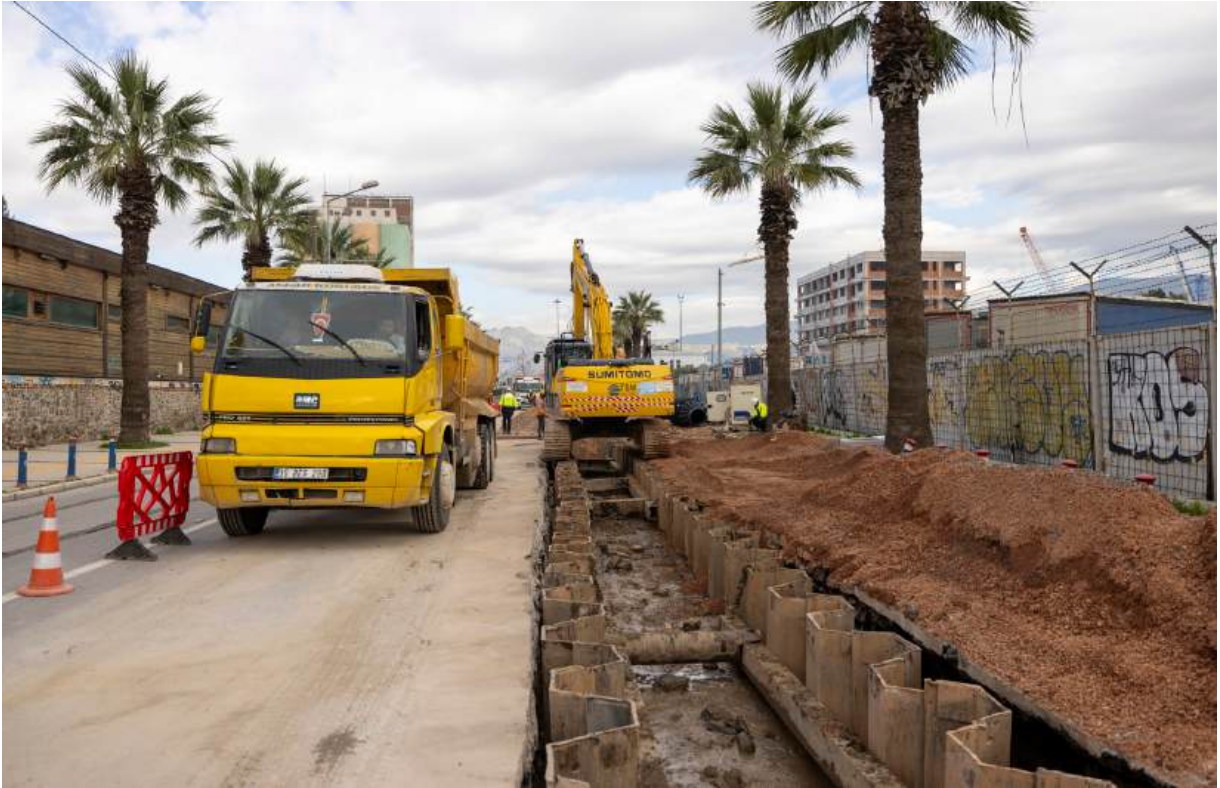
Konak İlçesi Ege Mahallesi (Alsancak Liman Bölgesi) Yağmur Suyu Şebekesi ve Kanalizasyon İnşaatı
