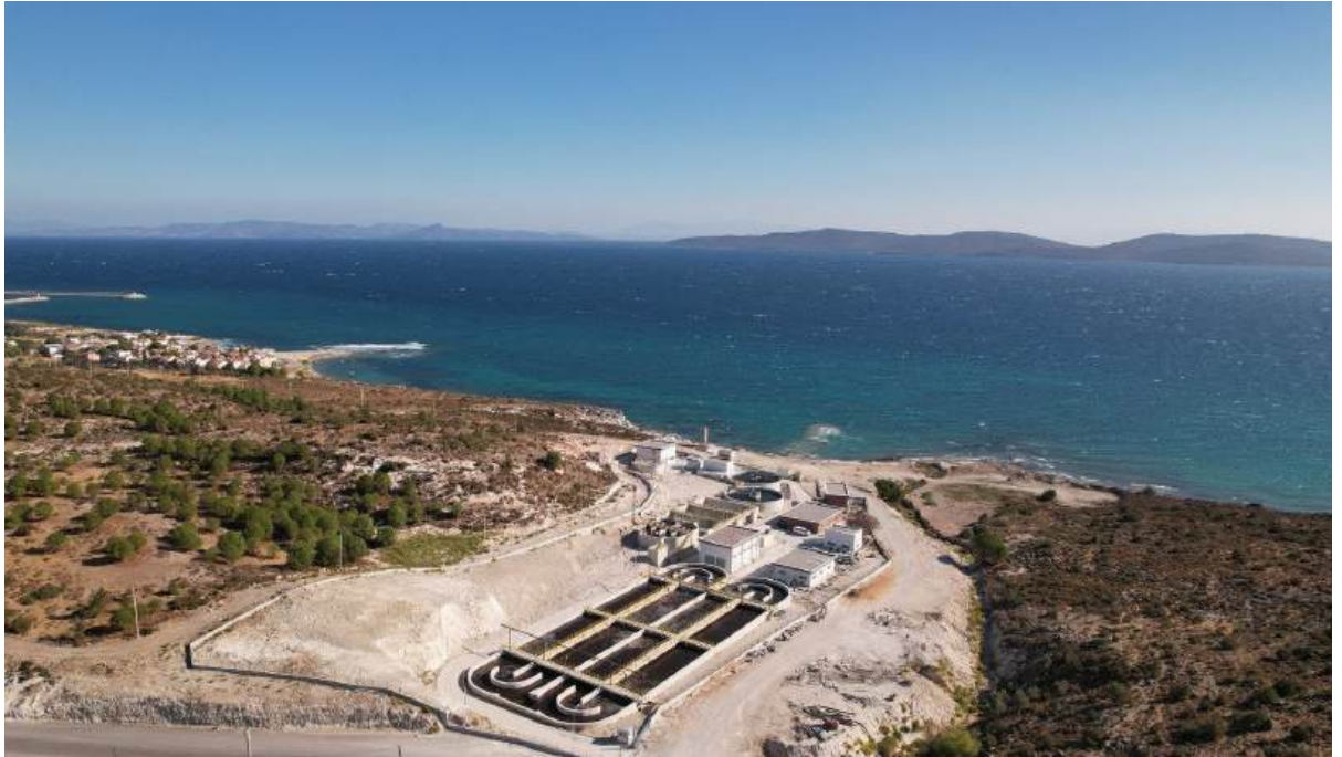
Mordoğan Atıksu Arıtma Tesisi
