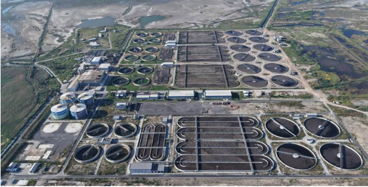
Çiğli Atıksu Arıtma Tesisi 4. Faz 2. İkmal İnşaatı
