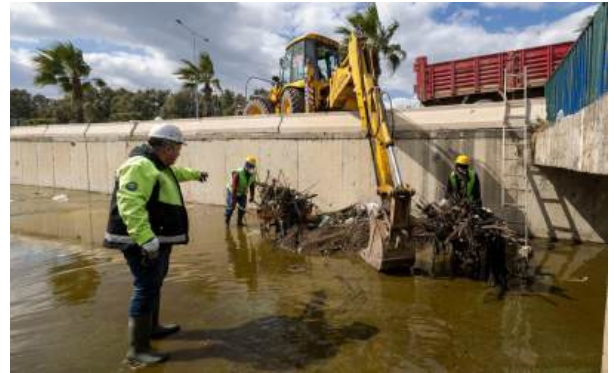
Karabağlar İlçesi Dere Temizliği Çalışması
