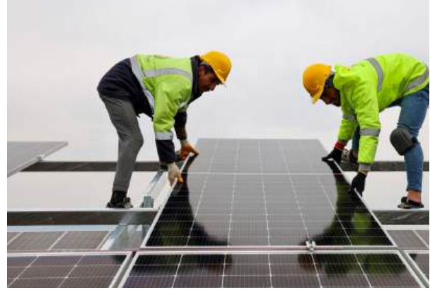
Menemen-Emiralem Boru Stok Sahası Çatı Tipi GES Projesi
