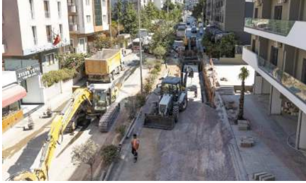
Buca İlçesi 60, 61 ve 63 Sokaklar ve Erdem Caddesi Atıksu ve Yağmur Suyu İnşaatı İşi
