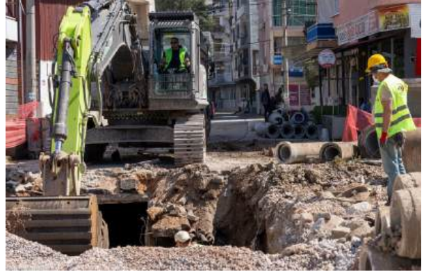
Bayraklı İlçesi Tepekule Mahallesi, Pazaryeri 2120/2 Sokak, Yağmur Suyu ve Atıksu Hattı İmalatı İnşaatı İşi
