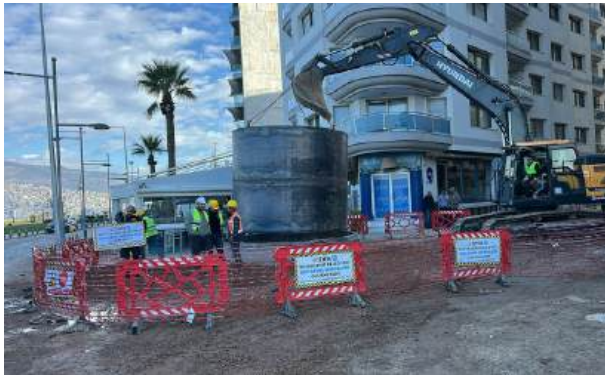
Konak İlçesi, Alsancak, Kültür ve Mimar Sinan Mahallelerinin Muhtelif Cadde ve Sokaklarında Yağmur Suyu ve Atıksu Hattı ile Terfi Merkezleri İnşaatı İşi
