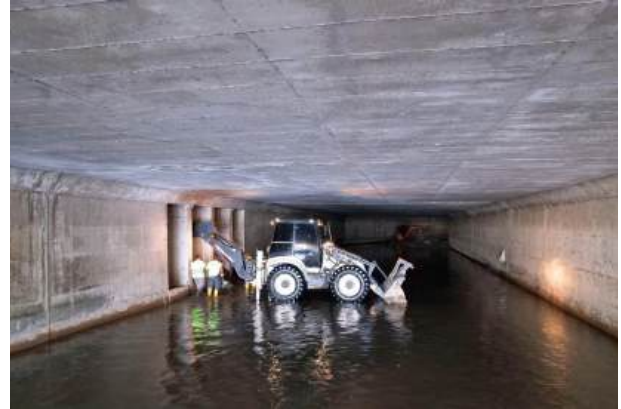
Bakım, Onarım ve Temizliđi Gerçekleřtirilen Galeri Mecra Hattı
