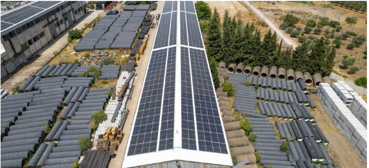
Menemen-Emiralem Boru Stok Sahası Çatı Tipi GES Projesi
