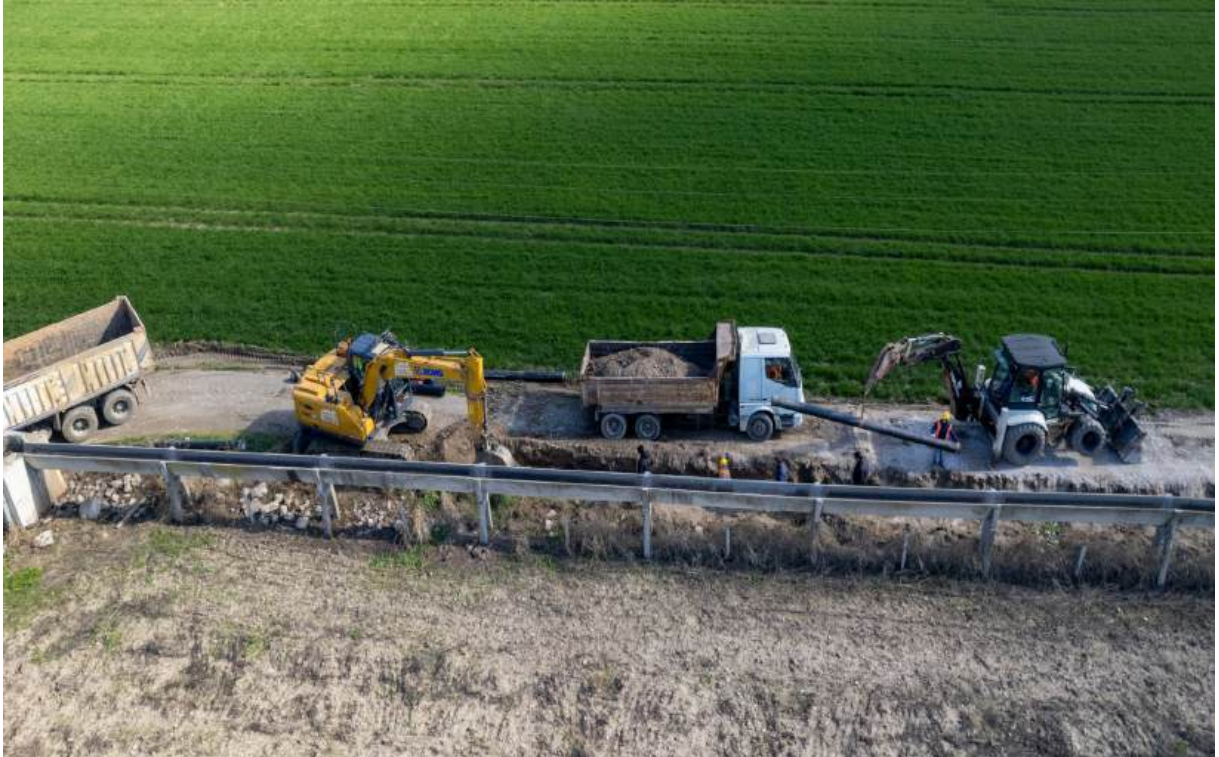
Menemen İlçesi Atıksu Hattı İmalatı
