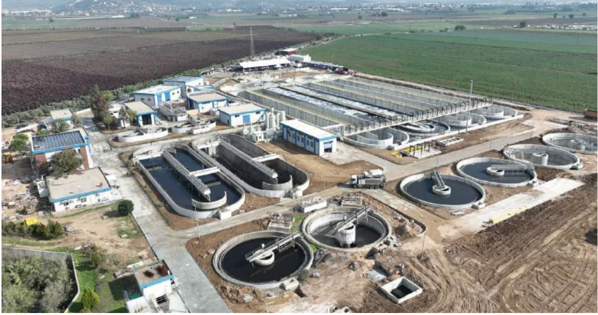
Torbalı Ayrancılar-Yazıbaşı Atıksu Arıtma Tesisi 2. Etap İnşaatı
