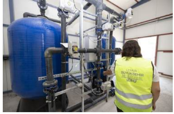
Ödemiş Sekiköy Paket İçme Suyu Arıtma Tesisi Kurulumu
