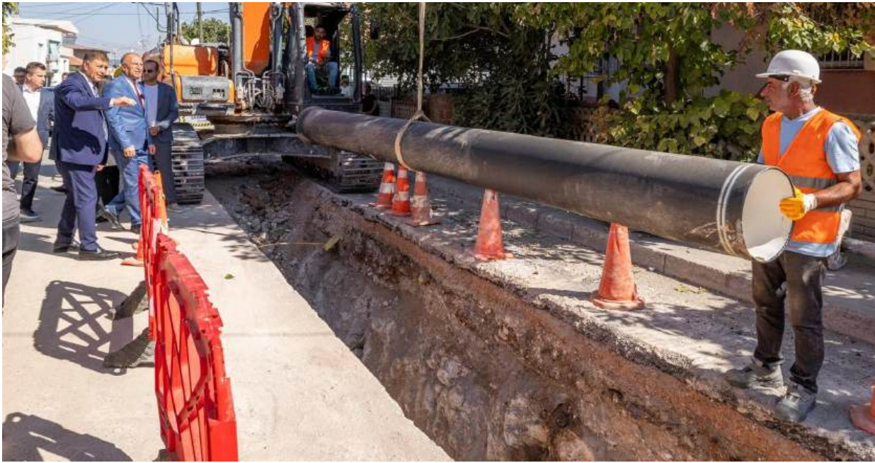
Gaziemir Sarnıç Bölgesi İçme Suyu Şebeke ve İletim Hattı İnşaatı
