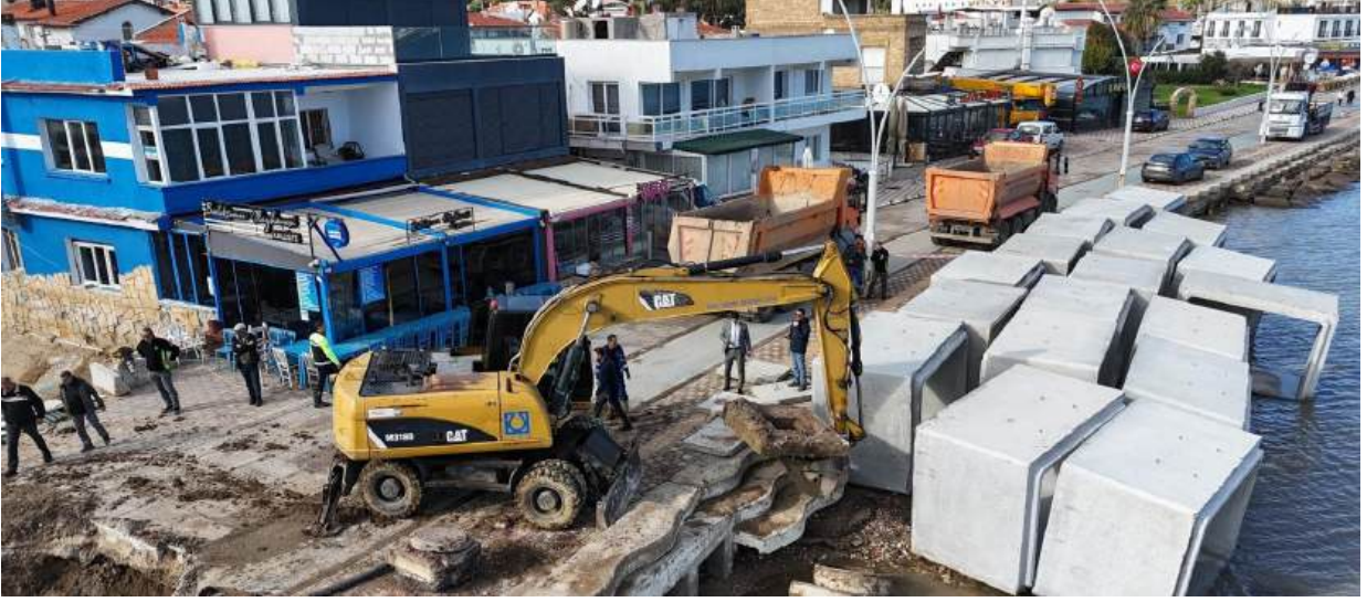
Foça İlçesi Dere Bakım Çalışması
