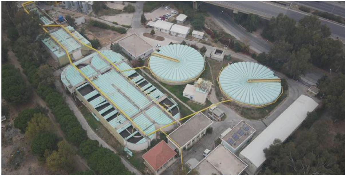
Güneybatı Atıksu Arıtma Tesis
