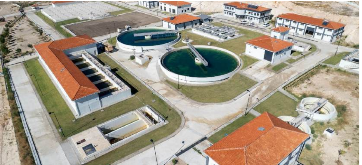
Foça İçme Suyu Arıtma Tesisi
