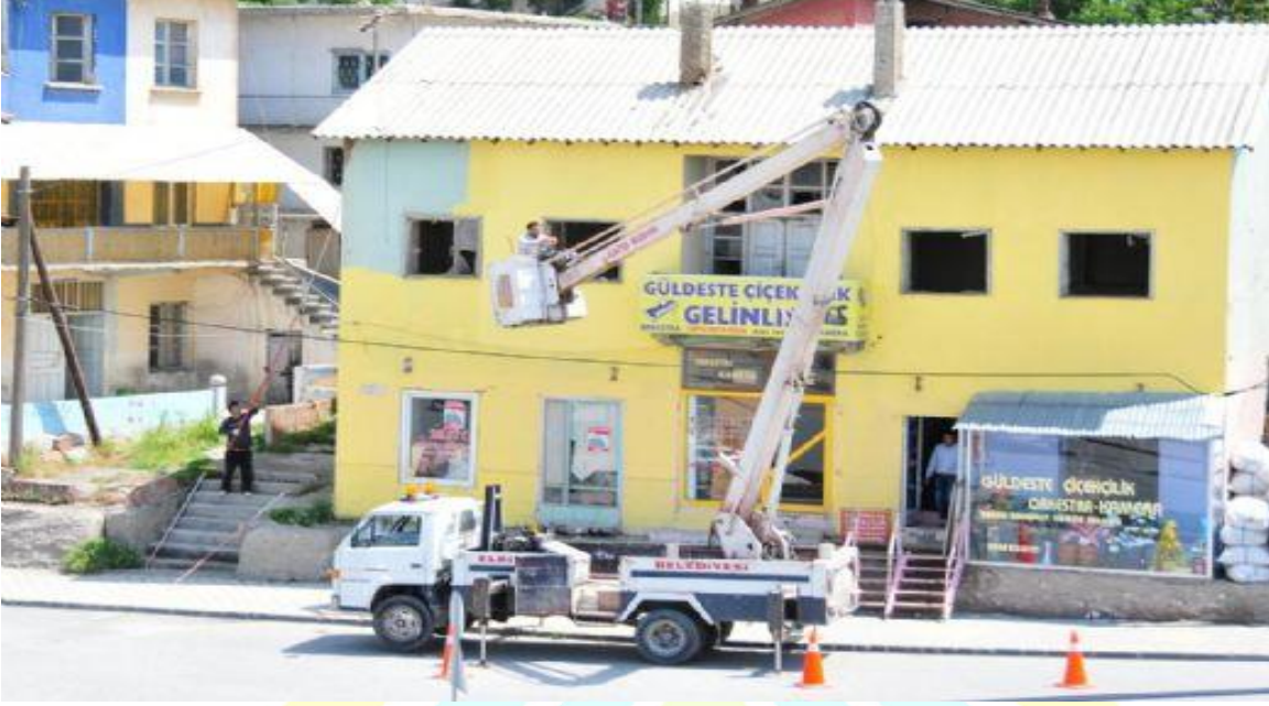
Resim 9. Bakımsız Evlerin Boyama Çalışmaları
