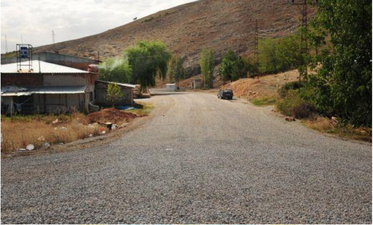
Resim 7. Gözyolu Mevkii Yol Çalışmaları
