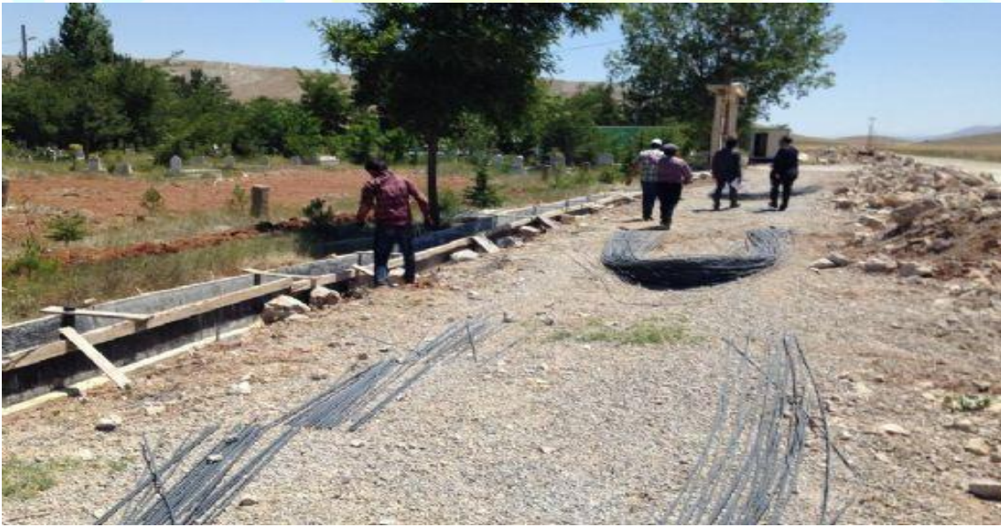
Resim 10. Asri Mezarlık cephe yenileme çalışmaları
