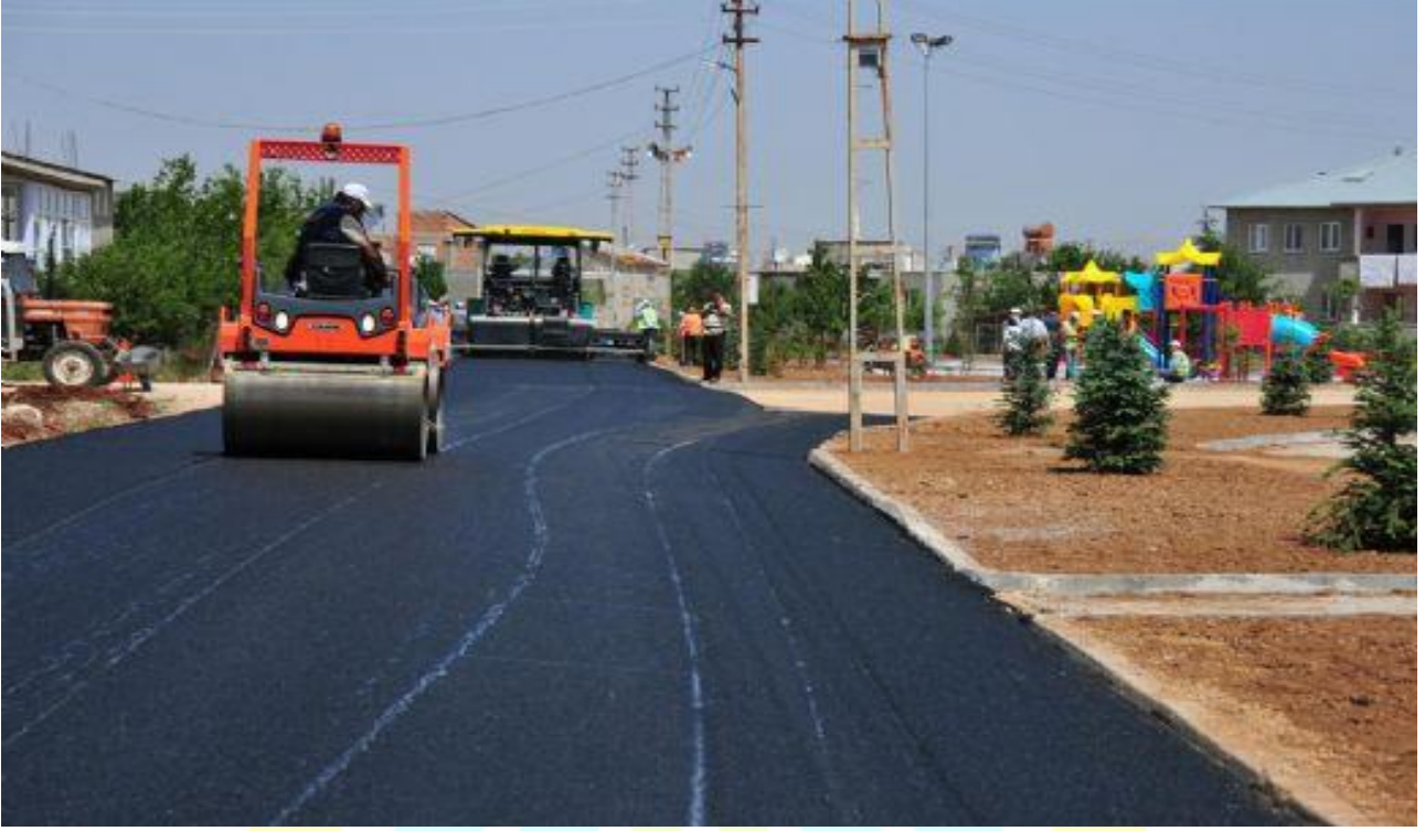
Resim 8. Alpaslan Mahallesi Yol Asfaltlama Çalışmaları
