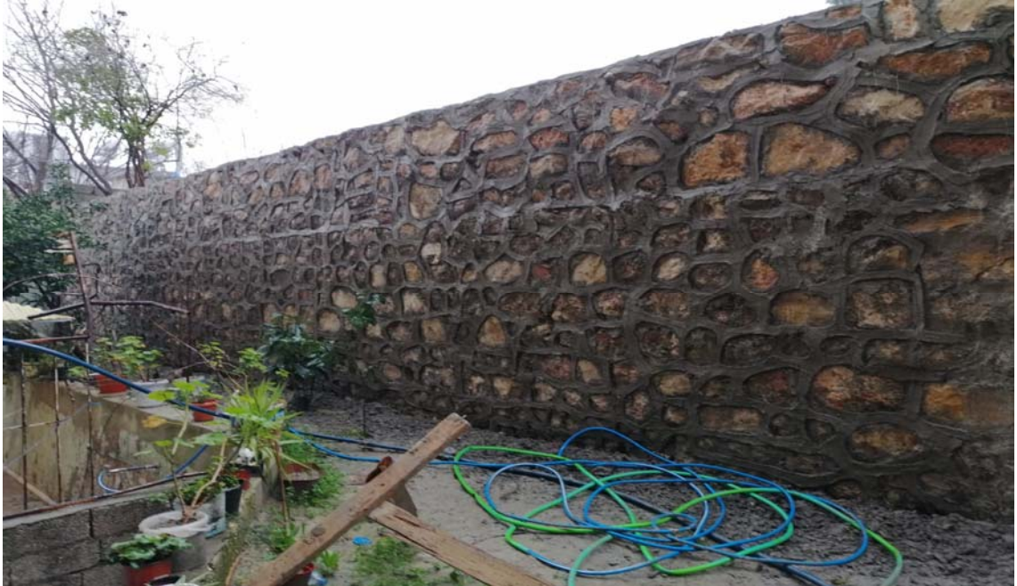
Kışlasaray Mahallesi Taş Duvar Yapımı
