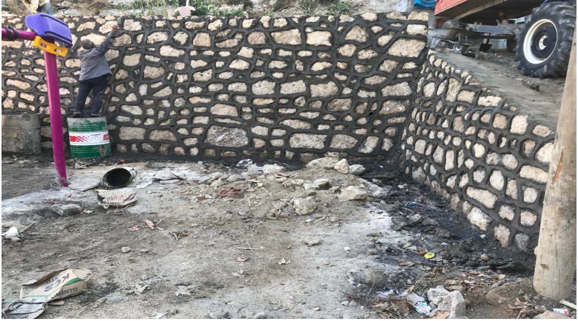
Gökçeğöz Mahallesi Taş Duvar Yapımı
