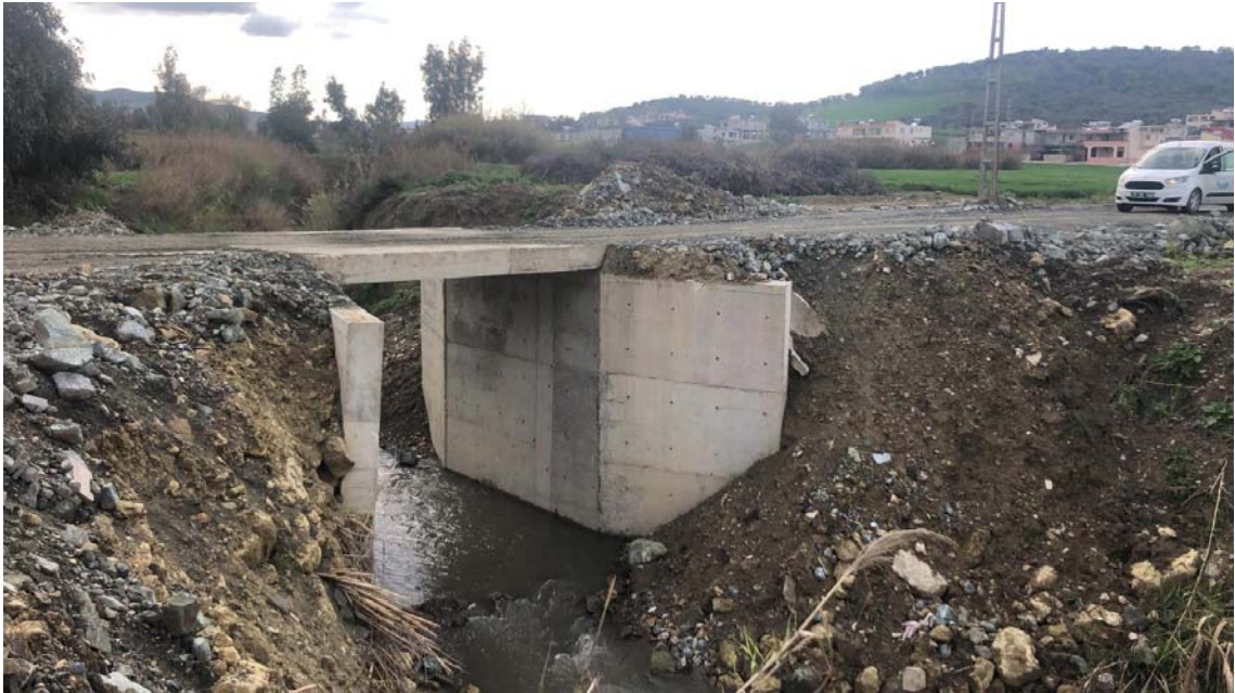
Tanışma Mahallesi Menfez Yapımı
