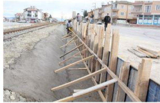
4.310 METRE YAĞMUR SUYU DRENAJ HATI YAPILMIŞTIR.
