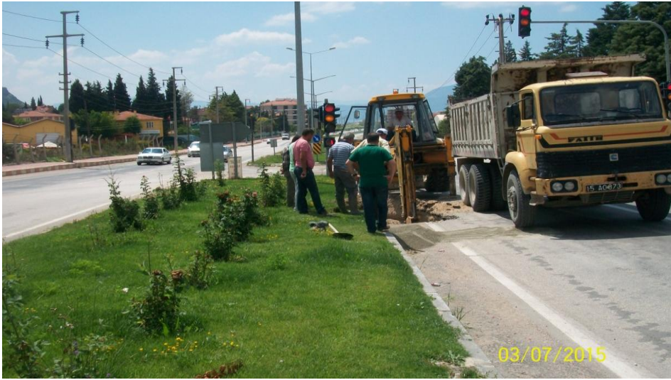
Kanalizasyon hattı tamirinden bir görüntü.
