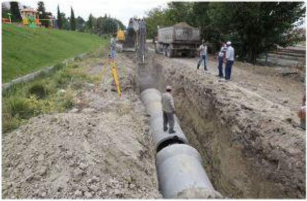
4.310 METRE YAĞMUR SUYU DRENAJ HATI YAPILMIŞTIR.
