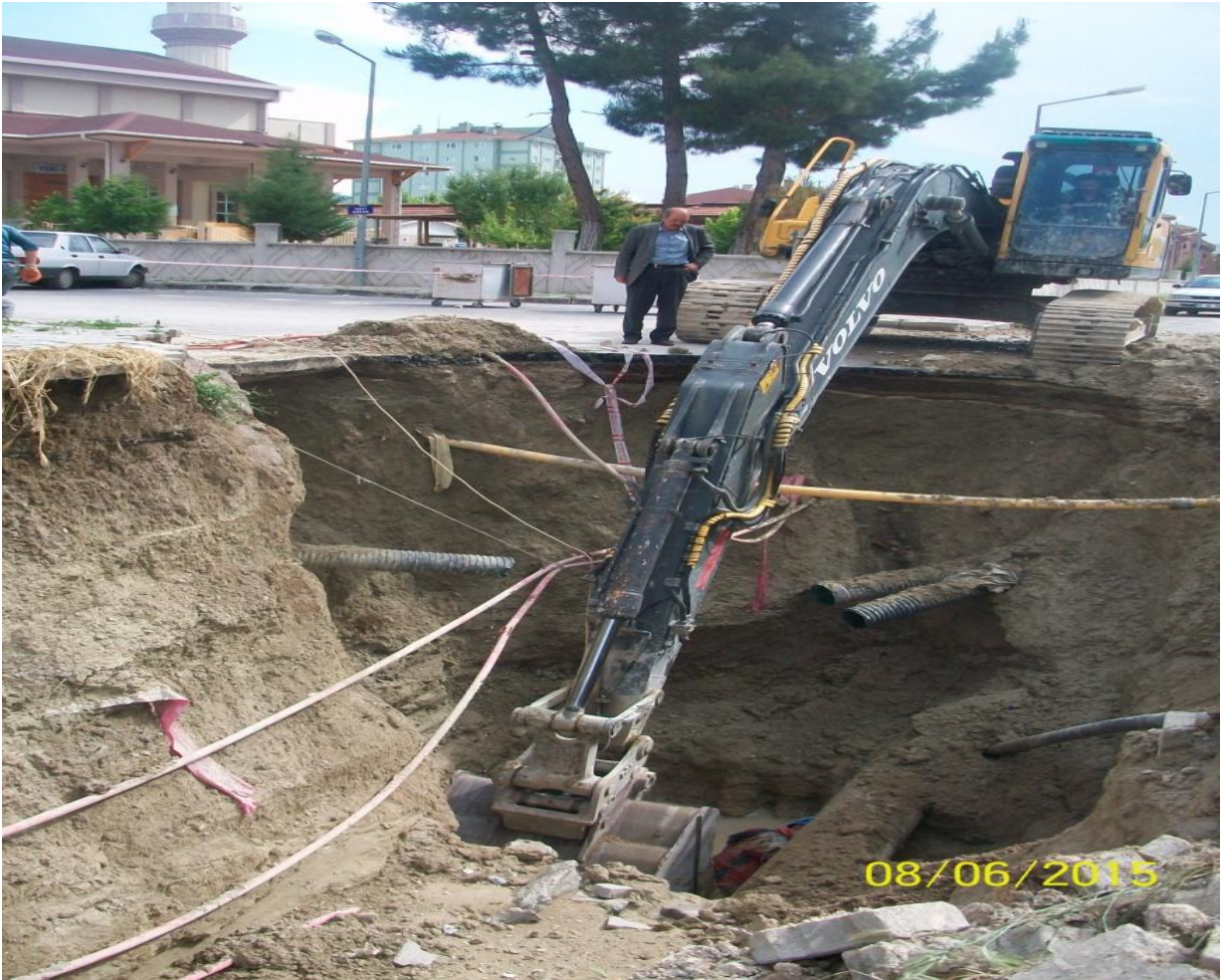
Su patlağı tamiratında,su kanalizasyon, yüksek voltajlı elektrik ve doğalgaz bir arada
