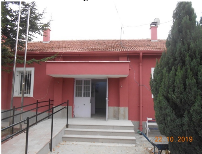
Çobanlar Kocaöz Sağlık Evi Bakım Onarım
