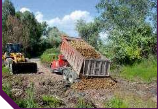
Dere geçiş yoluna koruge boru koyuldu, taşlı malzeme serildi.
