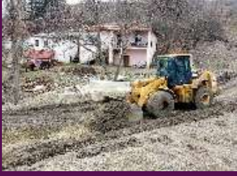
Zemin iyileştirmesi yapıp taş serimi gerçekleştirildi.
