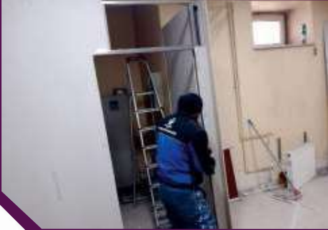
Sağlık ocağı içi alçıpan ile oda bölünmesi yapıp alçı boya tamirleri yapıldı.
