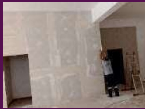
Kadınlar Lokali içi alçıpan ile oda bölünmesi yapıldı. Elektrik tesisatları döşenip su ve elektrik abonelik işlemleri yapıldı.
