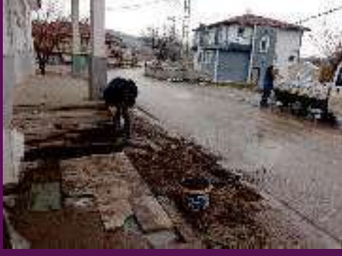
Köy odası girişi andezit taşı tamiri yapıp, beton atıldı.
