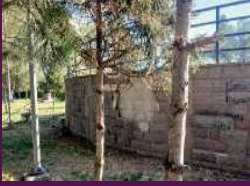
Kayı mahallesi Piknik alanı sahne arkası andezit taşları sökülüp tamirleri yapıldı.
