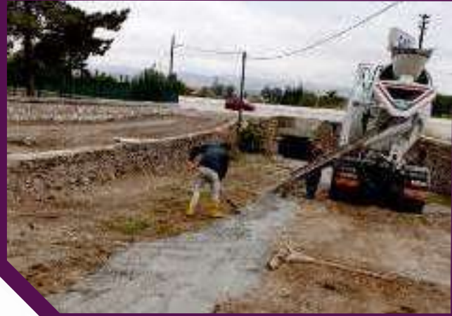
Camii yanı taş duvarı yıkılıp beton atıldı ve camii önünde doğalgaz kazısından dolayı bozulan yerin betonu atıldı.
