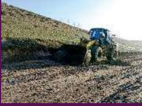
Eski yapının yıkımı ve hafriyatının alımı yapıldı.
