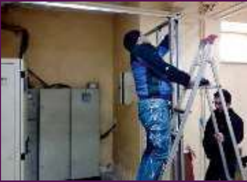
Sağlık ocağı içi alçıpan ile oda bölünmesi yapıp alçı boya tamirleri yapıldı.
