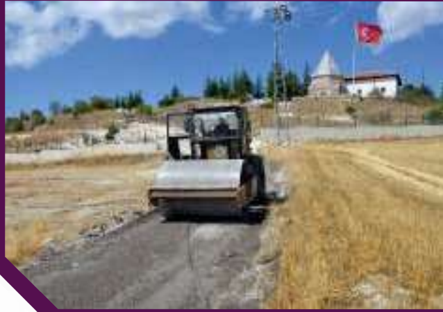
Durhasan Bey Şah (Turasan Şah) Türbesine ulaşım için arazide yol açılıp stabilize malzeme serimi yapıldı.
