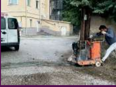
Yatılı talebe yurdu girişinde enerji kablo geçişi için asfalt kesimi yapıldı.
