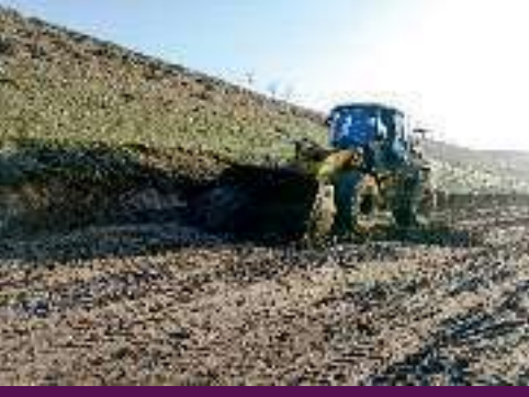
Zemin iyileřtirmesi yapıldı.
