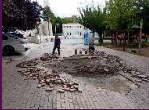
Sağlık ocağının yan yolunda oluşan çökme sökülüp tamiri yapıldı.
