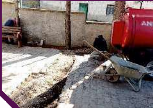
Konak girişinde doğalgaz bağlantısı için kazılan kilitli taşın tamiri yapıldı.
