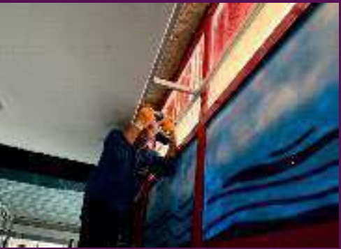
Yüzme havuzuna 40x300 kasa yapılıp montajı yapıldı.
