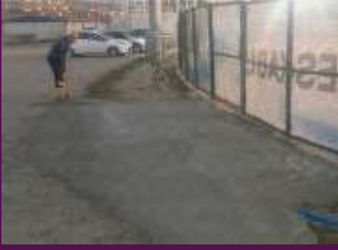
İlçe stadı girişine beton atıldı.
