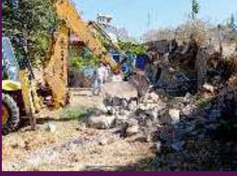
Selden zarar gören istinat duvarı tadilatı yapıldı.
