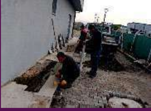
Hayvan barınağı andezit kilitli taş tamirleri yapıldı.
