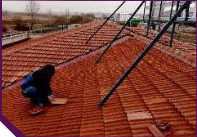
Hayvan Barınağı çatısındaki kırık kiremitler değiştirilip tamir edildi.
