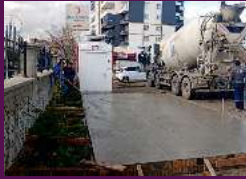
Yeni devlet hastanesi bahçesine beton döküldü.
