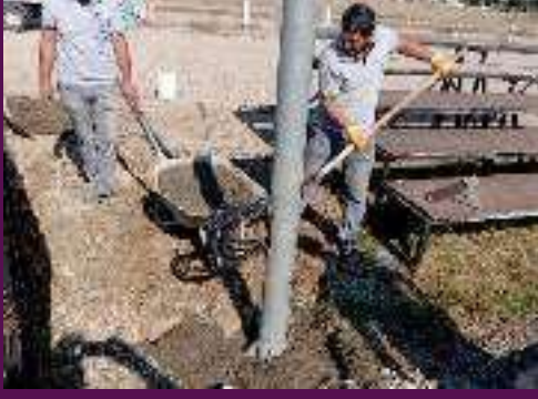
Bocce sahasına aydınlatma direği ankrajı atıldı, direk dikildi.
