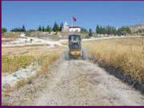
Durhasan Bey Şah (Turasan Şah) Türbesine ulaşım için arazide yol açılıp stabilize malzeme serimi yapıldı.
