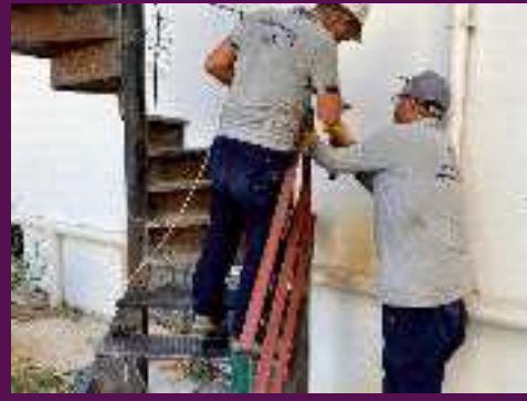
Gündüz Kreş ve Bakım Evine yangın çıkış merdiveni tadilatı yapıldı kullanılır hale getirildi.
