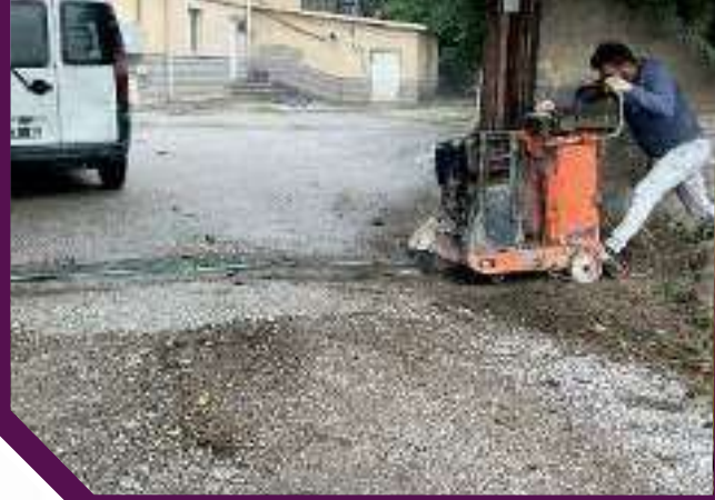
Yatılı talebe yurdu girişinde enerji kablo geçişi için asfalt kesimi yapıldı.
