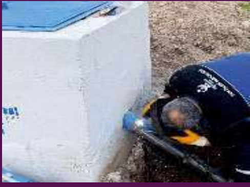
Sulama kanalının bağlantısı yapıldı.
