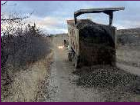
Zemin iyileştirmesi yapıldı.
