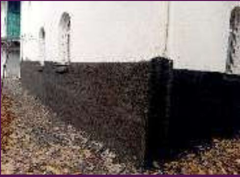
Akçaören mahallesi camiinin dış cephede sıvası dökülen ve bozulan yerleri yeniden sıva çekilip tamir edildi.
