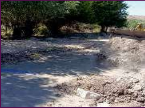
Mahalledeki çeşme su hattı suyu arızası giderildi.
