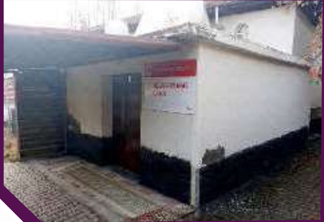
Akçaören mahallesi camiinin dış cephede sıvası dökülen ve bozulan yerleri yeniden sıva çekilip tamir edildi.
