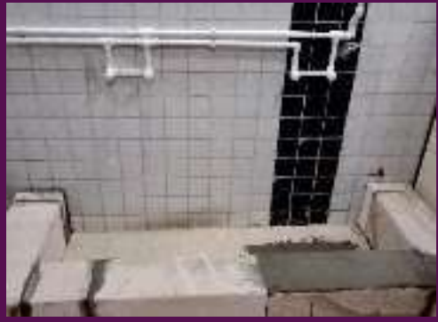
Belediye binası 2. kat bayanlar abdesthanesi tadilatı yapıldı.
