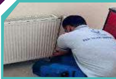
Gülnaz İbrahim Güngör Tara Mesleki ve Teknik Anadolu Lisesi ısıtma peteklerinin montajı yapıldı.
