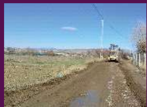
Reglaj çalışması yapıldı.
