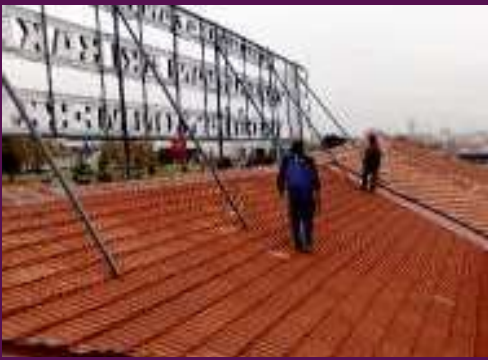
Hayvan Barınağı çatısındaki kırık kiremitler değiştirilip tamir edildi.
