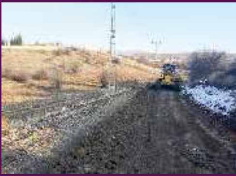
Reglaj çalışması yapıldı.
