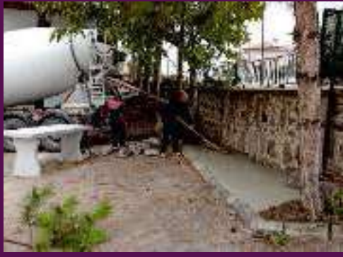
Camii yanı taş duvarı yıkılıp beton atıldı ve camii önünde doğalgaz kazısından dolayı bozulan yerin betonu atıldı.
