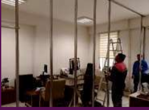
Adliye binası alçıpan ile oda bölünmesi yapıldı.
