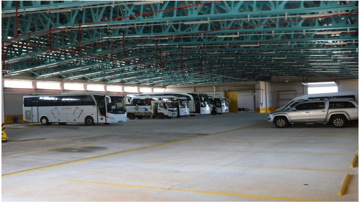
Resim 4. Hangar İç Görünüm
