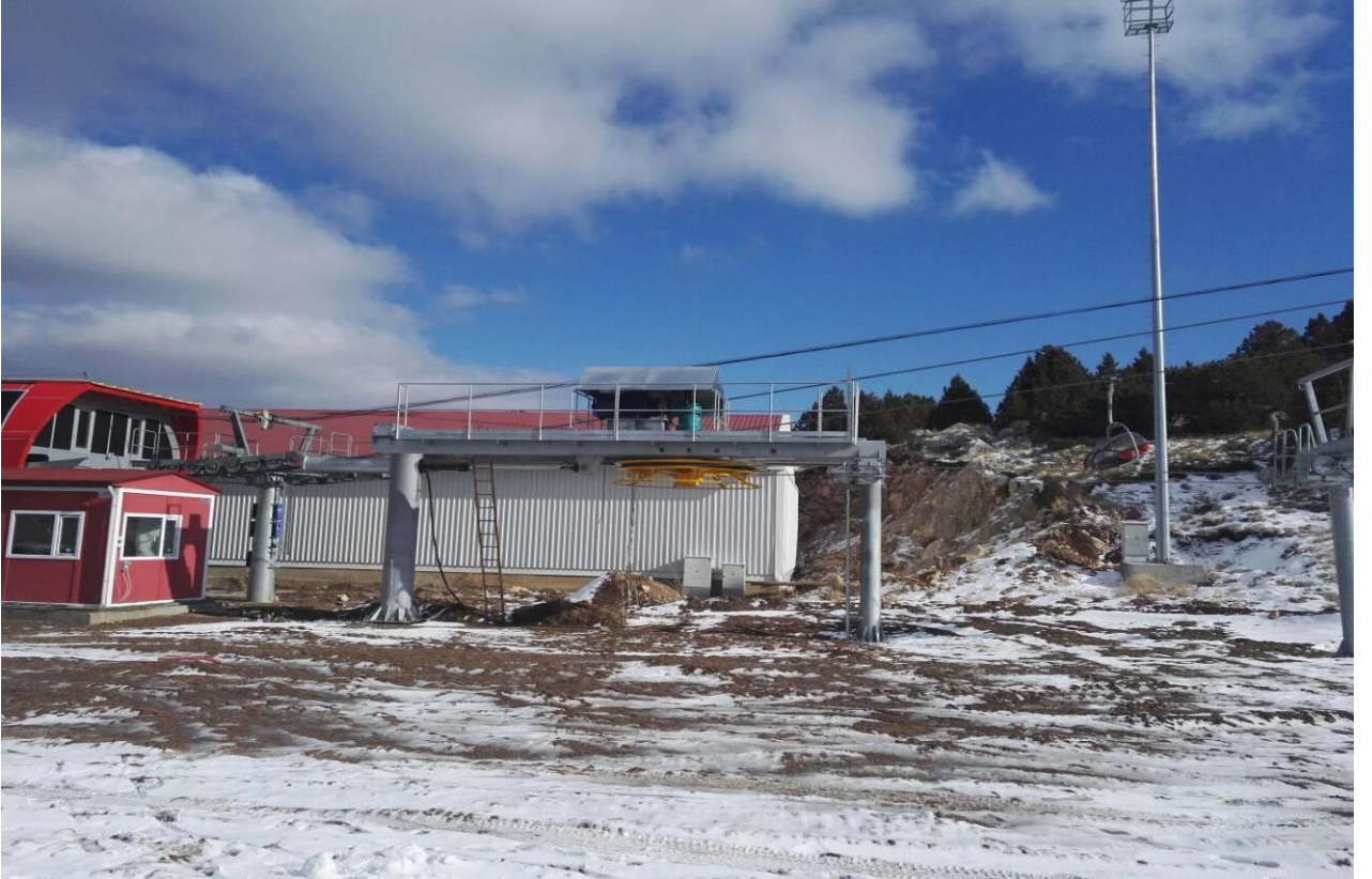
Ergan Dağı Teleski Tesisleri.
