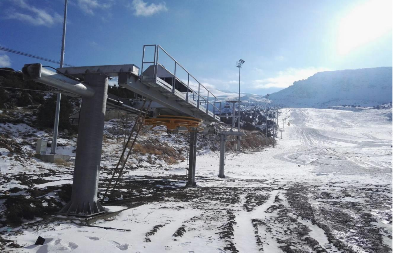
Ergan Dağı Teleski Tesisleri.
