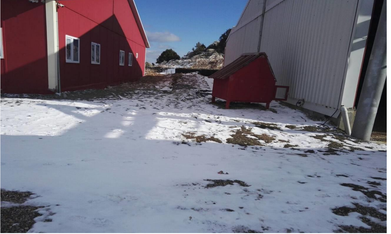
Ergan Dağı Kanal Yapımı
