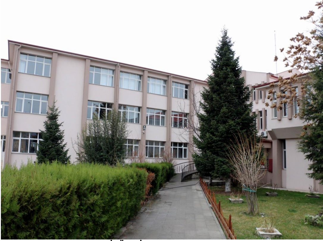
İl Özel İdaresi Hizmet Binası
