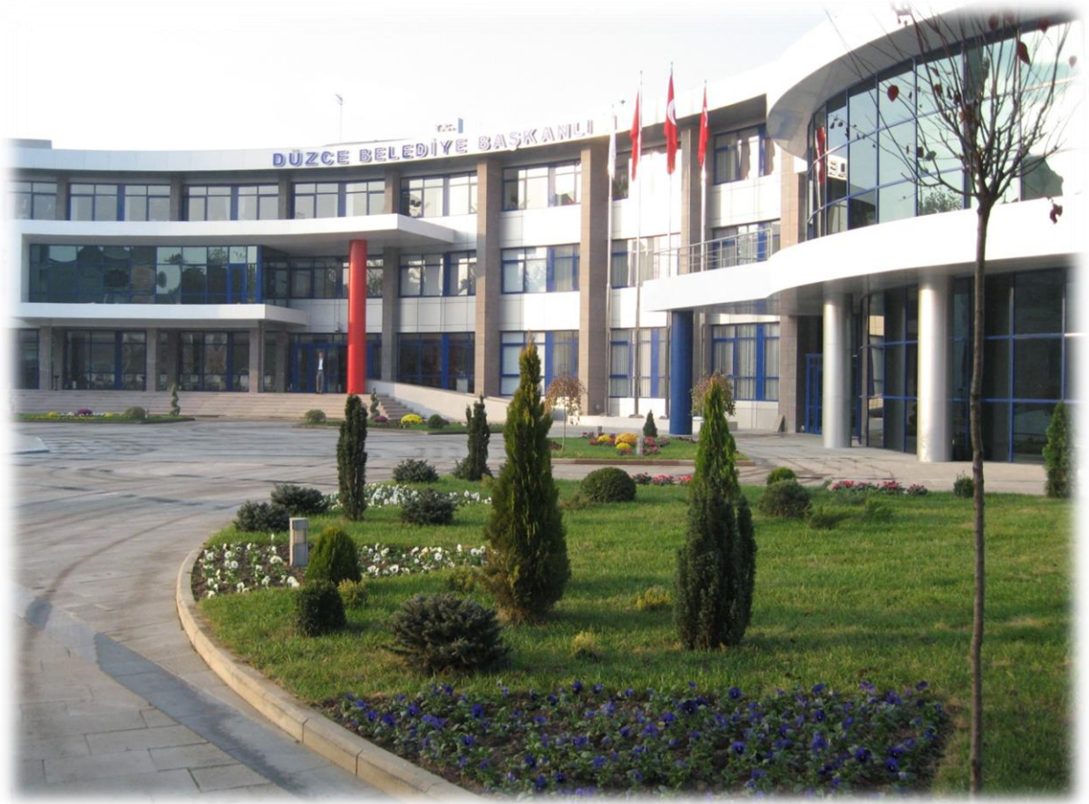
Düzce Belediyesi Ana Hizmet Binası
