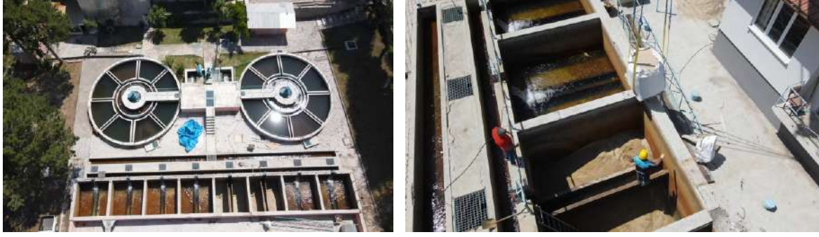
Bahabey İçme Suyu Arıtma Tesisi Revizyon Çalışmaları
