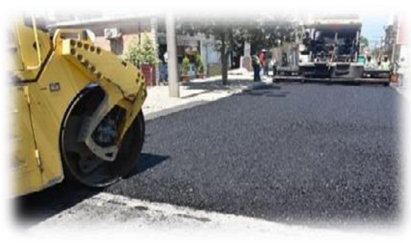
Sıcak Asfalt (BSK) Kaplama Yol Çalışmaları
