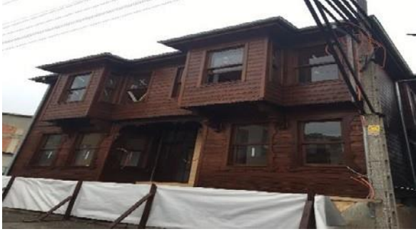
Süleymanpaşa İlçesi Gündoğdu Mahallesi 66-67 Parsel Yapım İşi: İş tamamlandı.
