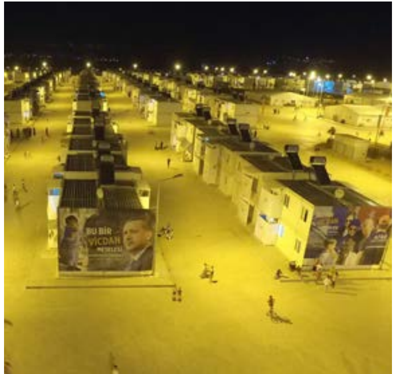
Kahramanmaraş Çift Katlı Konteyner Kent
