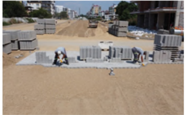
Yeşil Mah. 1859 Sok. Yol düzenlemesi
