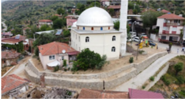
Karahallı Mahallesi Cami Etrafı İstinat duvarı
