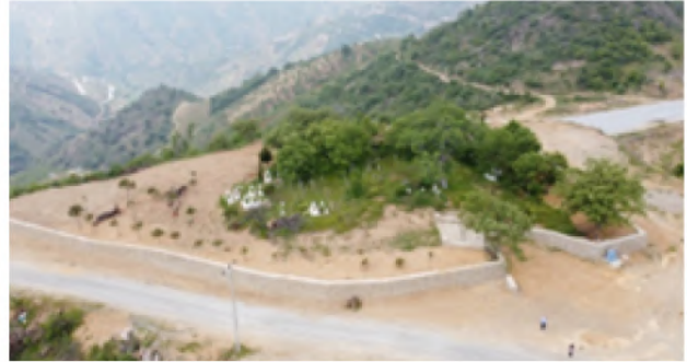
Karahallı Merkez Yol Kenarı İstinat Duvanı
