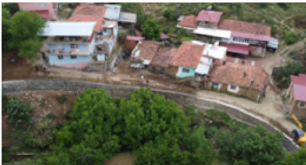
Kahvederesi yol kenarı istinat duvarı
