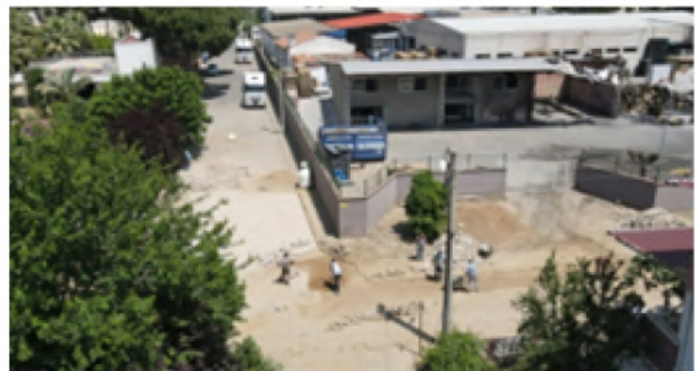
İsabeyli Şırlan Fabrika Etrafı yol Düzenlemesi
