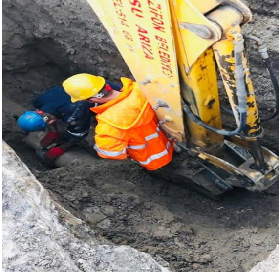
(Boru Değişimi ve Tamirâtı Yapılması)
