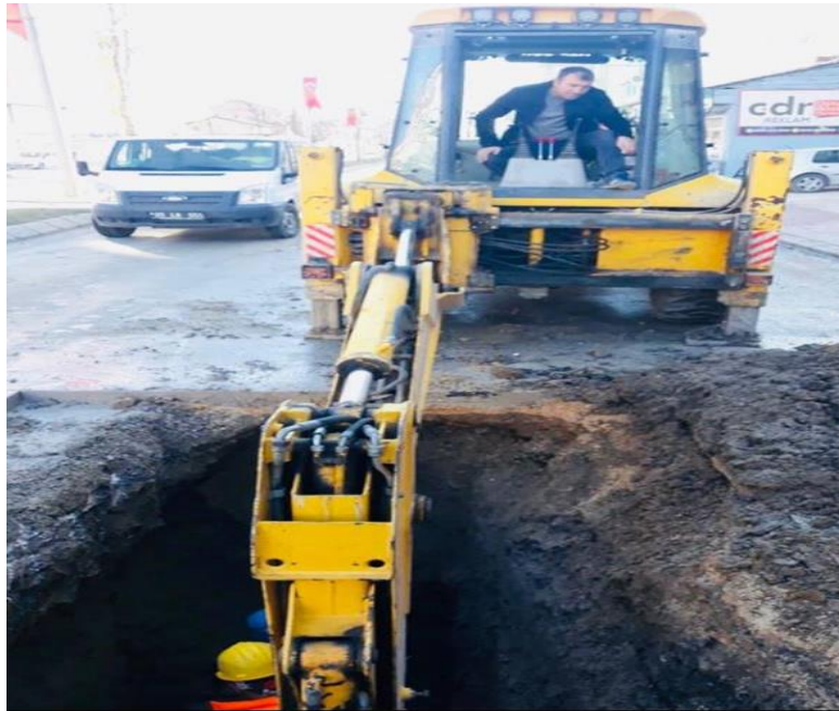
(Su Patlağı Giderilmesi)
