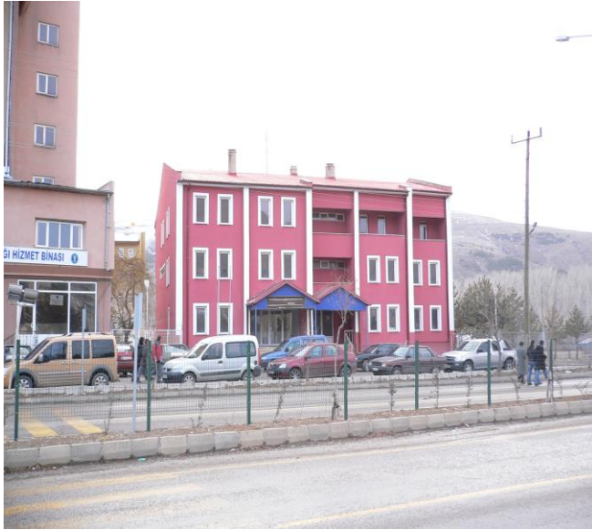
112 Komuta Kontrol Merkezi
