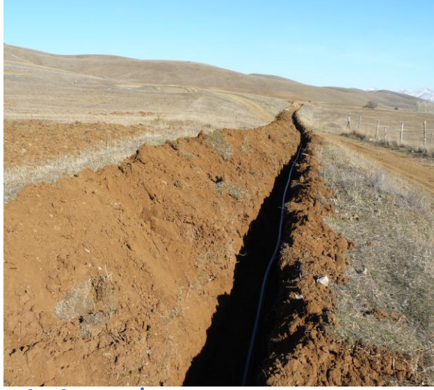
Elmalı Köyü İçmesuyu
