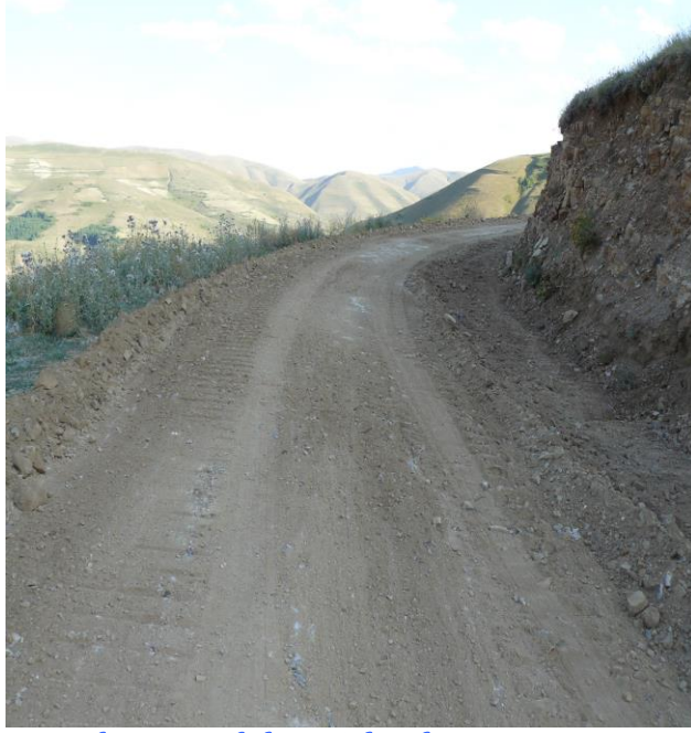
Konakyeri Stabilize Yol Çalışması
