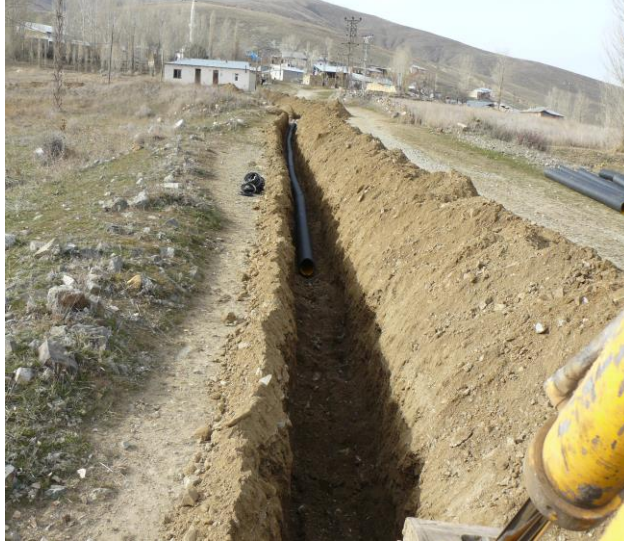
Güllüce Köyü Kanalizasyon
