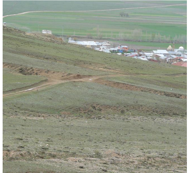
Çayır yolu Tesviye Yol Çalışması
