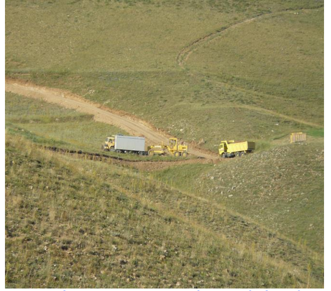
Alaca Köyü Arazi Yolu Greyderli Bakım
