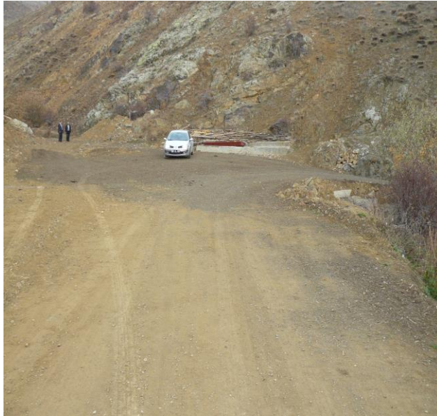
Alapelit Köyü Tesviye Yol Çalışması
