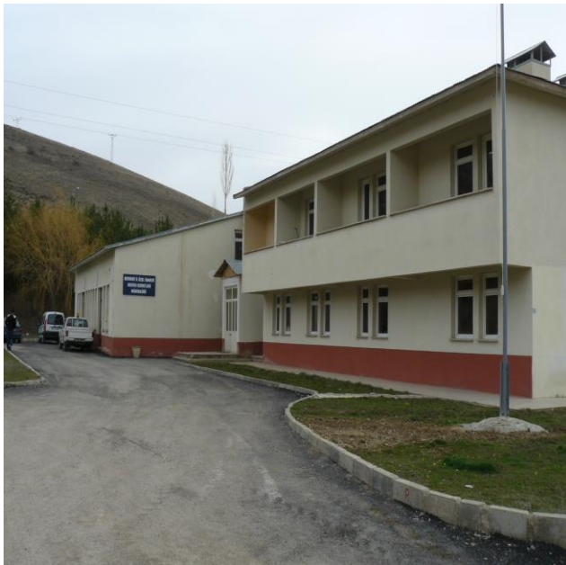
İl Özel İdaresi Ek Hizmet Binası
