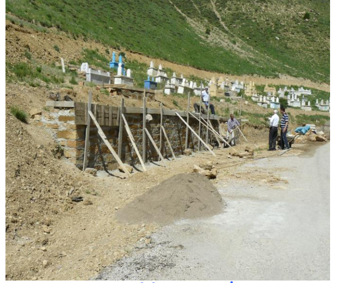
Akduran Köyü İstinat Duvarı
