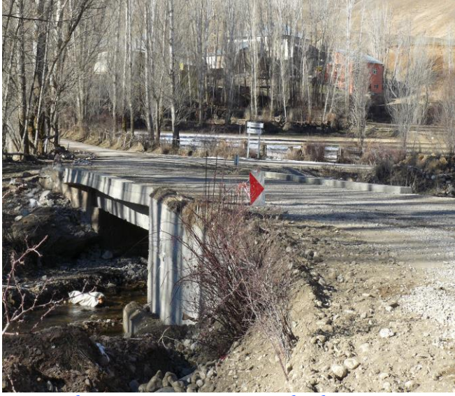
Güneydere Köyü Köprü Genişletilmesi
