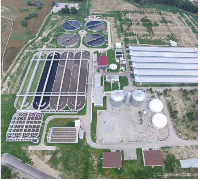
Atıksu arıtma tesisimizde günlük ortalama 17.000 kW olan elektrik tüketiminin 3.800 kW.'ı tesiste biyogazdan elde edilen elektrik enerjisi ile karşılanmaktadır.
