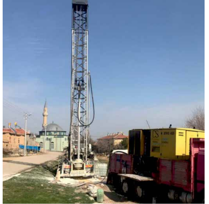
İçmesuyu Temini Amacıyla Sondaj Çalışması
