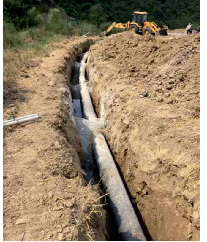
Yumurtalık İlçesi Düktil (350 mm) İçmesuyu Şebekesi Yapımı
