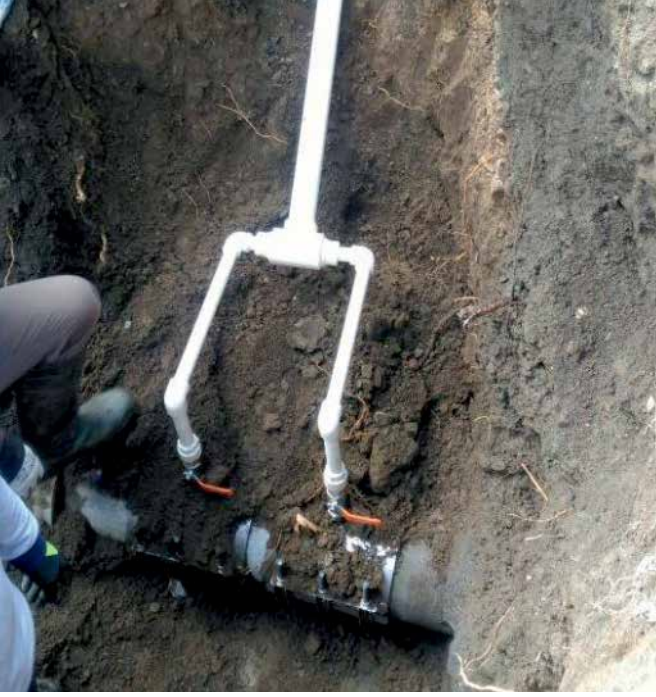
İlk Abonelik Tesisi Amacıyla İçmesuyu Bağlantı Çalışması
