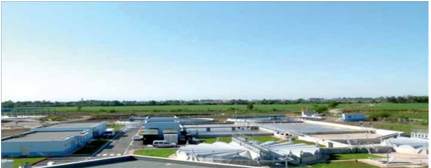
Ceyhan Atıksu Arıtma Tesisi
