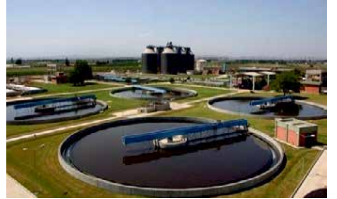
Yüreğir Atıksu Arıtma Tesisleri
