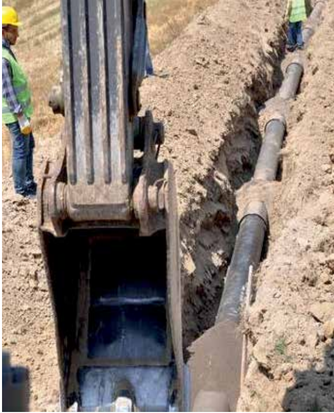
Yumurtalık İlçesi Düktil (350 mm) İçmesuyu Şebekesi Yapımı
