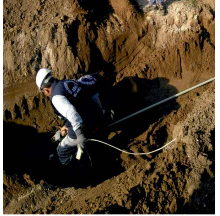
İlk Abonelik Tesisi Amacıyla İçmesuyu Bağlantı Çalışması
