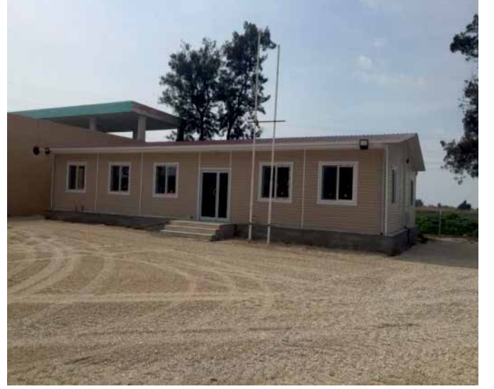
Karataş Şantiye Tesisi Bina Yapımı
