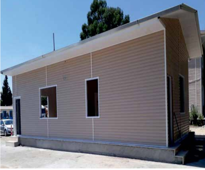
Merkez Şantiye Tesisleri İdari Bina Yapımı
