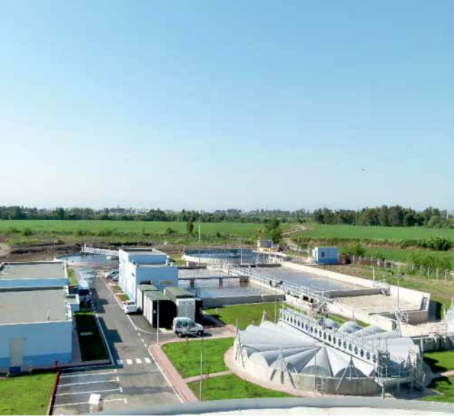
Ceyhan Atıksu Arıtma Tesisi
