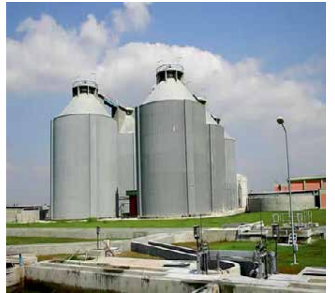
Seyhan Atıksu Arıtma Tesisleri
