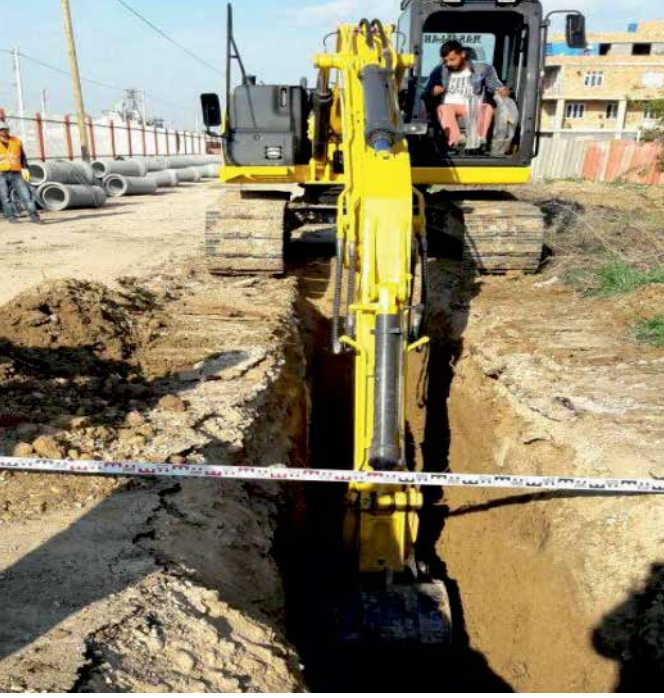
Yağmursuyu ve Kanalizasyon Şebekesi Yapımı
