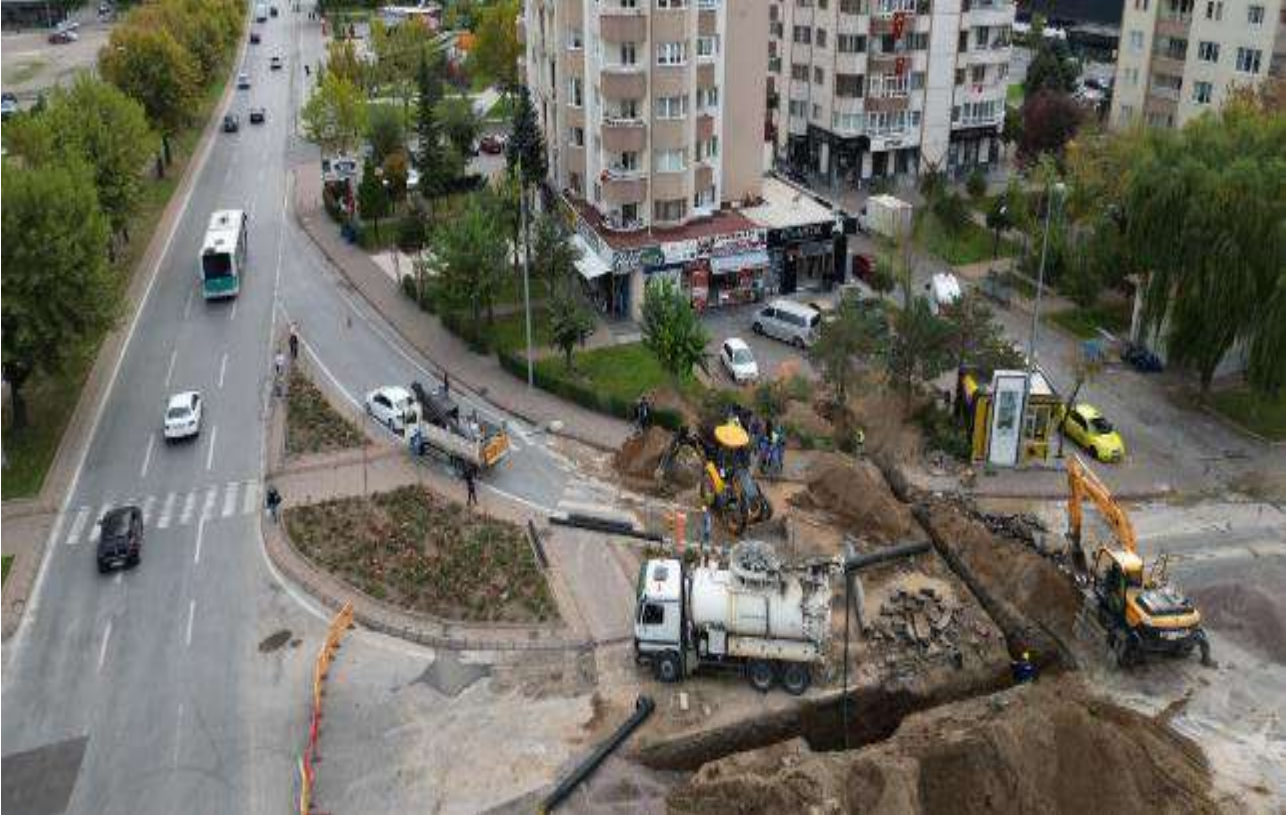
Şekil-5: Alt Bölge Odası Bağlantısı ve Montajı
