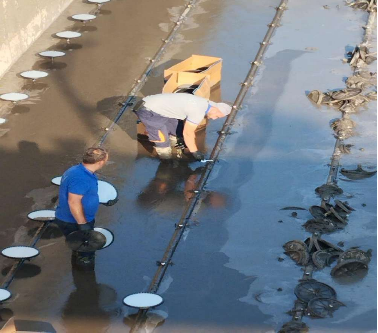
HAVALANDIRMA DİFÜZÖR DEĞİŞİMİ
