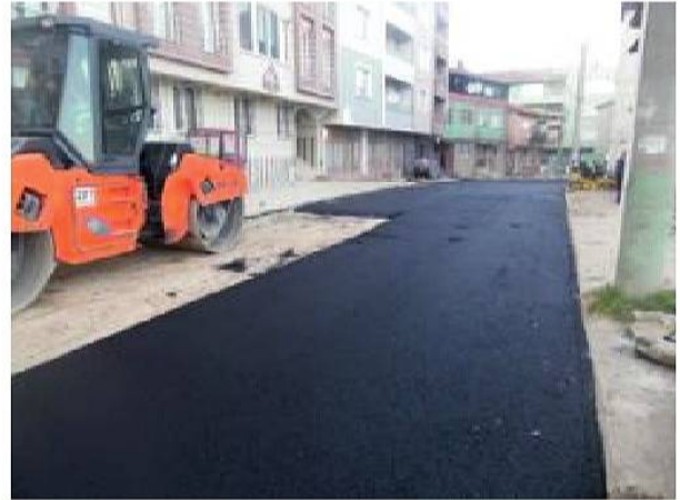
TEKKE MAHALLESİ ERSÖZLER CADDESİ YOL KAZI, REGLAJ VE SICAK ASFALT ÇALIŞMALARI
