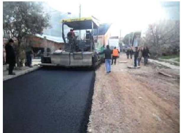
TEKKE MAHALLESİ ERSÖZLER CADDESİ YOL KAZI, REGLAJ VE SICAK ASFALT ÇALIŞMALARI
