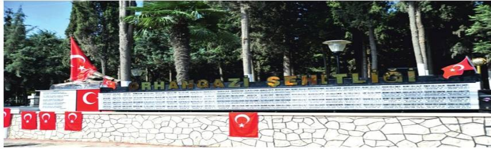
Eski Kent Mezarlığı içerisinde bulunan İlçe Şehitliğinde tadilat yapılarak yeni bir görünüme sahip olması sağlanmıştır.
