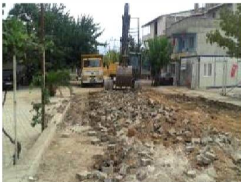
MURADIYE MAH. DSİ SAĞ KANALYOLU CAD. KAZI, REGLAJ VE SICAK ASFALT ÇALIŞMALARI
