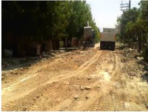
MURADIYE MAHALLESİ FATİH CAD. YOL KAZI, REGLAJ VE SICAK ASFALT ÇALIŞMALARI
