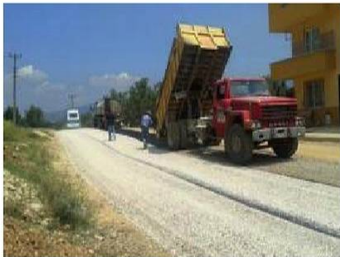
ARAPZADE MAH. HAMZALI YOLU SATHİ KAPLAMA ÇALIŞMALARI
