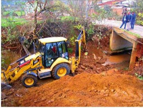
OLUKDERE DERE GEÇİŞİ BAKS TADİLATI VE GENİŞLETME ÇALIŞMASI
