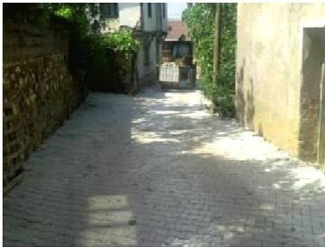
GÜRLE MAHALLESİ PARKE TAŞI İLE YOL KAPLAMA ÇALIŞMALARI
