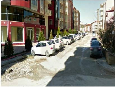
ARAPZADE MAHALLESİ GÜNEŞ SOKAK ve ARKALTI 13 NOLU SOKAK
