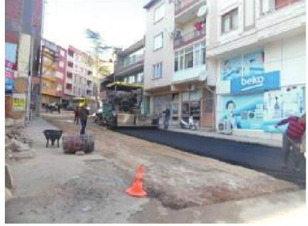
TEKKE MAHALLESİ HORHOR CADDESİ YOL KAZI, REGLAJ VE SICAK ASFALT ÇALIŞMALARI
