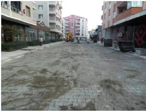
ARKALTI 5 NOLU SOKAK, SANTRAL YOLU 6 NOLU SOKAK
