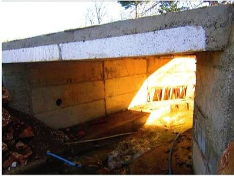
ESKİ SANTRALYOLU BAKS-2 ÇALIŞMASI
