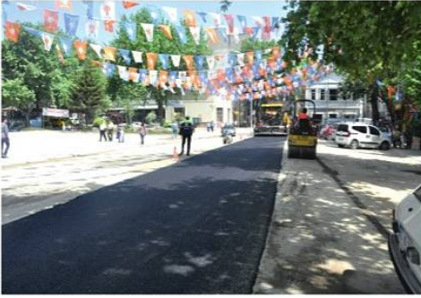
Asfaltlama Çalışmaları "Güvenlik Önlemleri"
