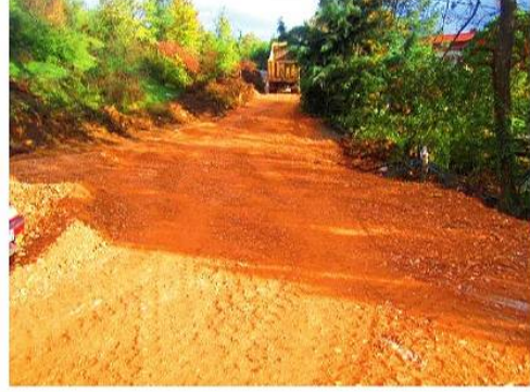
DERE GEÇİŞLERİ BAKS ÇALIŞMALARI
