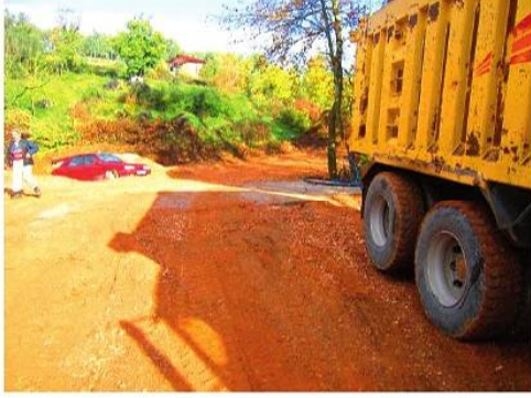
ESKİ SANTRALYOLU BAKS-1 ÇALIŞMASI
