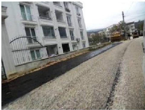
ARAPZADE MAH. GÖKMEN YILDIRAN CAD. SATHİ KAPLAMA ÇALIŞMALARI
