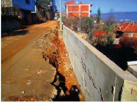
ARAPZADE MAHALLESİ 7 NOLU SOKAK İSTİNAT DUVARI
