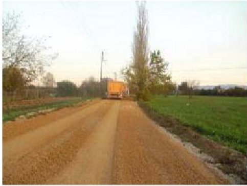
YENİKÖY MAH. TORSU MEVKİİ SATHİ KAPLAMA ÇALIŞMALARI
