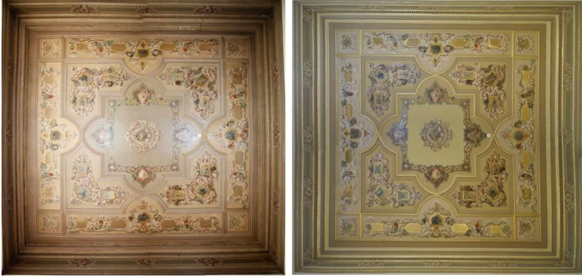
Mefruşat Dairesi kalemîşi tavan bezemeleri, restorasyon öncesi ve sonrası
