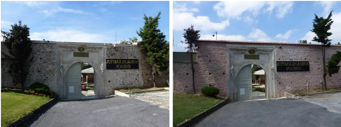
Aynalıkavak Kasrı Okmeydanı Kapısı restorasyon öncesi ve sonrası
