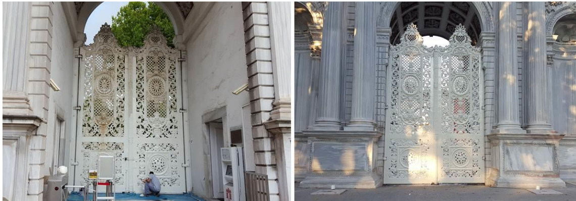
Dolmabahçe Sarayı Hazine Kapısı bakım ve boya çalışmaları
