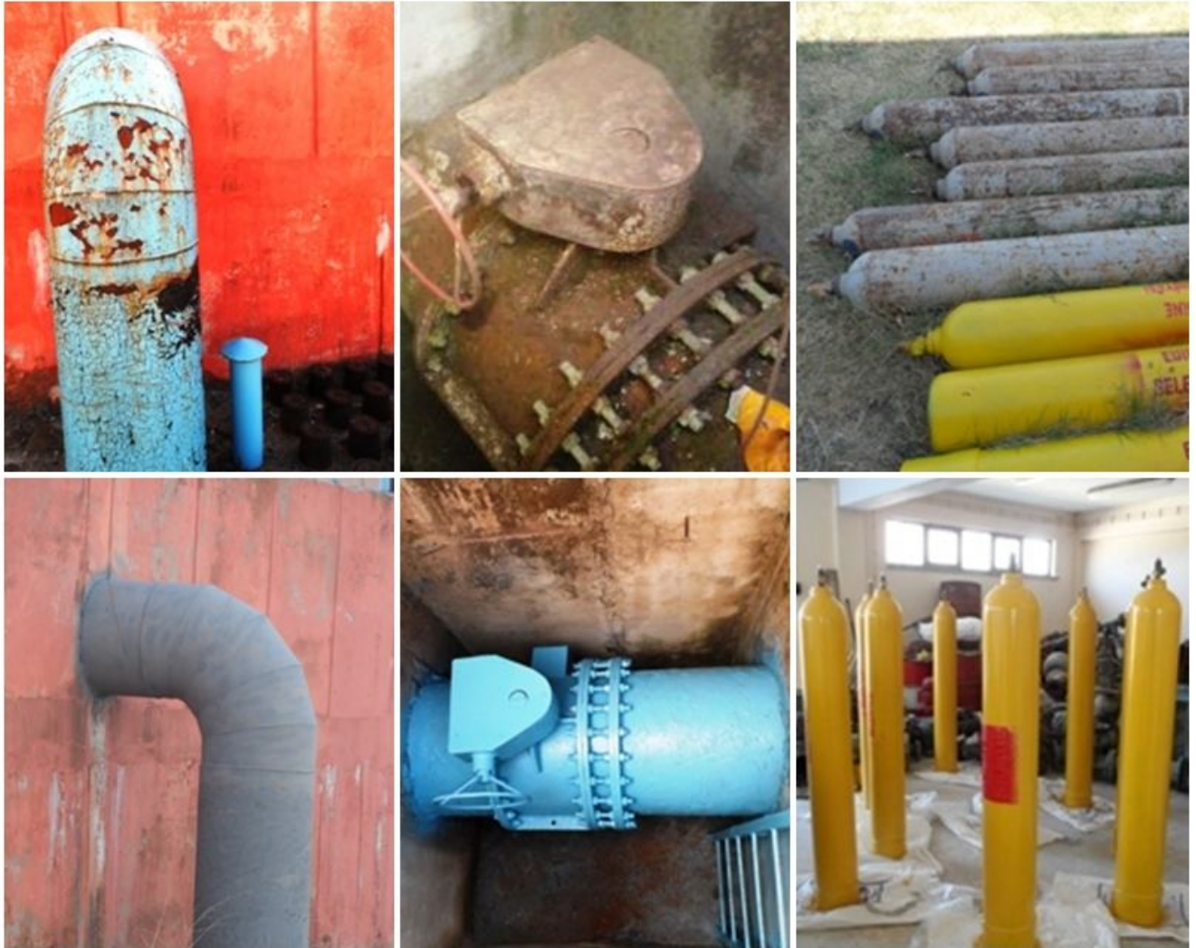
Tesiste bulunan çeşitli metal aksam, boya ve onarım işlemleri yapılmıştır.
