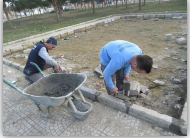
179 ADET YOL IŞIĞI DÖŞEME ÇALIŞMASI YAPILMIŞTIR.
