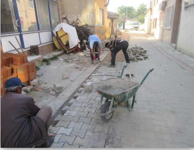
18 ADET IŞIKLI BORDÜR DÖŞEME ÇALIŞMASI YAPILMIŞTIR.
