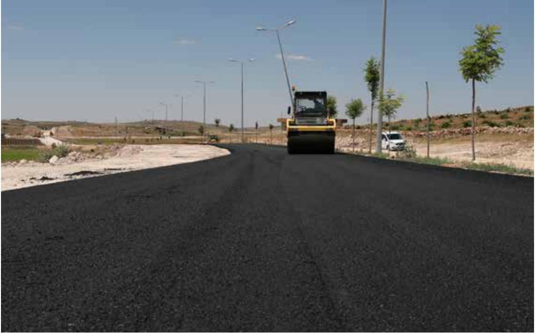
● Midyat ilçesi Vatan Caddesi yapımı
