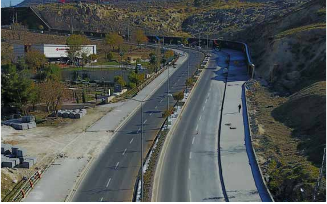
● Mardin ili Artuklu ilçesi Hava Radar yolu kaldırım yapımı
