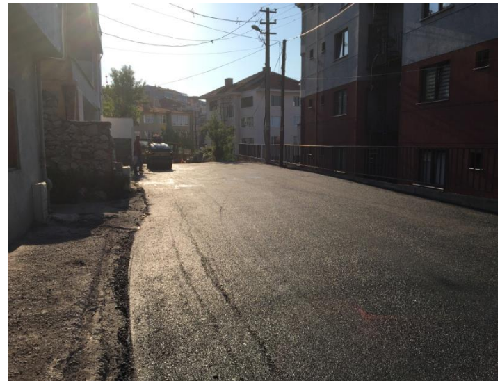
Terakki Mah Karadeniz cad. asfalt çalışması
