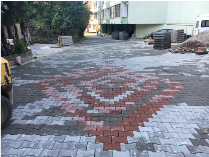
İncivez Mah. Çaybaşı Sk. parke yol çalışması
