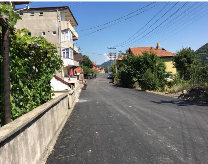
Ontemmuz Mah. Asfalt çalışması
