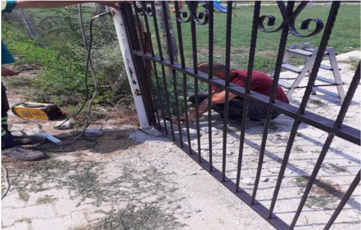
16. Selimiye Mahallesi, bordür örüldü ve parke döşendi. 1 takım Çocuk Oyun Grubu montajı yapıldı. Çocuk Oyun alanının içine Kum dolgusu ve tesviyesi yapıldı.
