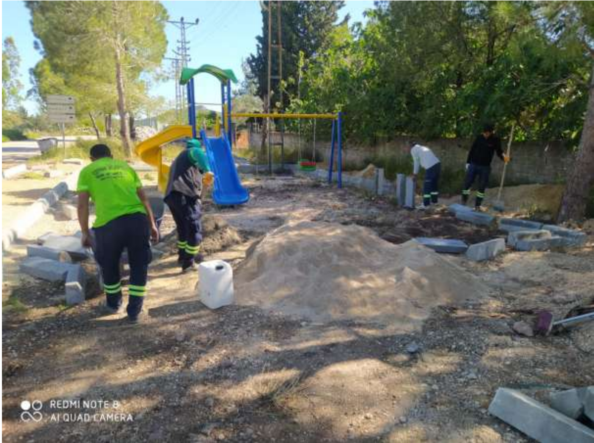
17. Yarsuvat Mahalle Parkı' nda Pergole tamiratı yapıldı, Kulübe çelik kapı onarımı yapıldı.
