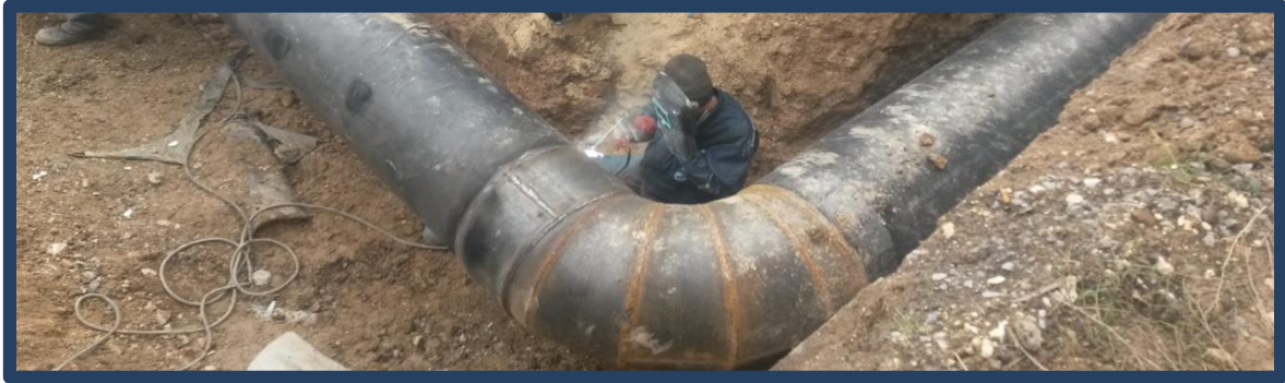
Sazova Mahallesi - Ø 800 mm. SÇB Deplase çalışması.
