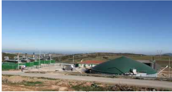
Resim: Samsun Avdan Enerji Ürt. Ve Tic. A.Ş. Biyogaz Tesisi
