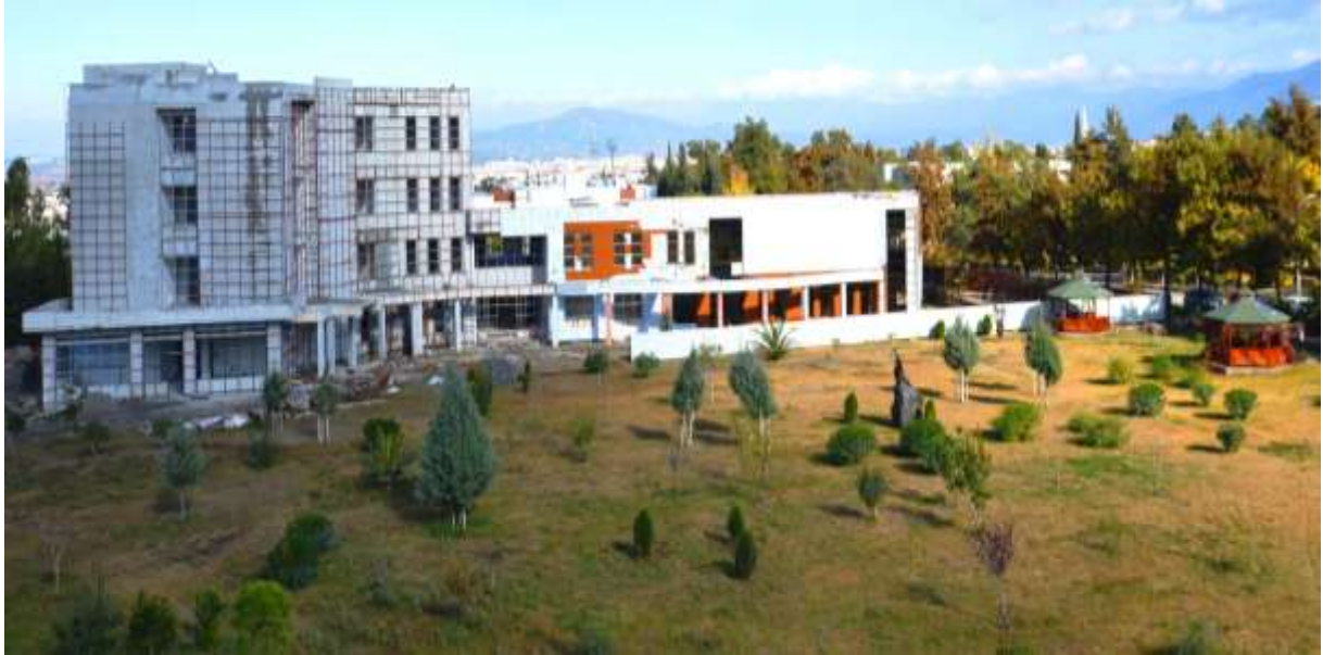
Resim 33: OKÜ Enstitü Binası İnşaatı
