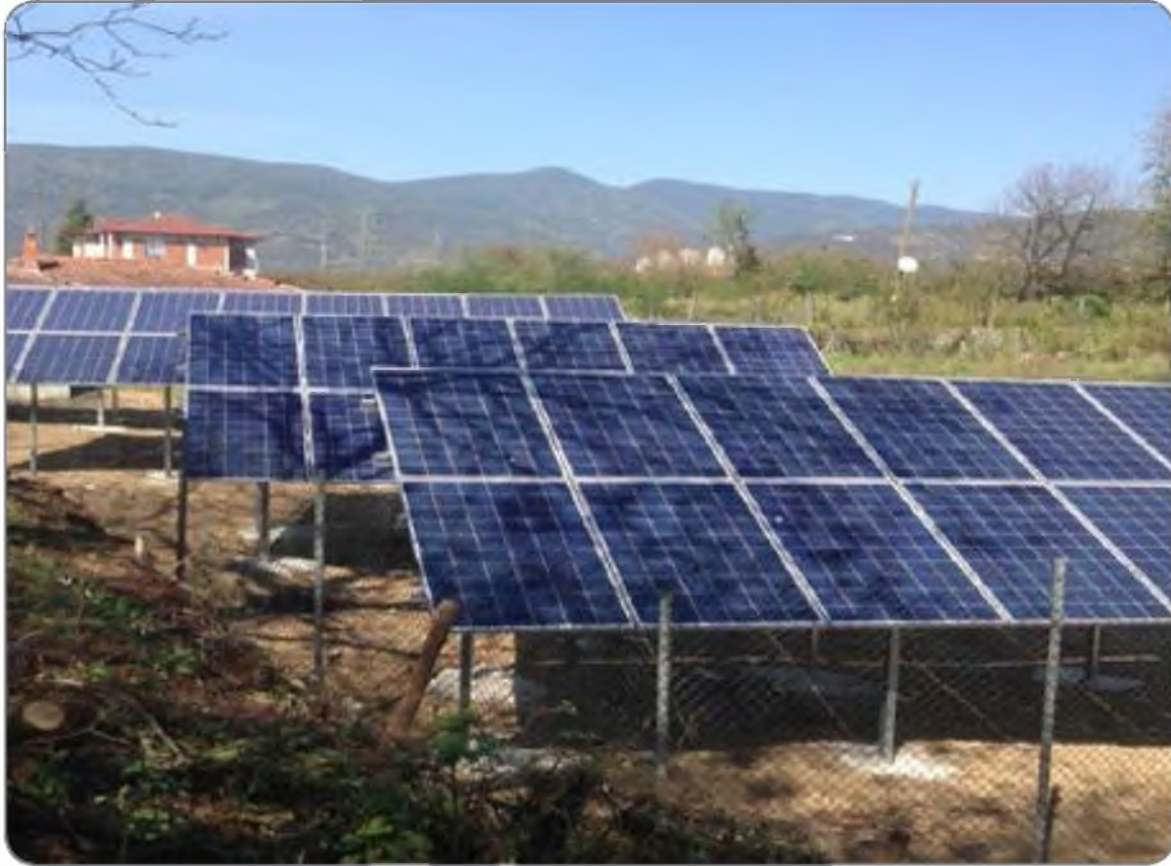
Çilimli ilçesi Söğütlü Grubu içme suyu sondajı GES yapımı tamamlandı.
