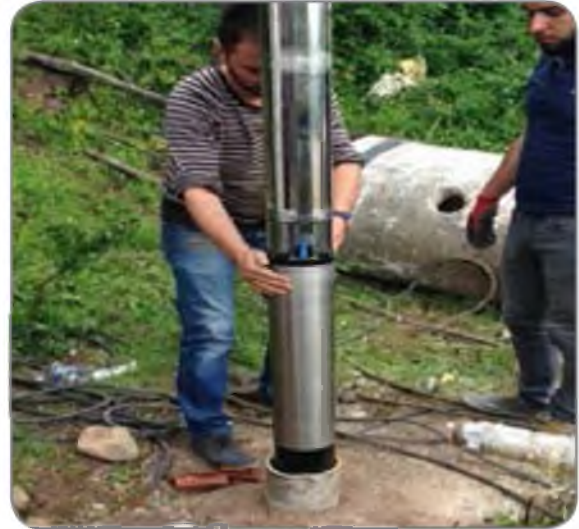
Merkez Esençam köyü sondaj motopomp değişimi ve kuyu temizliği yapıldı.
