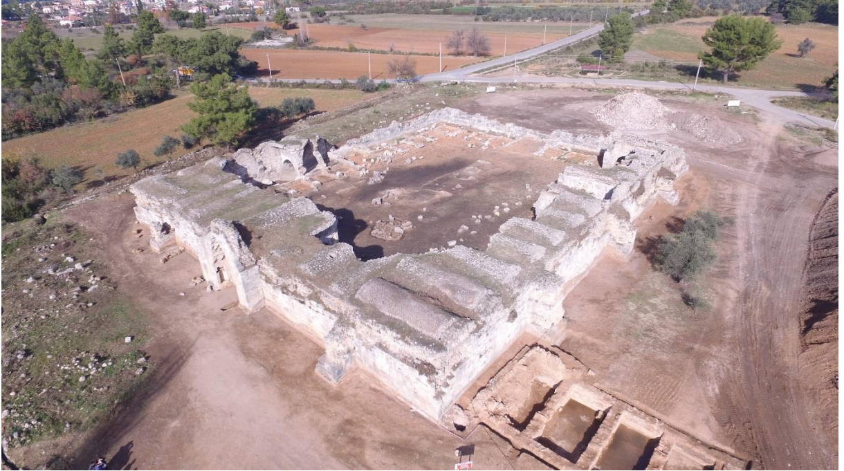
Emdirhan Restorasyon Yapım İşi
