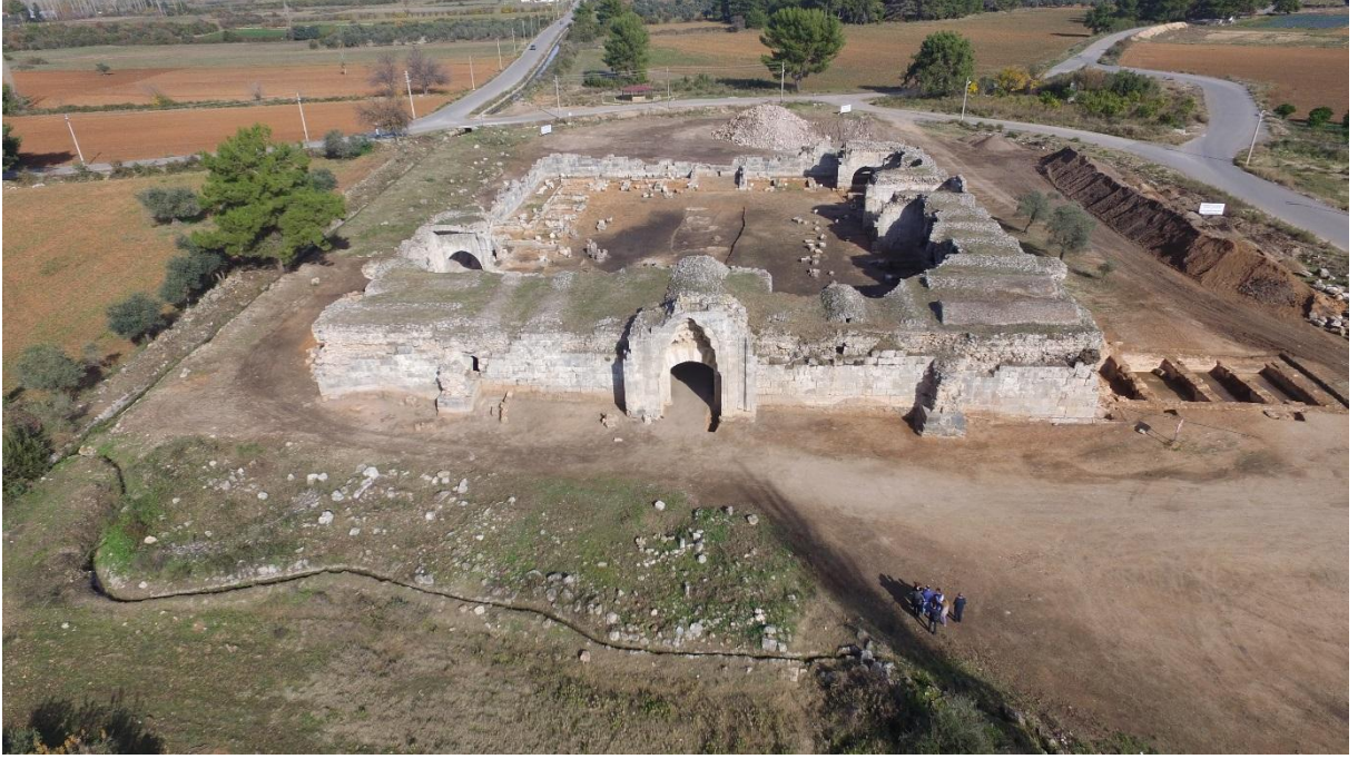
Emdirhan Restorasyon Yapım İşi
