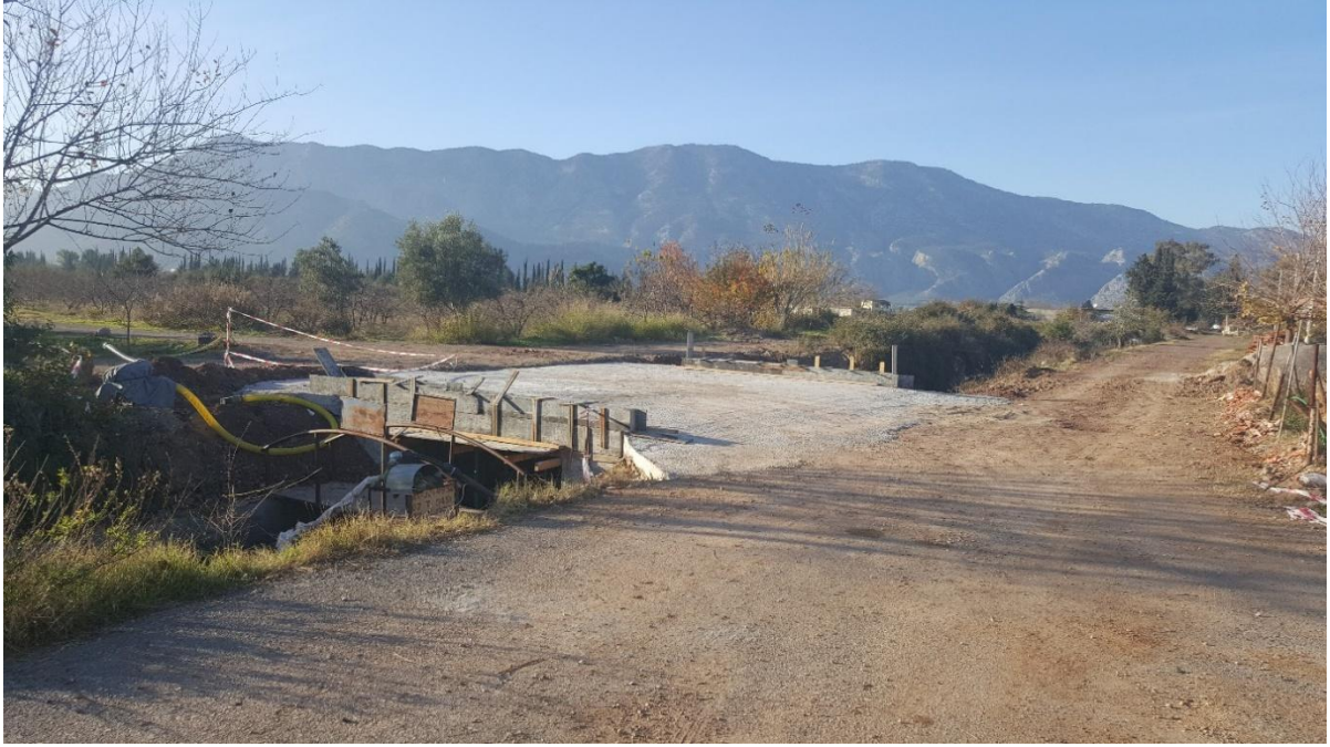
YENİKÖY MAHALLESİ KÖPRÜ ÇALIŞMASI
