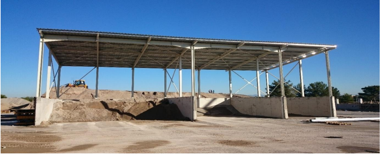
AGREGA ÇATI YAPIM İŞİ
