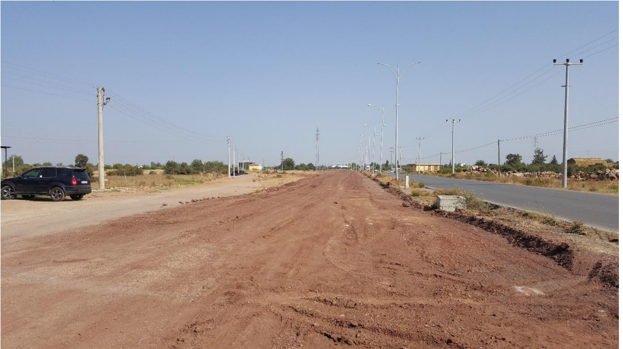
ŞEHİT MUSTAFA GÜRCAN CADDESİ ASFALT YAPIM İŞİ
