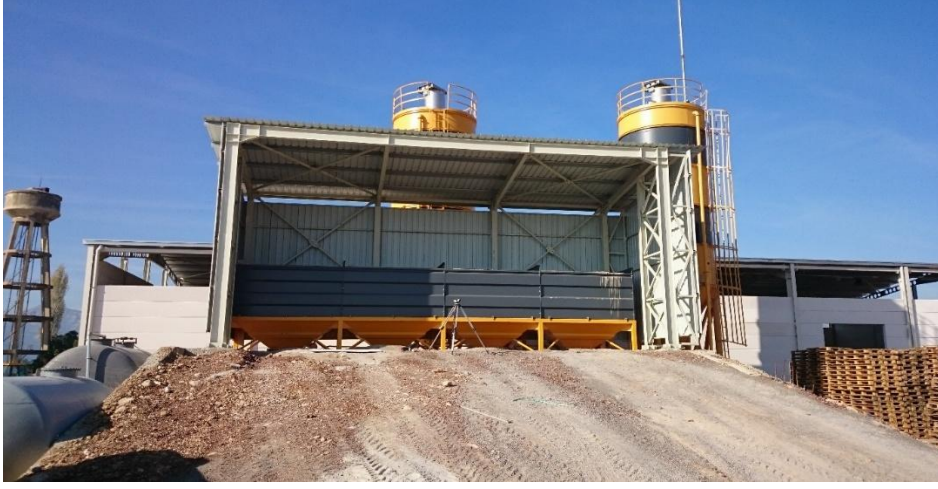
BUNKER ÇATI YAPIMI
