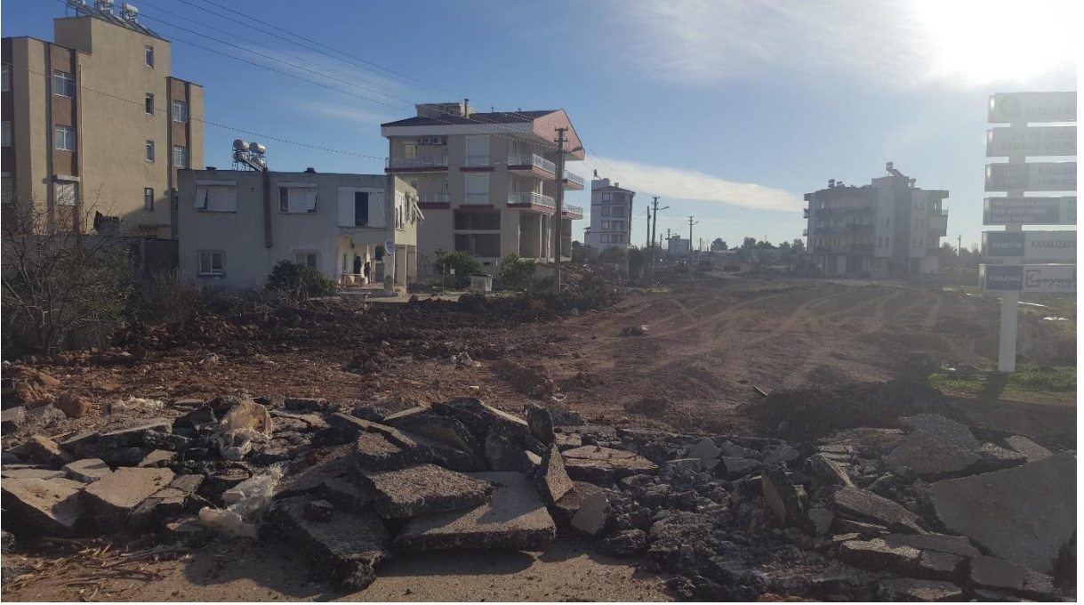
ŞEHİT MUSTAFA GÜRCAN CADDESİ ASFALT YAPIM İŞİ
