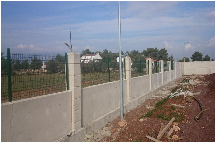
ÇEVRE DUVARI VE ÇİT YAPIM İŞİ
