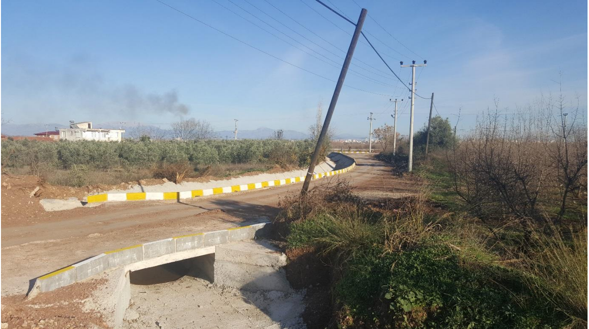
YAĞCA MAHALLESİ MENFEZ ÇALIŞMASI
