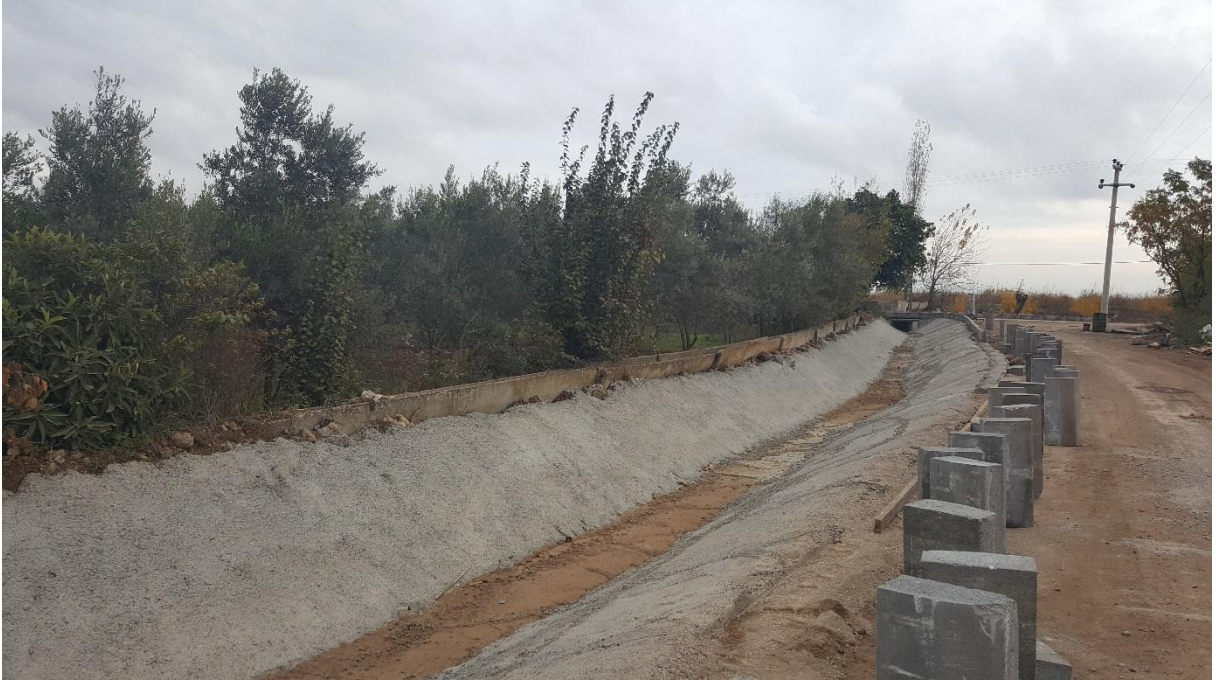
YAĞCA MAHALLESİ YAĞMUR SUYU DRENaj ÇALIŞMASI
