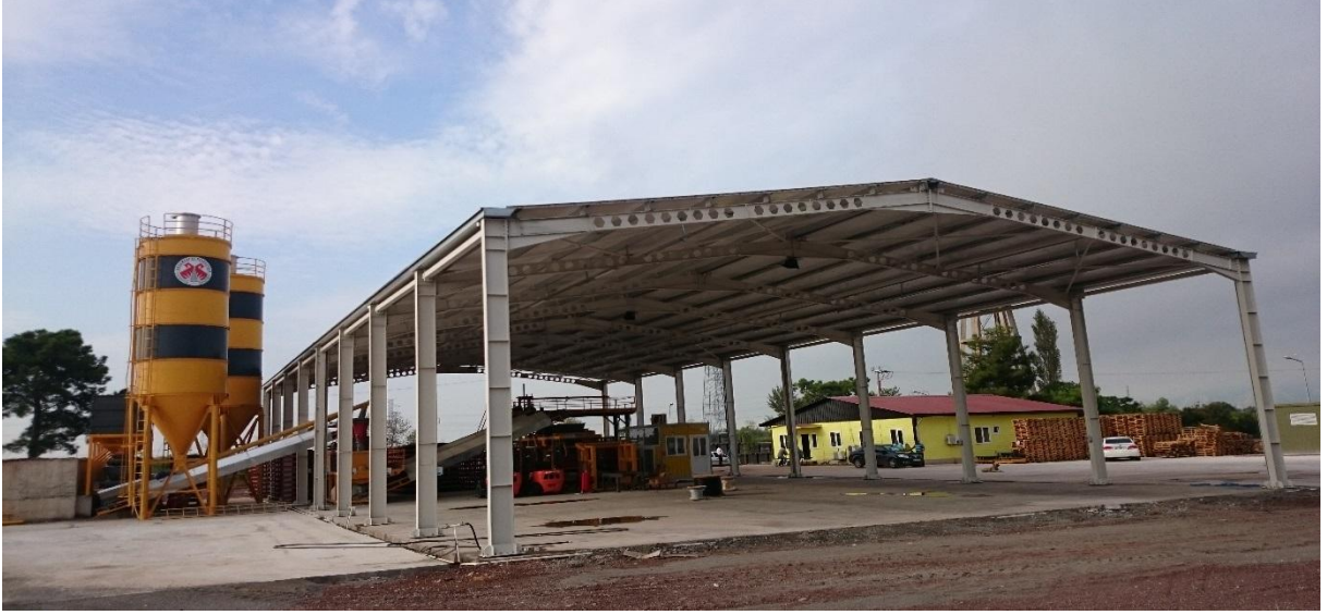
ÇELİK ÇATI VE AYDINLATMA İŞİ
