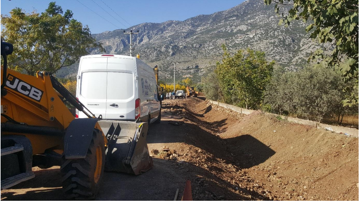
YAĞCA MAHALLESİ YAĞMUR SUYU DRENaj ÇALIŞMASI
