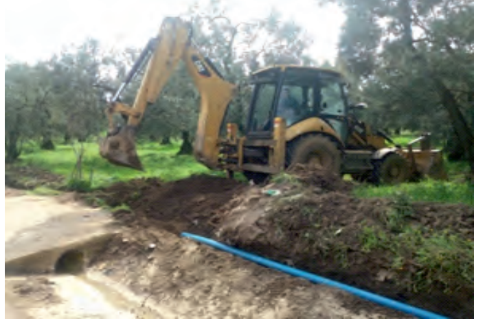
ÜREĞİL MAHALLESİ TANKER DOLUM SU İSALE HATTI ÇEKİLMESİ
