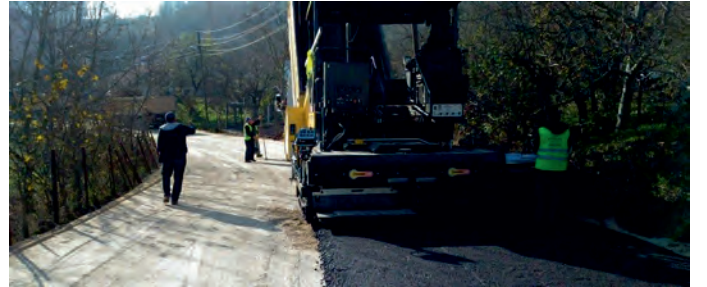
Asfalt çalışmaları sırasında güvenlik ve trafik önlemleri-2018
