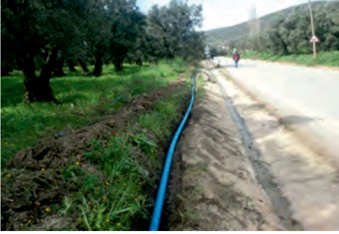
ÜREĞİL MAHALLESİ TANKER DOLUM SU İSALE HATTI ÇEKİLMESİ
