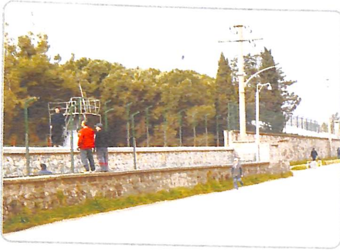
Kepsut Caddesi Ve Ağır Bakım İhata Duvarı Yapım Çalışmaları
