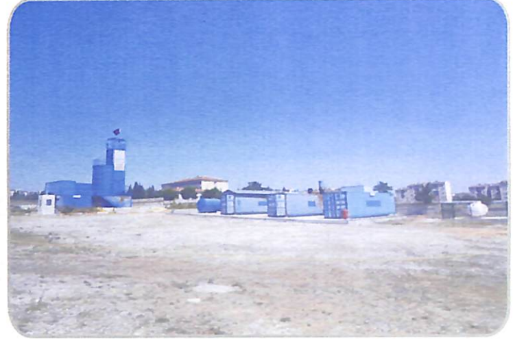
İtfaiye Eğitim Sahası Çalışmaları
