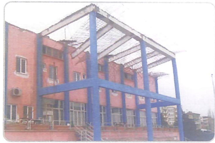
Eski Belediyespör Tesislerinde Yıkım Çalışmaları
