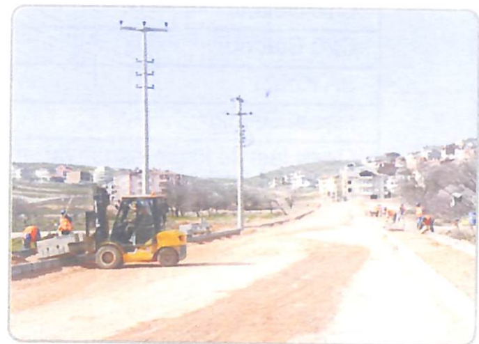
Sefaköy Yol Yapım Çalışmaları
