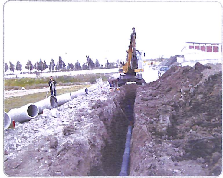
Kanalizasyon Şebeke Yapımı
