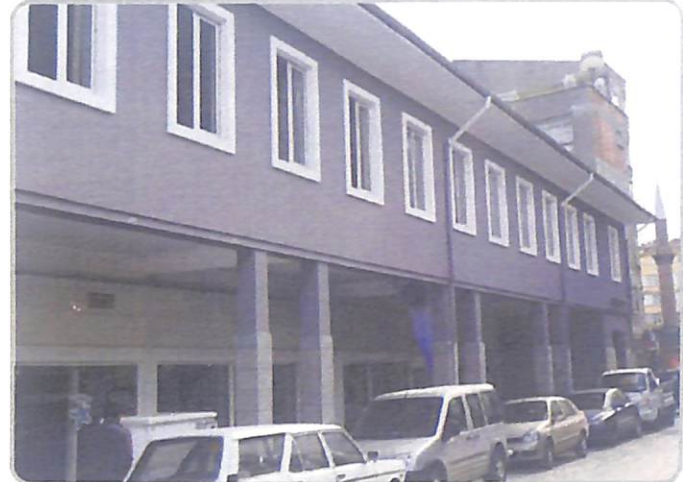
Yeni Çarşı Onarımı İşi Çalışmaları
