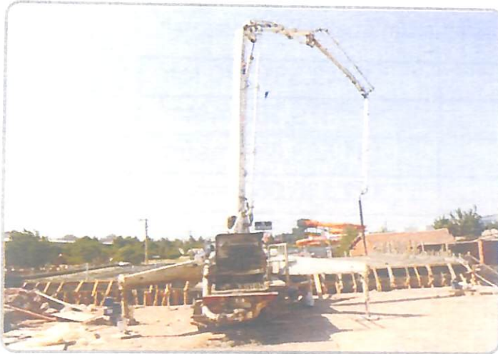
Emniyet Kavşağı-Kepsut Caddesi Bağlantı Köprüsü Yapım Çalışmaları
