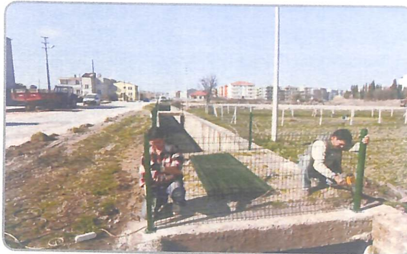
Plevne Mahallesi Dere Boyuna Tel Çit Yapılması Çalışması
