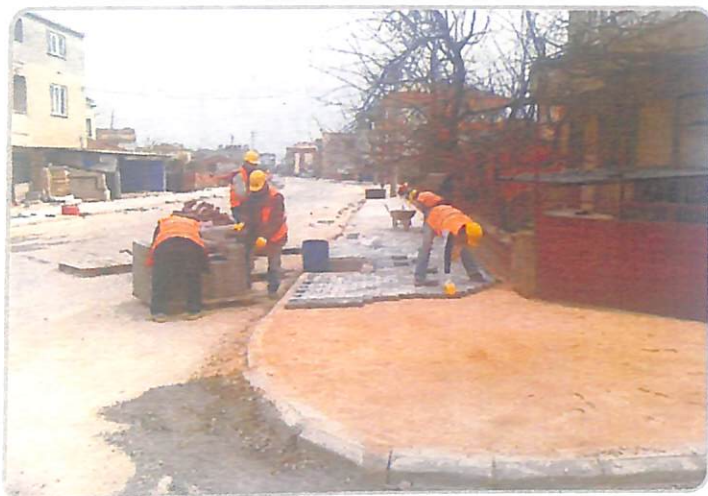
Ergüven Caddesi Yol ve Kaldırım Yapım Çalışmaları
