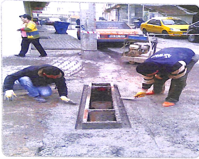
Yağmur Izgara Yapımı
