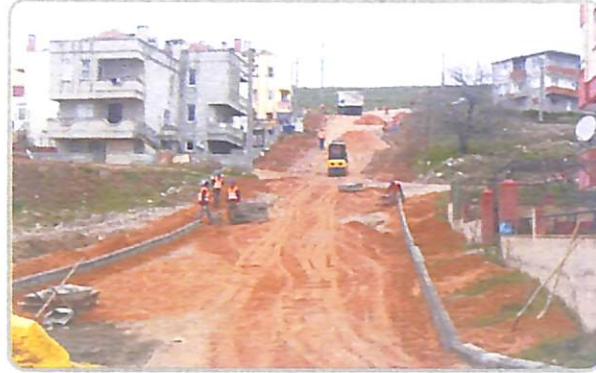
Sefaköy Mahallesi Yol Yapımında PMT Malzeme Serilmesi
