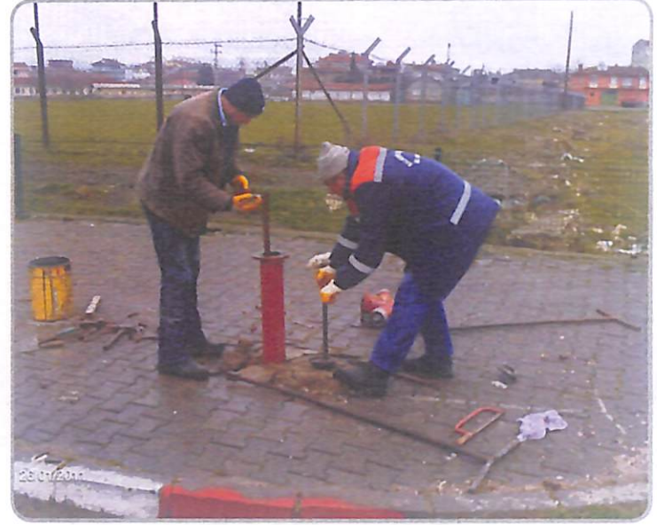
Yangın Hidrant Tamirâtı
