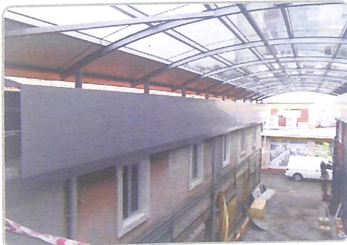
Yeni Çarşı Onarımı İşi Çalışmaları
