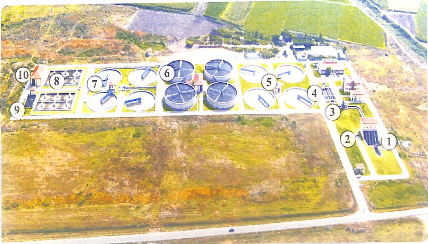
Atıksu Arıtma Tesisi
