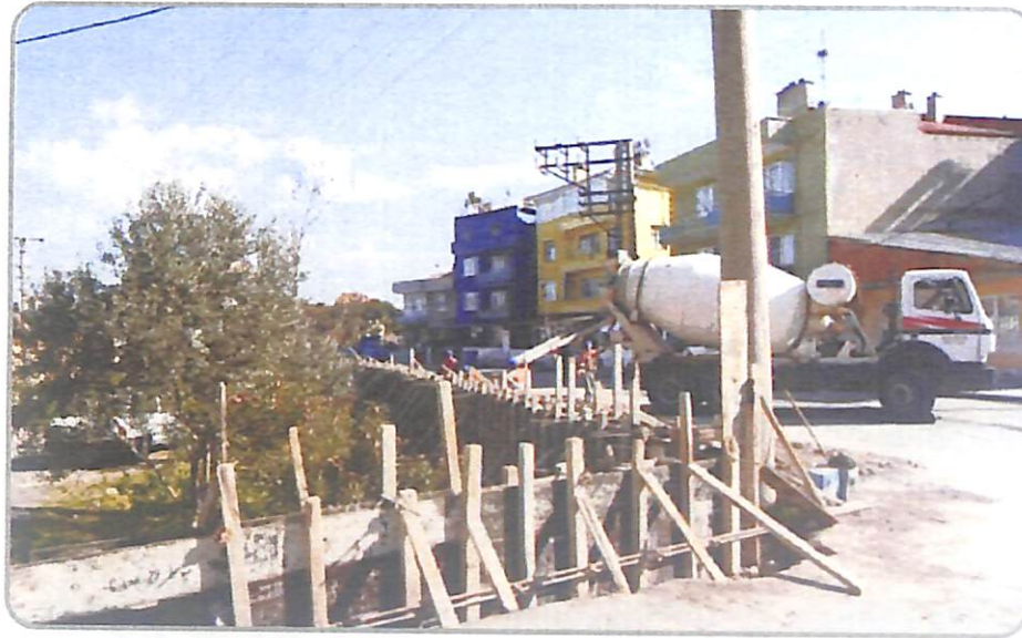
Söğüt Mahallesi Dere Boyu İstinat Duvarı Yapılması
