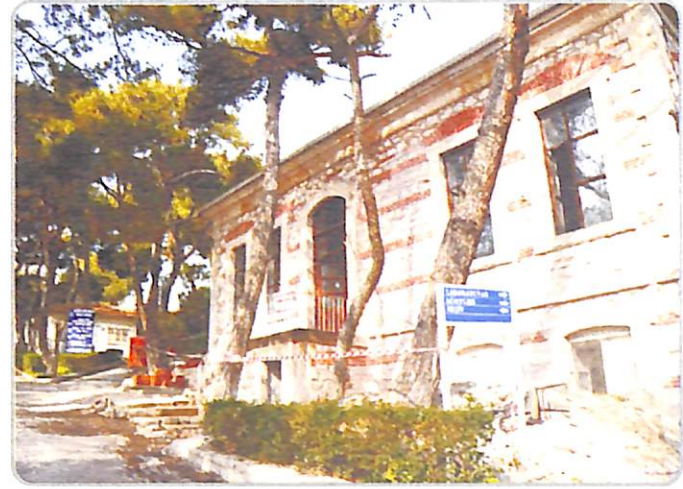
Merkez Göğüs Hastalıkları Hastanesi Restorasyonu Çalışmaları
