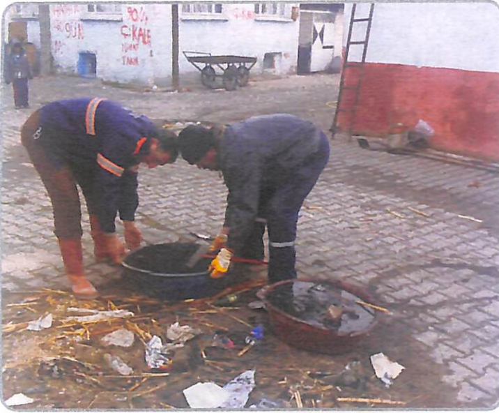
Gümüşçeşme Mah. Kanalizasyon Baca Temizliği
