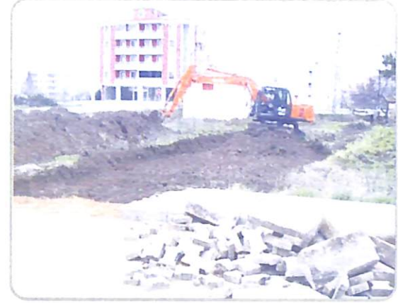
Plevne Mahallesi Yol Açma Çalışmaları
