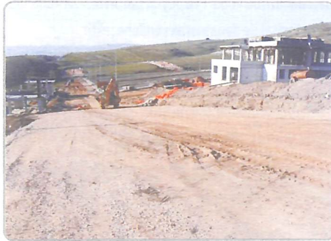
Yeni Mezarlık Yapım Çalışmaları
