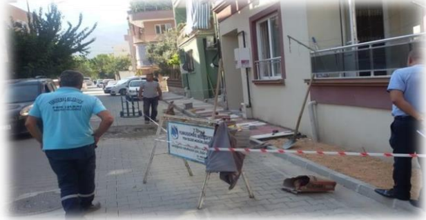
Kaldırım Parke Taşı Döşeme Saha Kontrolü
