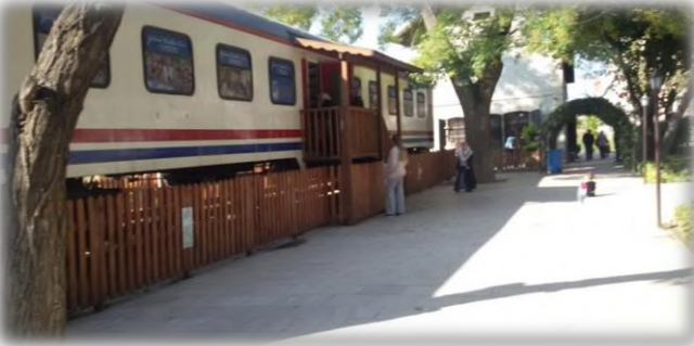
Horozköy Tren Garı Önüne Çit Saha Kontrolü
