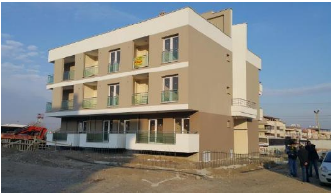
SEVİYE TESPİT KONTROLÜ
