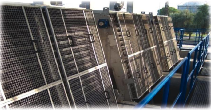
Şekil 3. Izgara Yapısı
