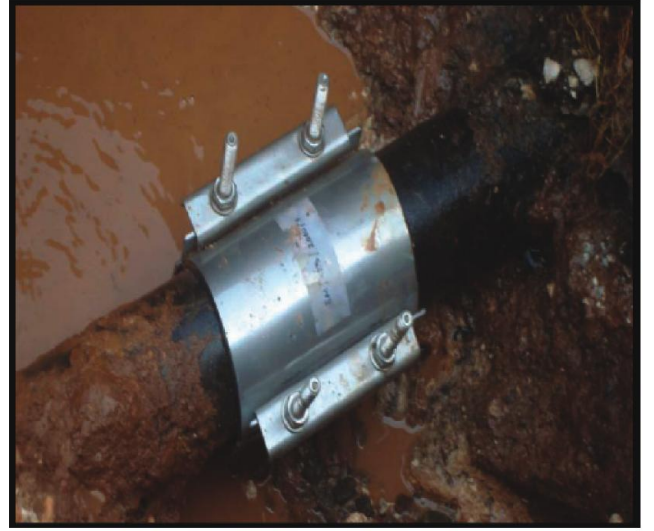
Yukarıdaki resimde Güvenevler Mahallesinde 1941 sokakta 125'lik PİK boruda yaklaşık 6 cm'lik yarıлма vardı, arıza tamir takımı takılarak giderildi.
