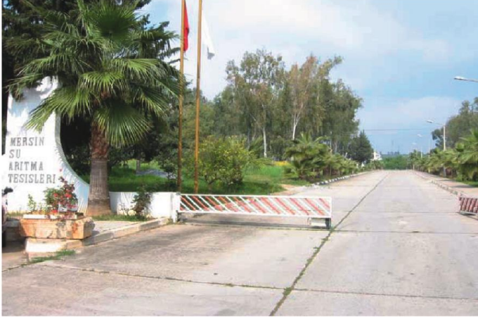
Şekil 21. Berdan İçmesuyu Arıtma Tesisi
