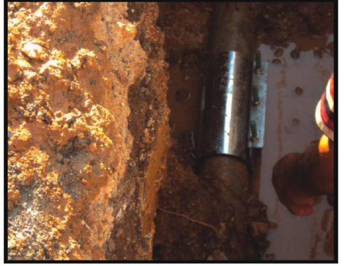
Yukarıdaki resimde Çukurova Mahallesiinde 85061 sokakta 100 AÇB boruya tamir takımı atıldı.
