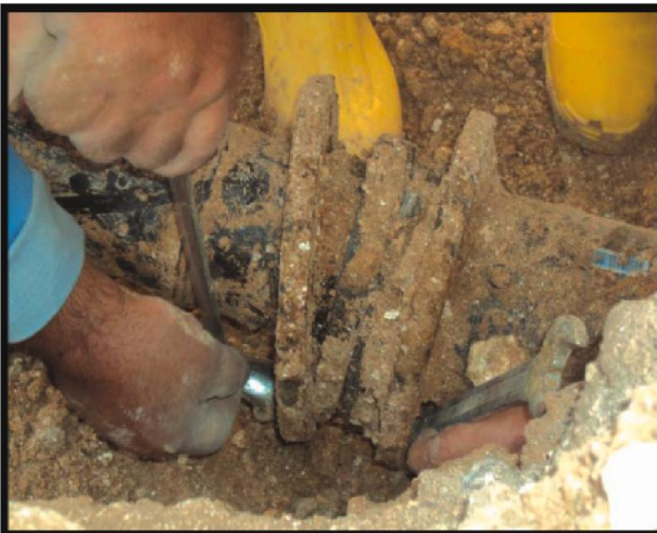
Yukarıdaki resimde Yenimahalle 5326 sokakta 100'lük pik boruda muf bağlantısındaki kurşun atmıştır. Arıza bağlantı yerine kurşun çakılarak giderilmiştir.
