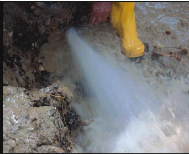
Yukarıdaki resimde Yenimahalle 5326 sokakta 100'lük pik boruda muf bağlantısındaki kurşun atmıştır. Arıza bağlantı yerine kurşun çakılarak giderilmiştir.
