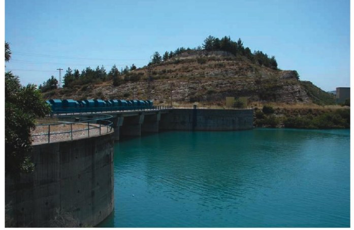
Şekil 23. Berdan Baraj Kapakları
