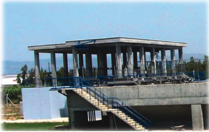
Şekil 3. Izgara Yapısı
