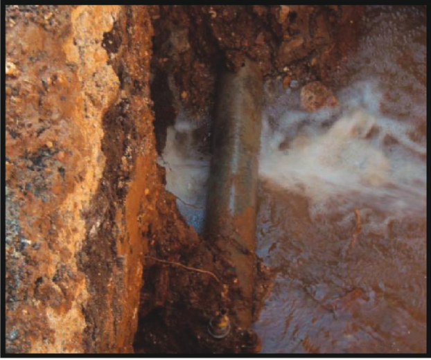
Yukarıdaki resimde Çukurova Mahallesiinde 85061 sokakta 100 AÇB boruya tamir takımı atıldı.
