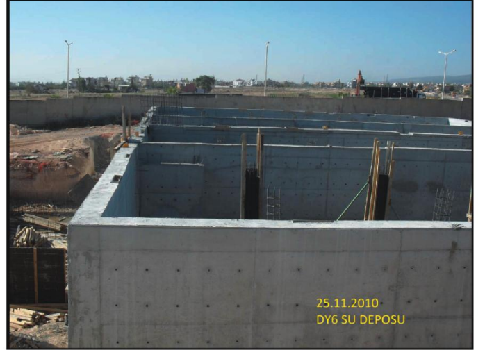
DY6 su deposu inşaat çalışması
