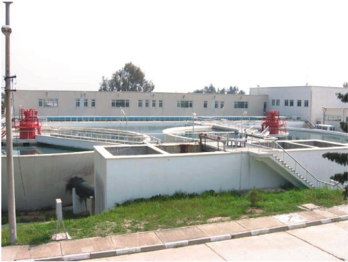
Şekil 22. Berdan İçmesuyu Arıtma Tesisi Genel Görünüm
