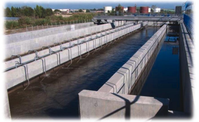
Şekil 5. Havalandırmalı Kum ve Yağ Tutucu
