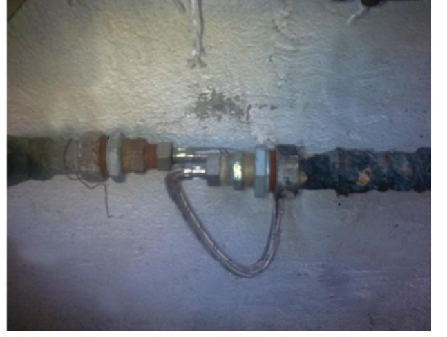
Resim.2. İllegal Kaçak görüntüsü
