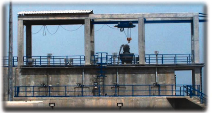
Şekil 10. Geri Devir Pompa İstasyonu
