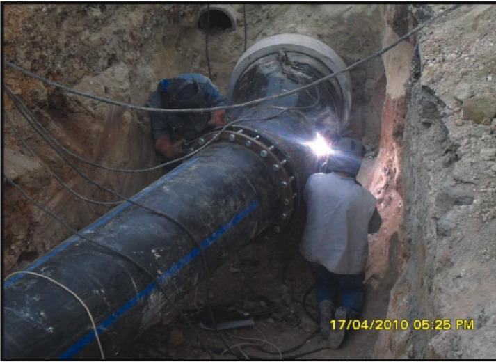
Çelik boru kaynağı
