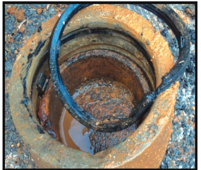
Yukarıdaki resimde Çukurova Mahallesiinde 85061 sokakta 100 AÇB boruya tamir takımı atıldı.
