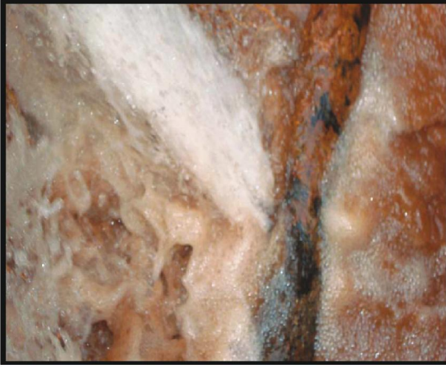
Yukarıdaki resimde Güvenevler Mahallesinde 1941 sokakta 125'lik PİK boruda yaklaşık 6 cm'lik yarıлма vardı, arıza tamir takımı takılarak giderildi.
