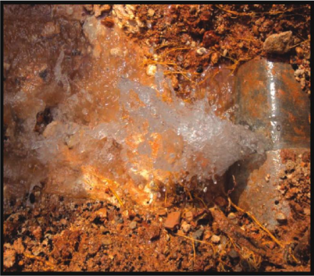
Yukarıdaki resimde Çukurova Mahallesiinde 85061 sokakta 100 AÇB boruya tamir takımı atıldı.
