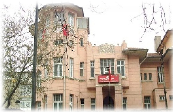
Demirtepe Ek Hizmet Binası
