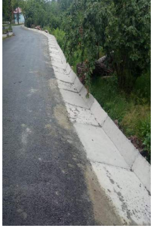
Çavuşlar Mahallesi - Burhanettin Mahallesi Sarıkaş Sokak Bağlantı Yolu Beton Yol- V Kanal Çalışması İlk/Son Hali
