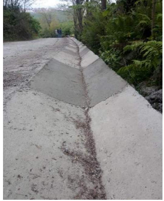
Yukarıtepe Mahallesi Kargatepesi Sk. Beton Yol ve Beton Hendek Kaplama (V Kanal) Çalışması
