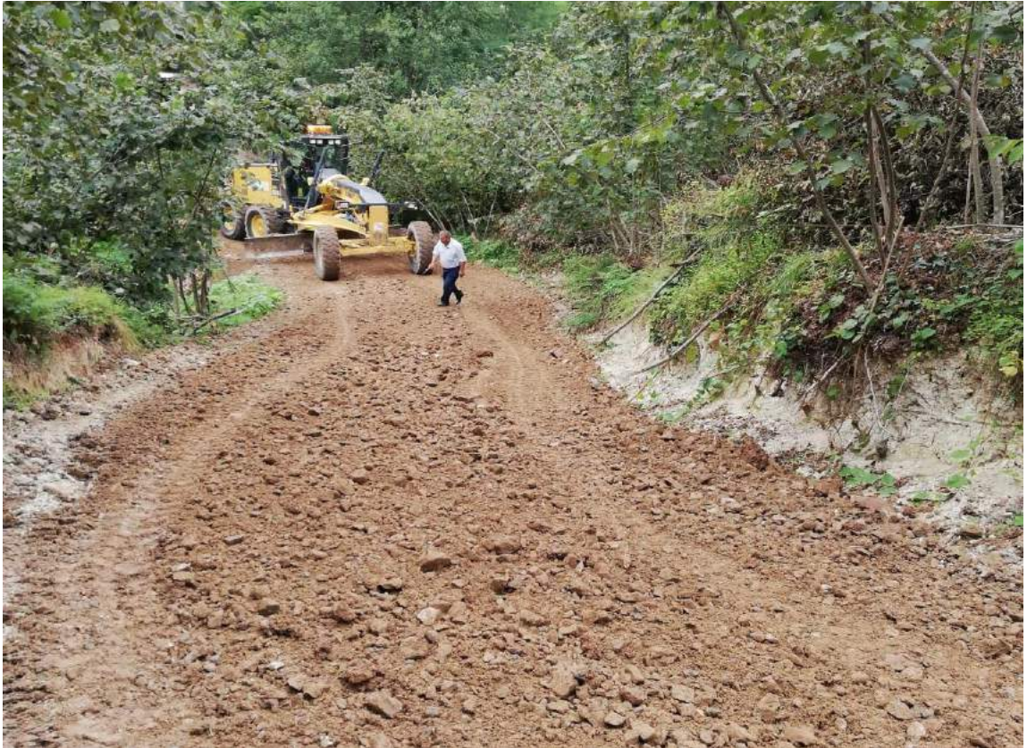
Altınyurt Mahallesi Yol Bakım-Onarım Çalışması
