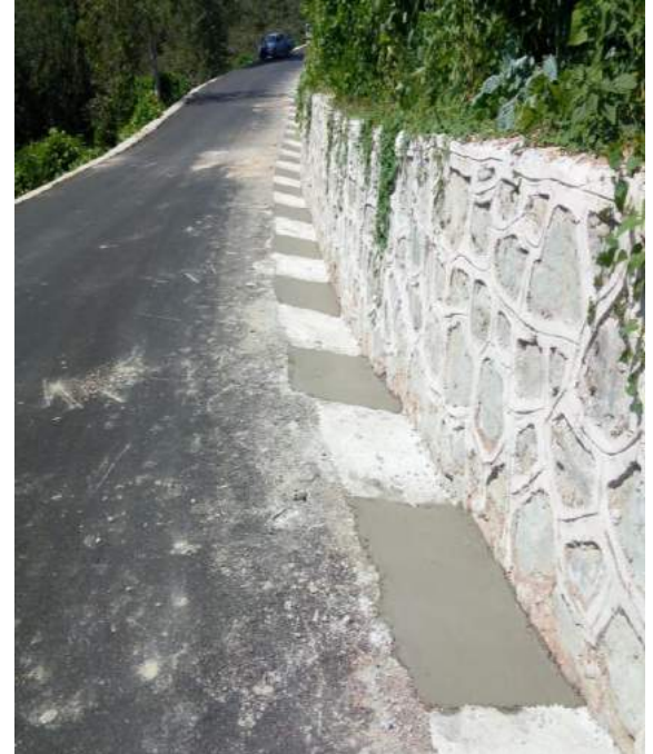
Teyneli Mahallesi Akkese Mahallesi Bağlantı Yolu Beton Yol ve Beton Hendek Kaplama (V Kanal) Çalışması İlk/Son Hali
