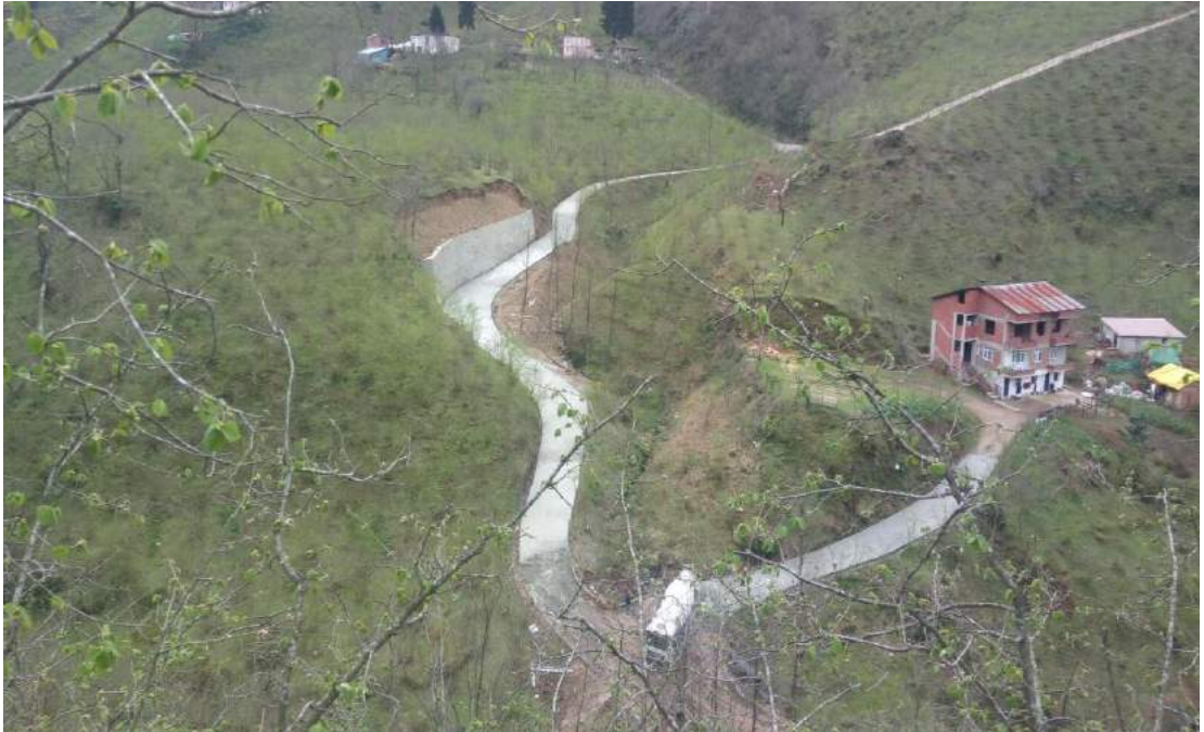
Saraycık Mahallesi Değirmenyanı Sokak Beton Yol Yapım İşİ İlk / Son Hali
