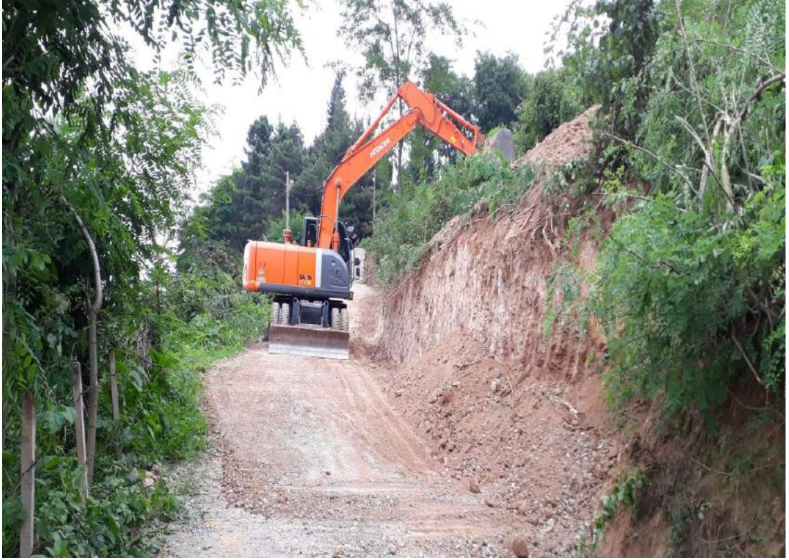
Kayabaşı Mahallesi Yol Genişletme Çalışması
