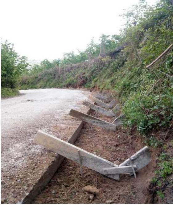
Yukarıtepe Mahallesi Kargatepesi Sk. Beton Yol ve Beton Hendek Kaplama (V Kanal) Çalışması
