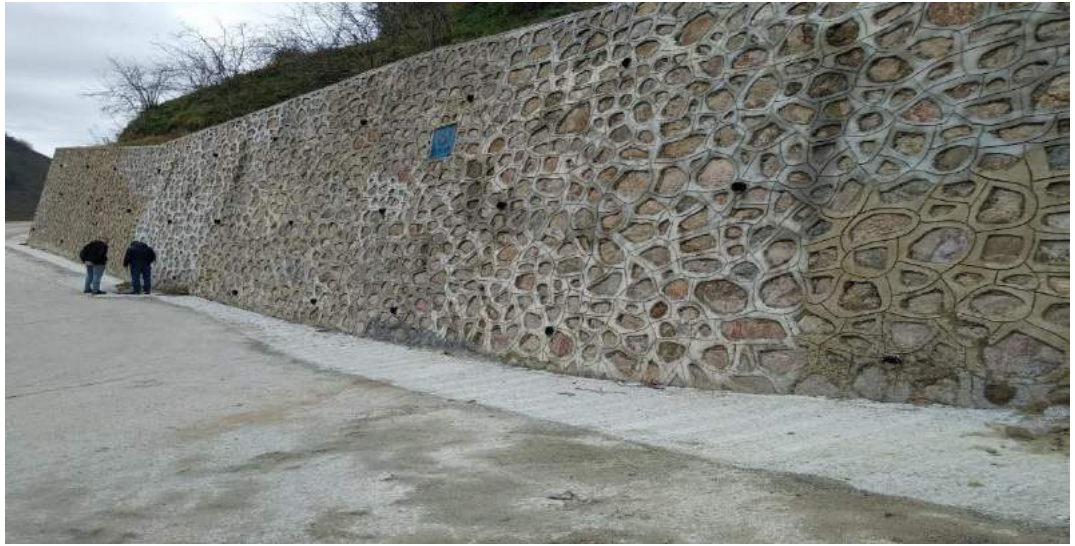
Şenocak Mahallesi Çilekli Sokak Moloztaş Duvar Yapım İşi
