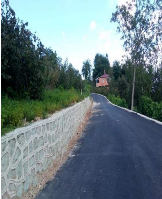
Teyneli Mahallesi Akkese Mahallesi Bağlantı Yolu Beton Yol ve Beton Hendek Kaplama (V Kanal) Çalışması İlk/Son Hali
