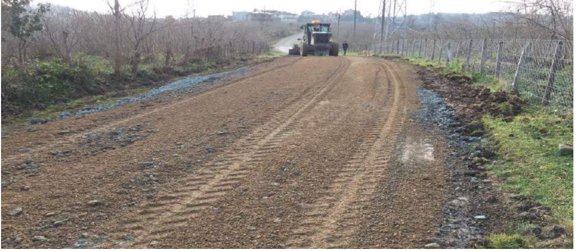
Uzunisa Mahallesi Yol Bakım-Onarım Çalışması
