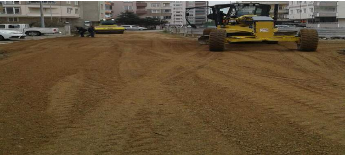
Karşıyaka Mahallesi Yol Bakım-Onarım Çalışması
