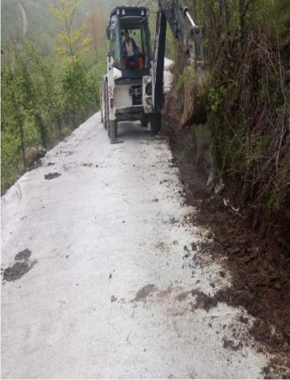
Akçatepe Mahallesi Dervişli Sokak Beton Yol- V Kanal Çalışması İlk/Son Hali
