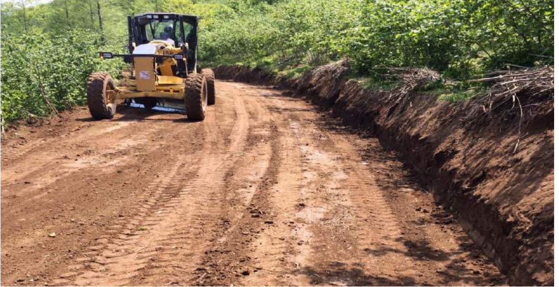
Karaoluk Mahallesi Yol Bakım-Onarım Çalışması
