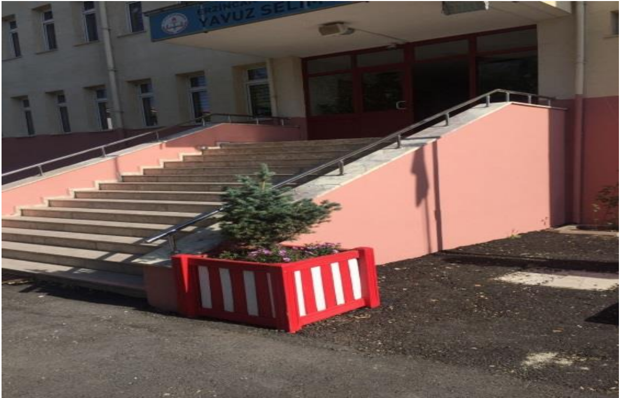
Erzincan Merkez Yavuz Selim İlkokulu Onarım İşi
