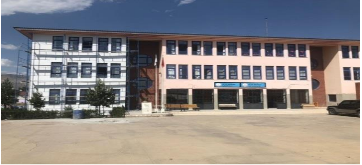
Erzincan Merkez Ulular 75.Yıl Bayrak Ortaokulu Onarım İşi
