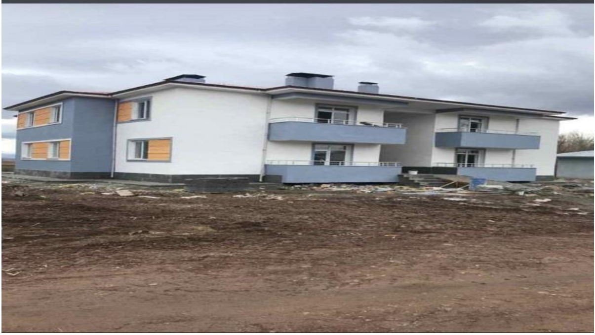
Erzincan Tercan İlçesi Çadirkaya Köyü 7 Daireli Öğretmen Konutu Yapım İşi
