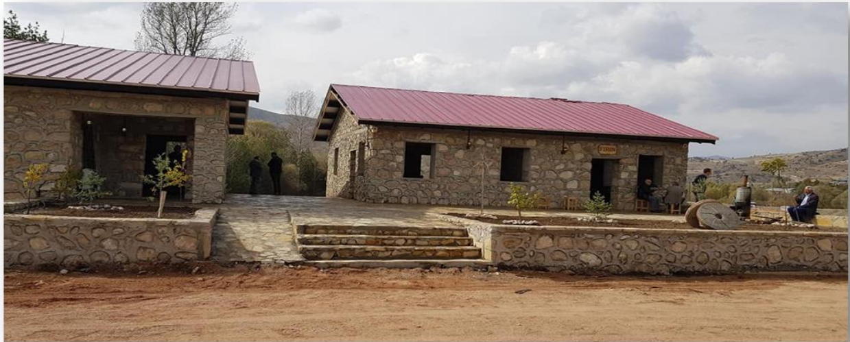
Erzincan Refahiye İlçesi Kayı Köyü 1 Adet Su Değirmeni Ve 1 Adet Fırın Yapım İşi
