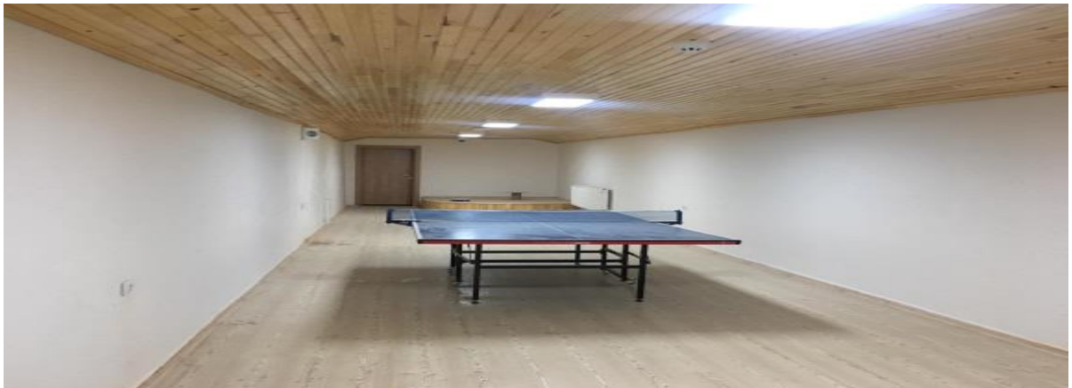
Erzincan Merkez Tamer Meriç Orta Okulu Onarım İşi
