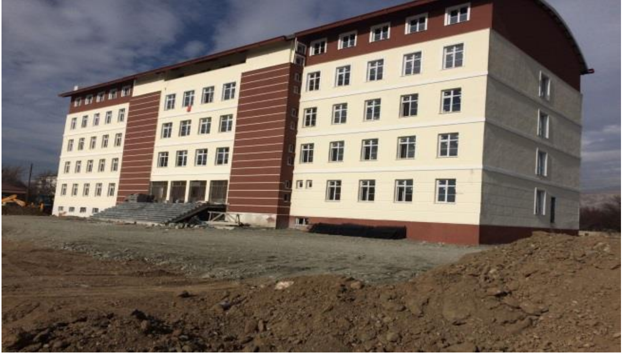
Erzincan Kavakolu 16 Derslikli Ortaokulu Yapım İşi
