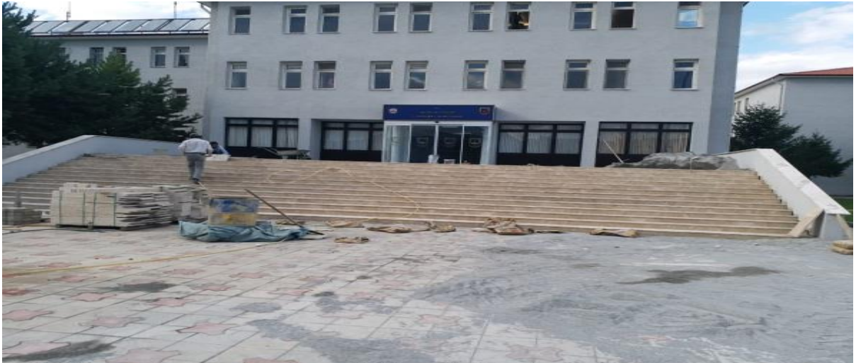
Erzincan İl Jandarma Komutanlığı Hizmet Binası Giriş
