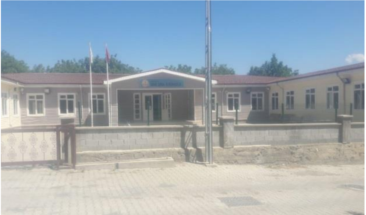
Erzincan Yalnızbağ İbni Sina İlkokulu Onarım İşi
