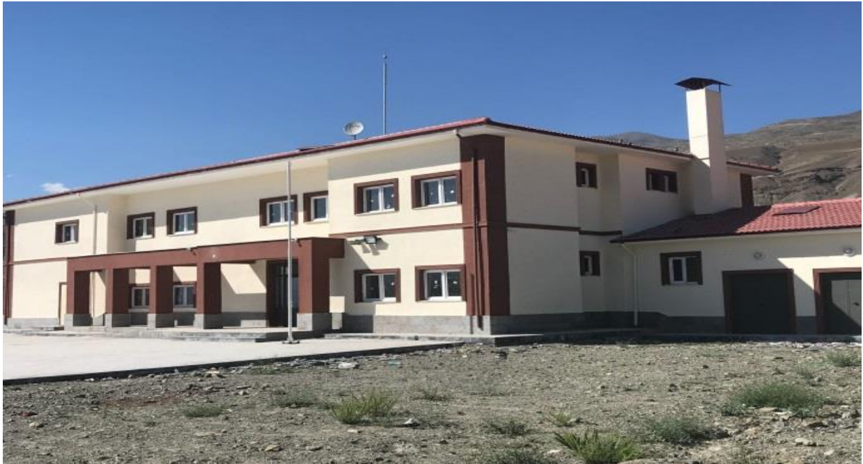
Günebakan Köyü 4 Derslikli İlkokul Binası Yapım İşi
