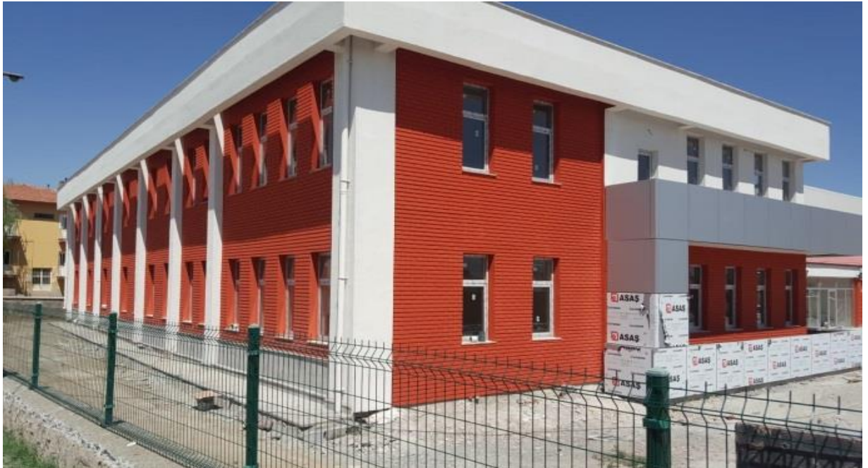
Atatürk Mesleki ve Teknik Anadolu Lisesi Spor Salonu ve Atölye Binası Yapım İşi
