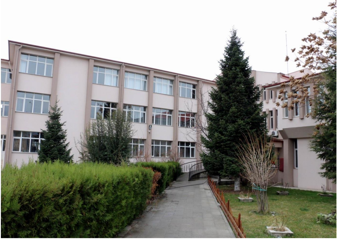
İl Özel İdaresi Hizmet Binası
