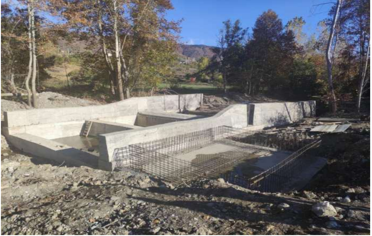
Taşova Yayladibi Sulama Tesisi Su Alım Yapısı Yapım Çalışması
