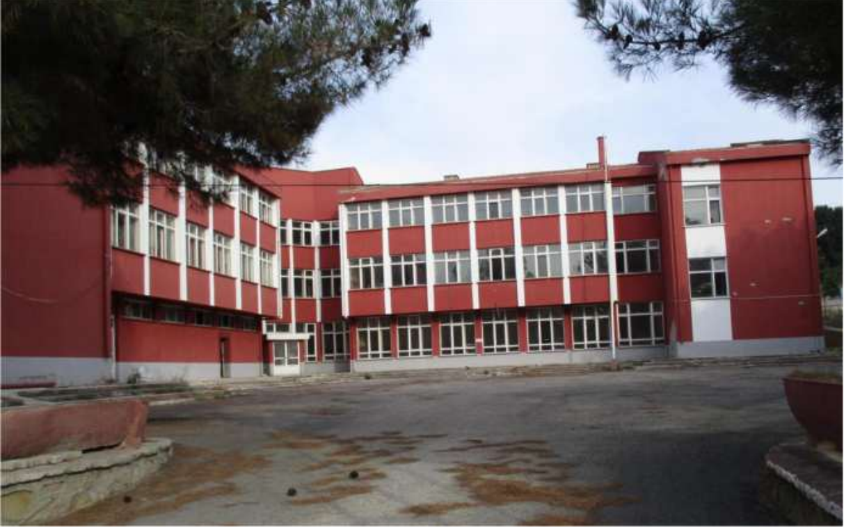
Suluova Eski Çeltekte Kirada Bulunan Binamız.
