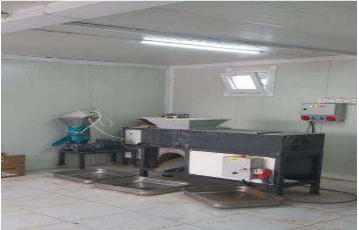
Sokak Hayvanları Mama Üretim Tesisi
