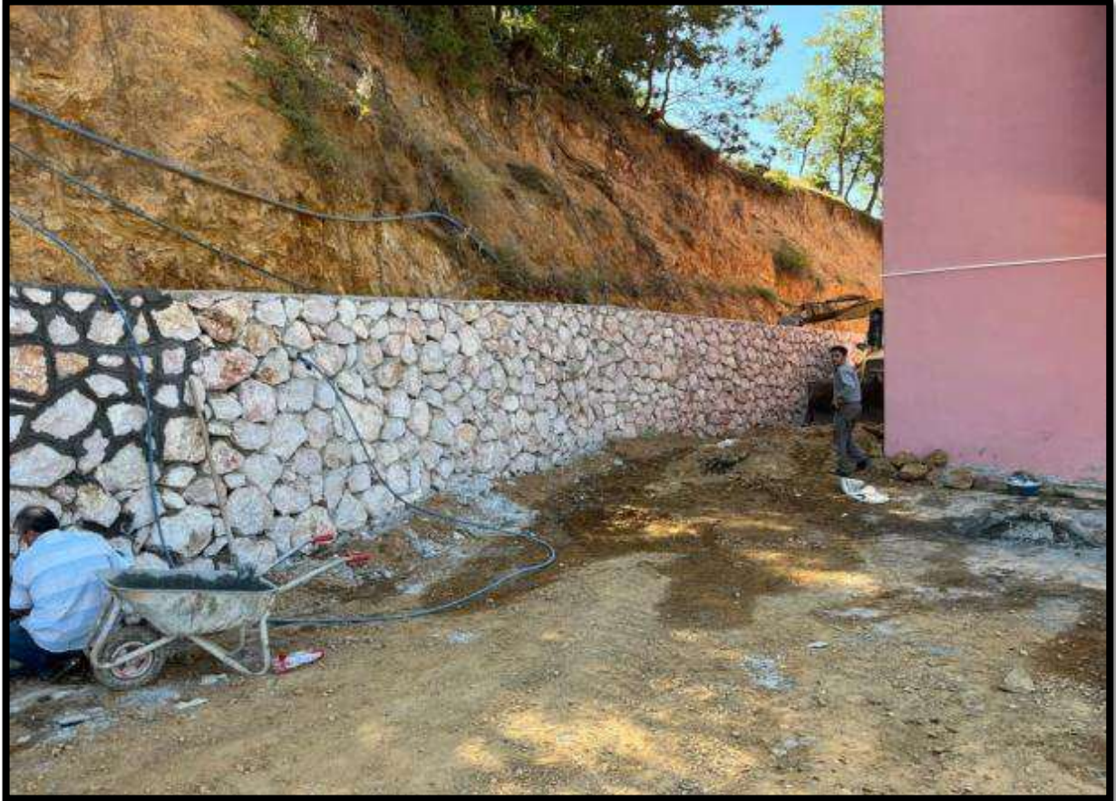
Merkez Abacı Köyü CemevinenYapılan Bakım Ve Onarımlar
