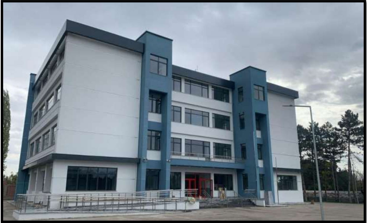
42.461.000,00 TL Bedelle İhale Edilen Suluova Ş. Aydın Korkmaz 20 Derslikli İlkokul Yapım İşi, Zemin Güçlendirme ve Grobeton İmalatından Sonra Feshedilerek 67.400.000,00 TL Bedelle Yeniden İhale Edilmiştir. Yapım İşi Tamamlanarak Geçici Kabulü Yapılmıştır.
