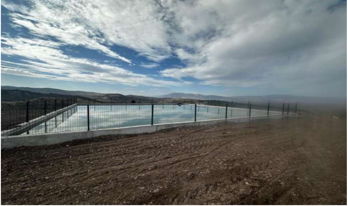
Göynücek Ayvalıpınar Köyü YAS Sulama Tesisi Havuzu
