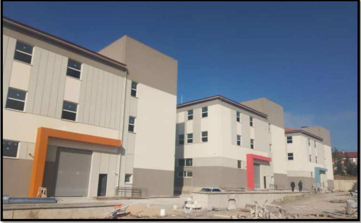
Suluova'da 99.826.327,00 TL Sözleşme Bedeli İle İhale Edilen Elektrik, Metal Ve Mobilya Atölyeleri Yapım İşi Tamamlanmış Olup Geçici Kabul Aşamasındadır.
