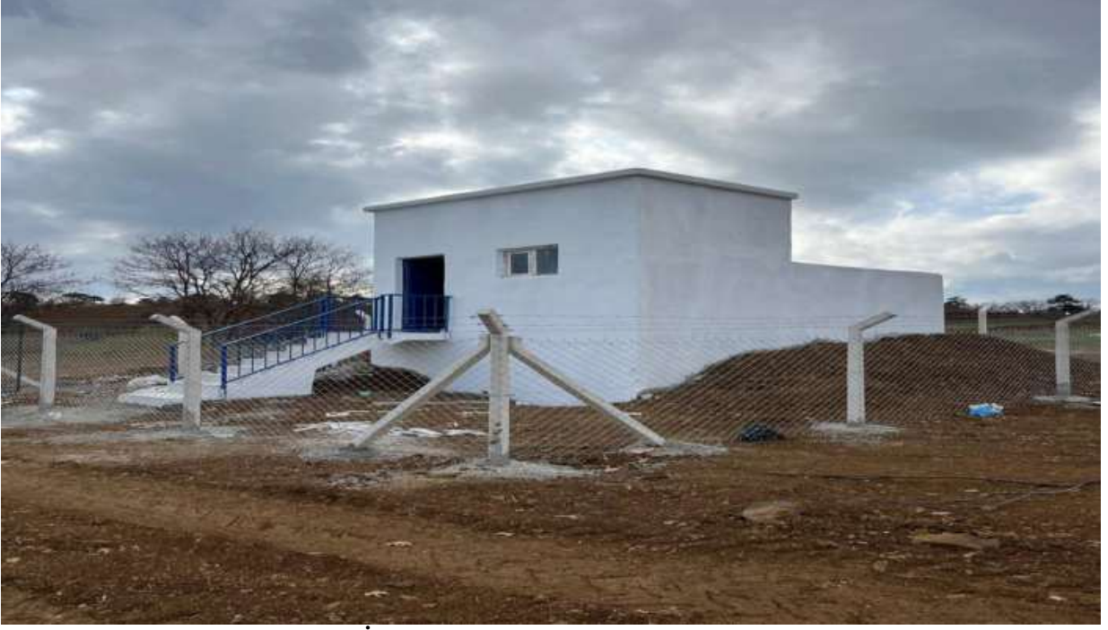
Amasya Merkez Ardıçlar Köyü İçme Suyu Deposu
