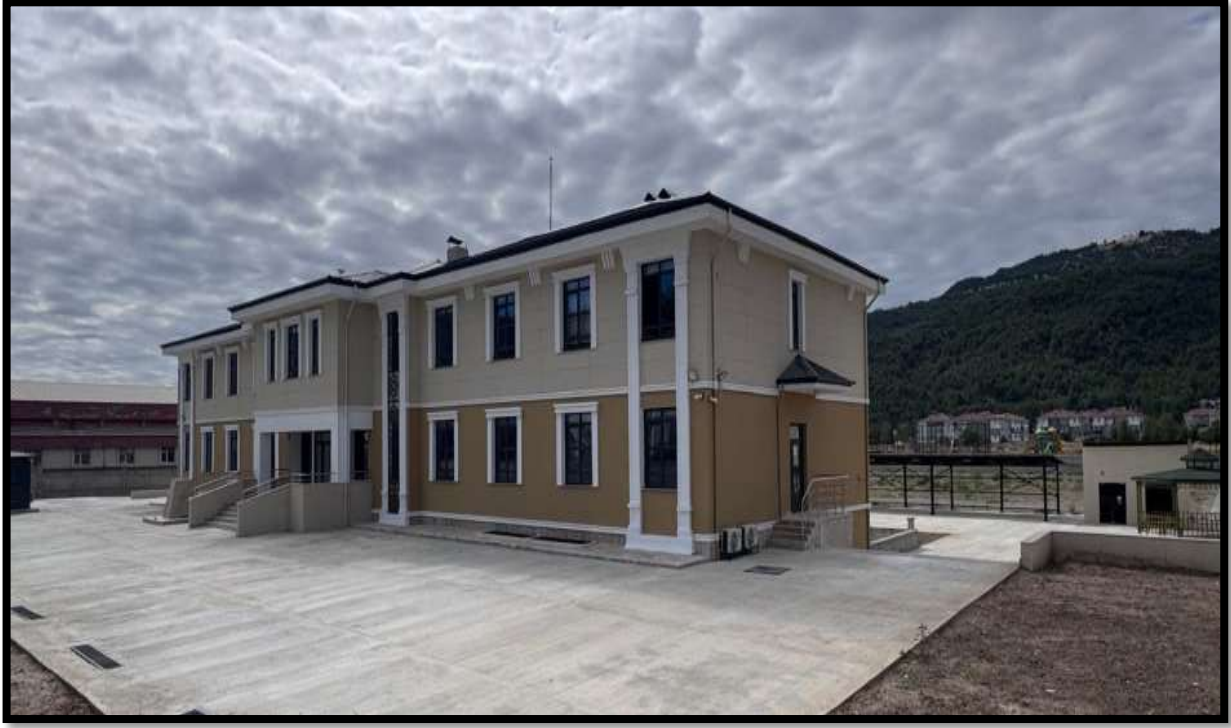
Taşova'da 52.450,000,00 TL Sözleşme Bedeli İle İhale Edilen Taşova Jandarma Hizmet Binası Yapım İşi Tamamlanarak Geçici Kabulü Yapılmıştır.
