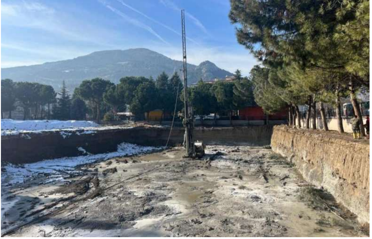
Amasya Merkez’de 101.066.000,00 TL bedelle ihale edilen 24 Derslikli Anadolu Lisesi yapım işinin yer teslimi yapılmış, zemin güçlendirme çalışmalarına başlanmıştır.
