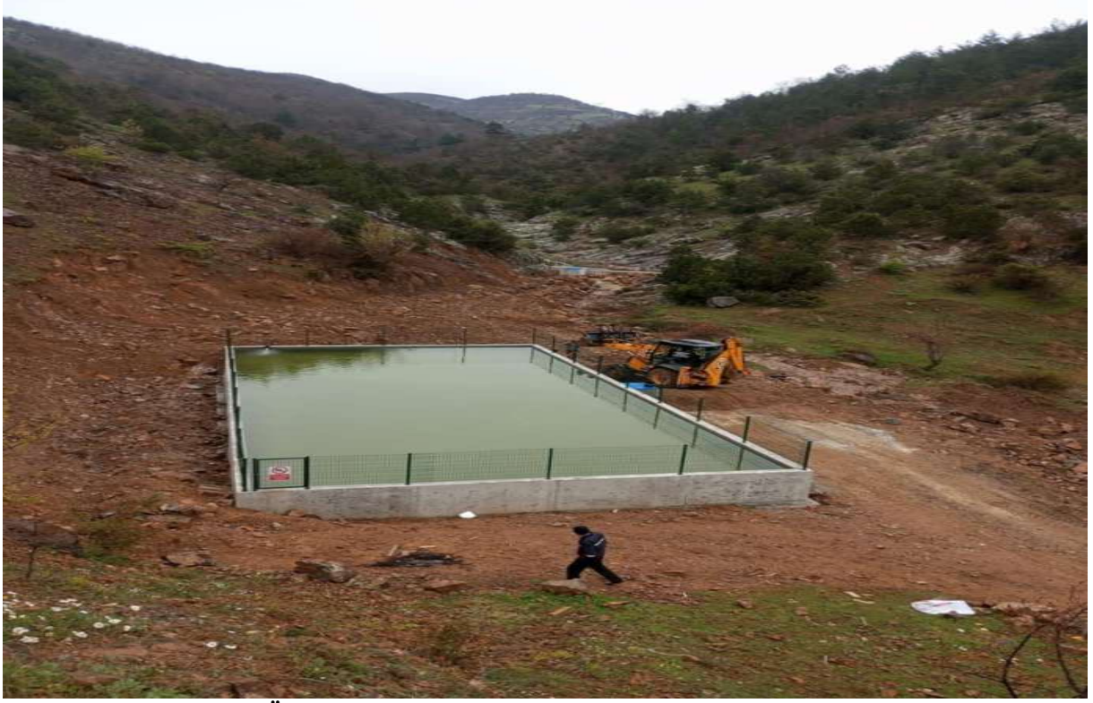
Merkez Halifeli Köyü YÜS Sulama Tesisi Havuzu
