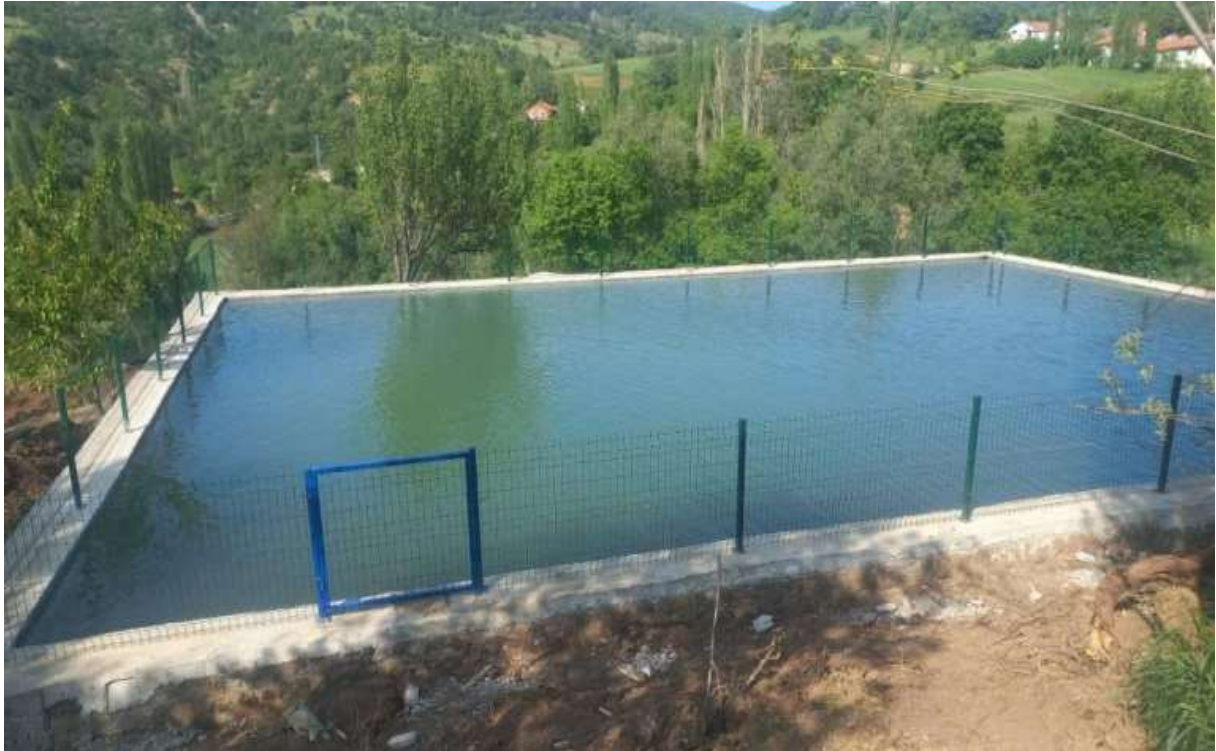
Merkez Böke Köyü YÜS Sulama Tesisi Havuzu
