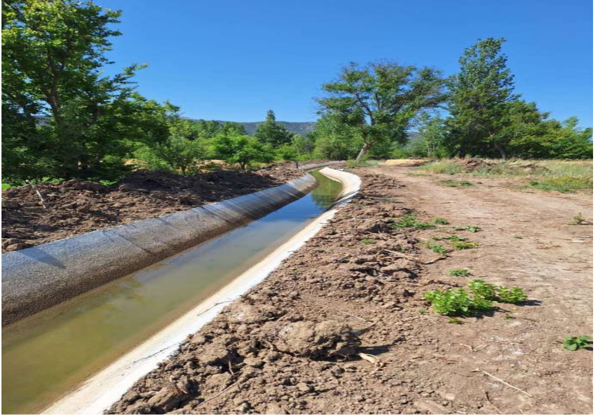
Göynücek Karaşar Köyü Sulama Tesisi Beton Kanalı
