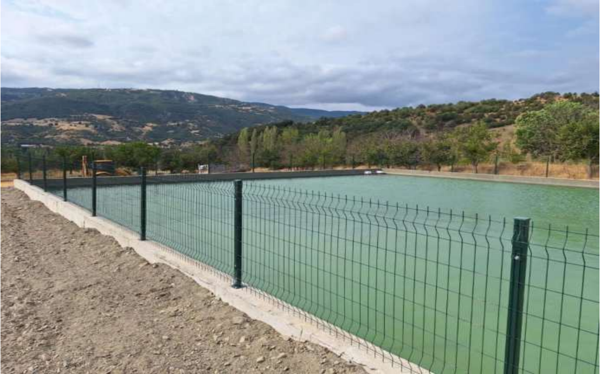
Merkez Kaleköy YAS Sulama Tesisi Havuzu
