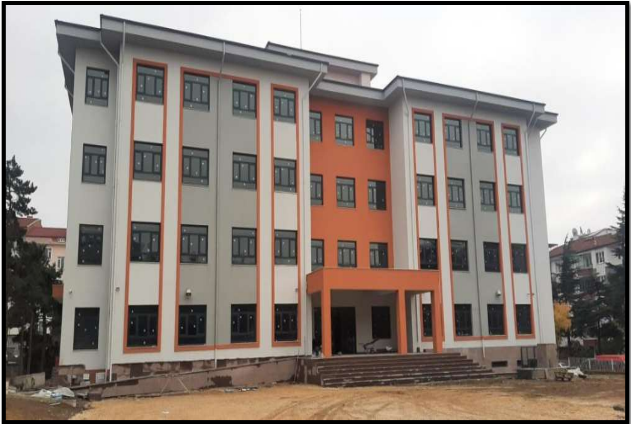
Merzifon'da 77.861,000,00 TL Sözleşme Bedeli İle İhale Edilen Merzifon 24 Derslikli Mesleki Teknik Lise Yapım İşi, % 96,49 Seviyesinde Devam Etmektedir.
