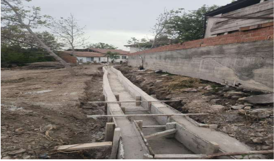
Merzifon Saraycık Köyü Sulama Tesisi Beton Kanalı
