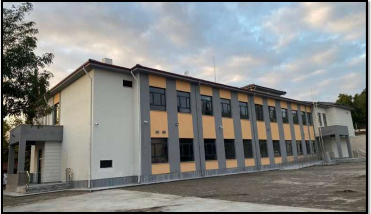
Taşova Uluköy'de 33.333,000,00 TL Sözleşme Bedeli İle İhale Edilen Yapım İşi Tamamlanarak Geçici Kabulü Yapılmıştır.
