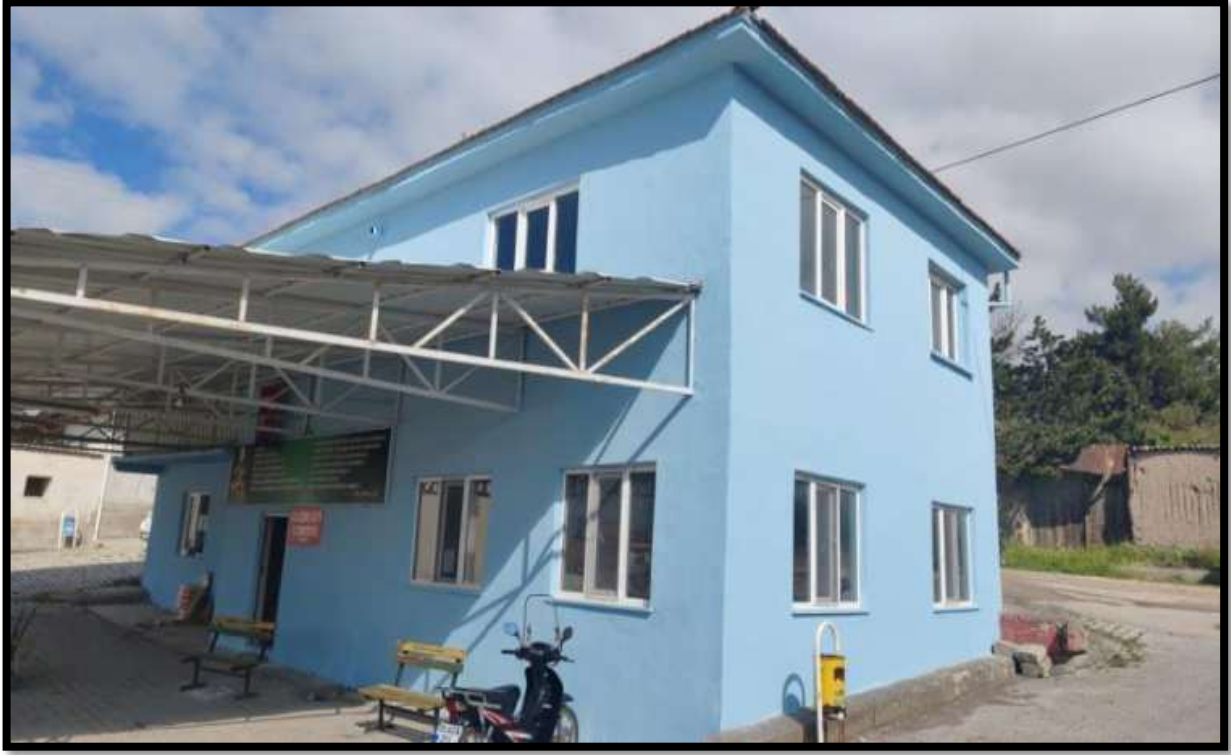
Merzifon Karatepe Köyü Cemevine Yapılan Bakım Ve Onarımlar
