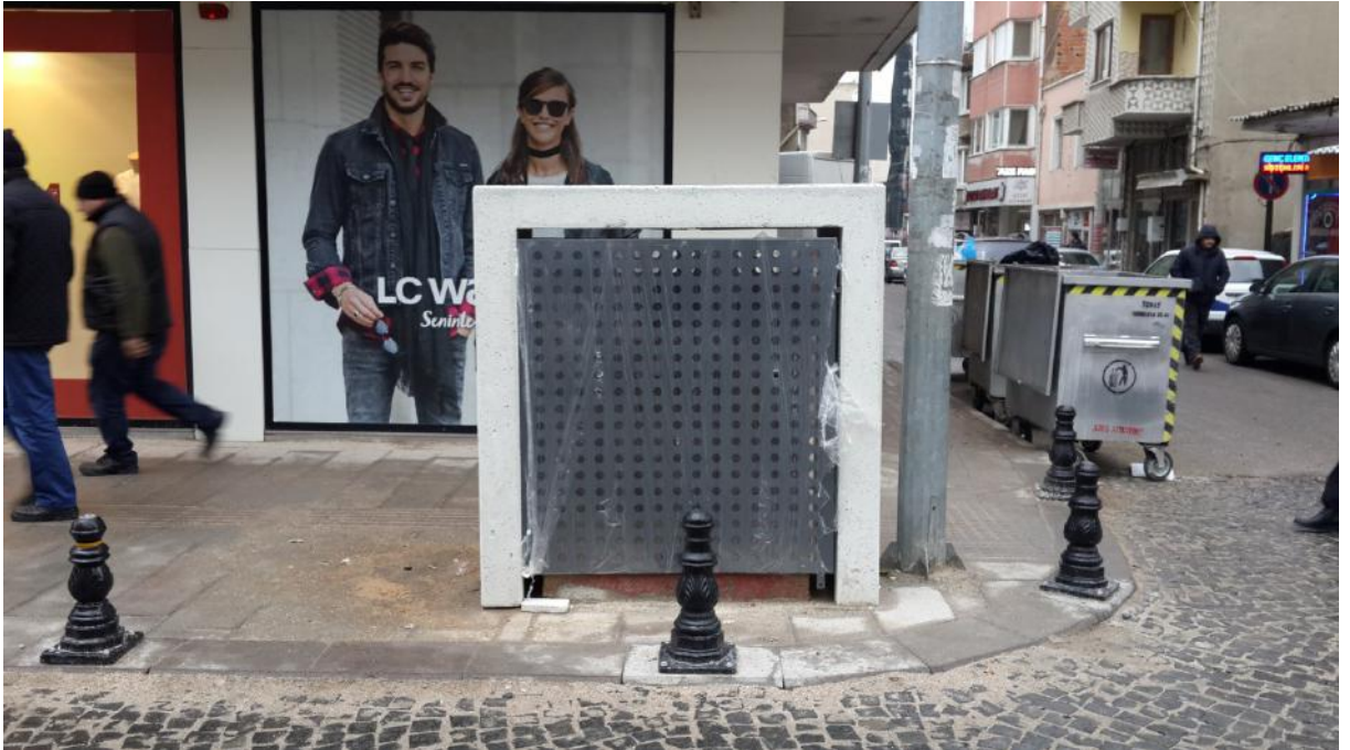
Fevzi Çakmak Caddesi'nden Kareler Prekast Cephe Panelleri ile Trafo Kapatmaları
