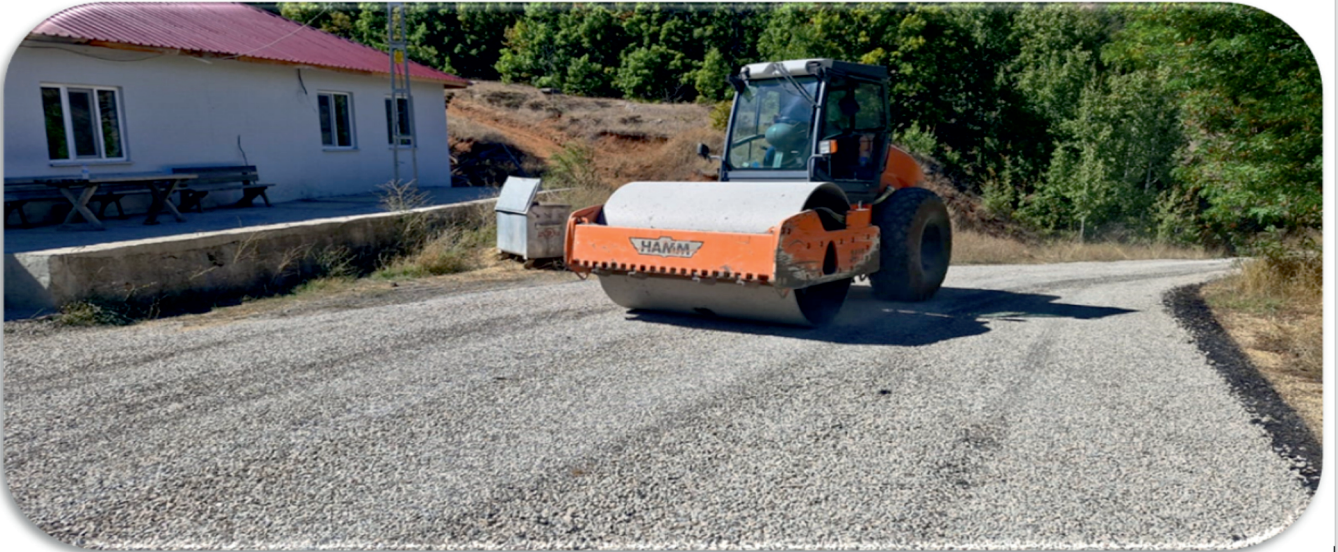
Pülümür ilçemiz Salördek Mezramızın 3 KM yolunun 1. Kat Asfalt Sathi Kaplaması Tamamlanmıştır.
