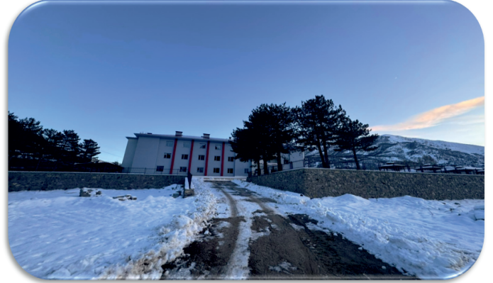
Pülümür İlçesi 24 Üniteli Vardiya Yatakhane
