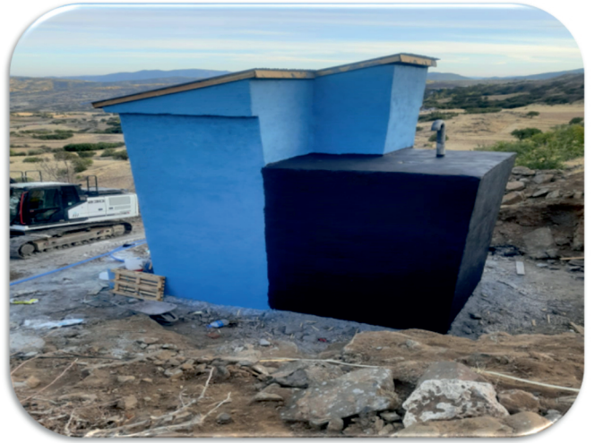
Pınarlar Köyü İçme Suyu Deposu
