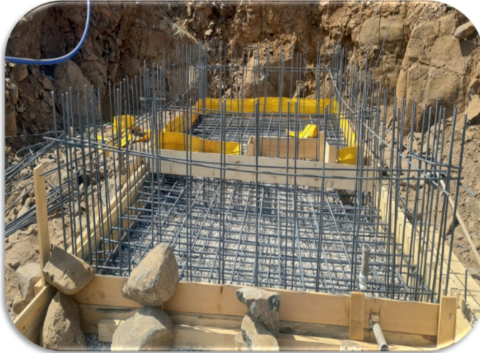
Pınarlar Köyü İçme Suyu Depo İnşaatı
