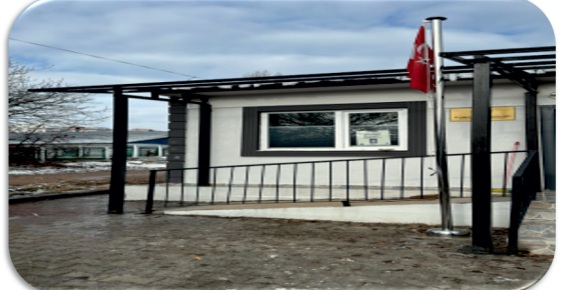
Prefabrik Muhtarlık Ofisi
