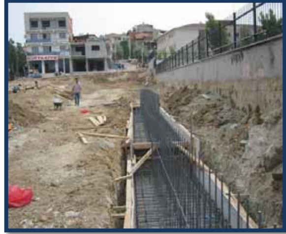
İnönü Mahallesi İstinat Duvarı
