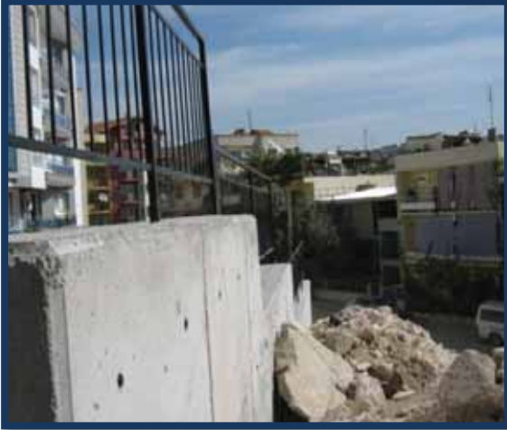
1083 Sokak İstinat Duvarı
