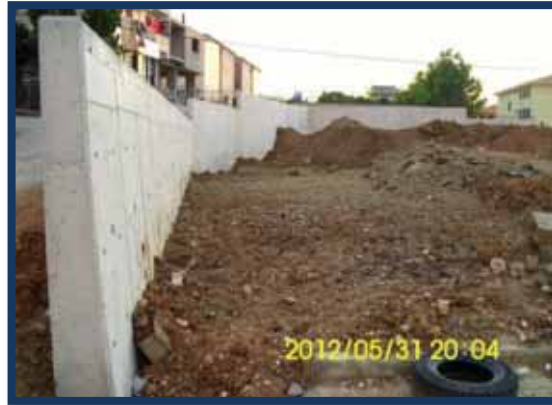
İnönü Mahallesi İstinat Duvarı
