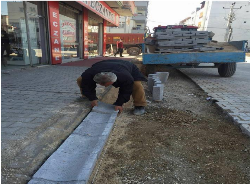
Yol ve Kaldırım çalışmaları
