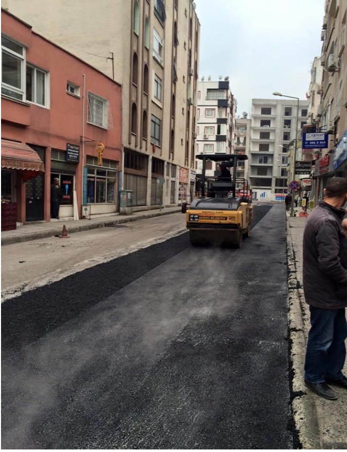
Asfalt yama ve kaplama çalışmaları
