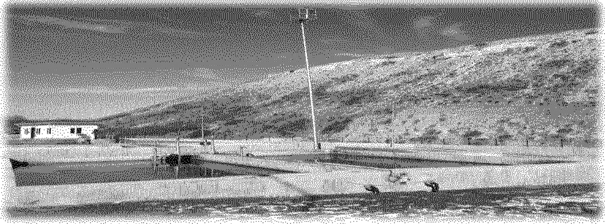
Yeşilhisar Atıksu Arıtma Tesisi
