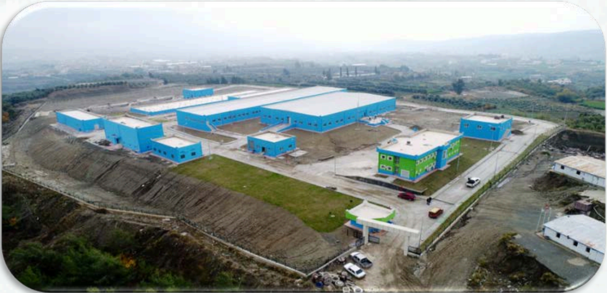
Karaçay İçme Suyu Arıtma Tesis
