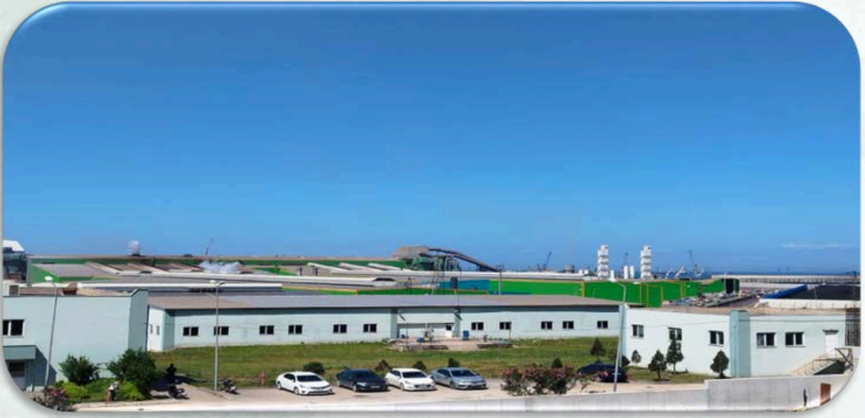
İskenderun İçme Suyu Arıtma Tesis
